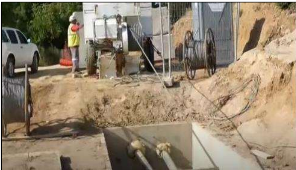
Figura 10: Equipo mecánico de tiro, cabestrante (winche). en la empresa Iberdrola. España 2014.
