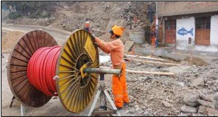
Figura 21: Trabajos de tendido de cable subterráneo en la empresa TEYCONSA S.R.L. San Juan De Lurigancho (2019).
