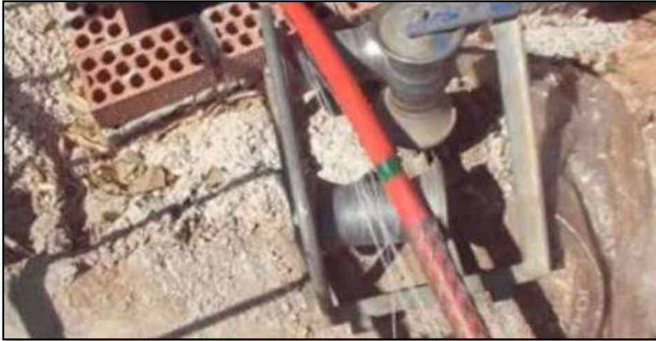
Figura 16: Rodillos triples, ubicación: entrada y salida de buzones.
