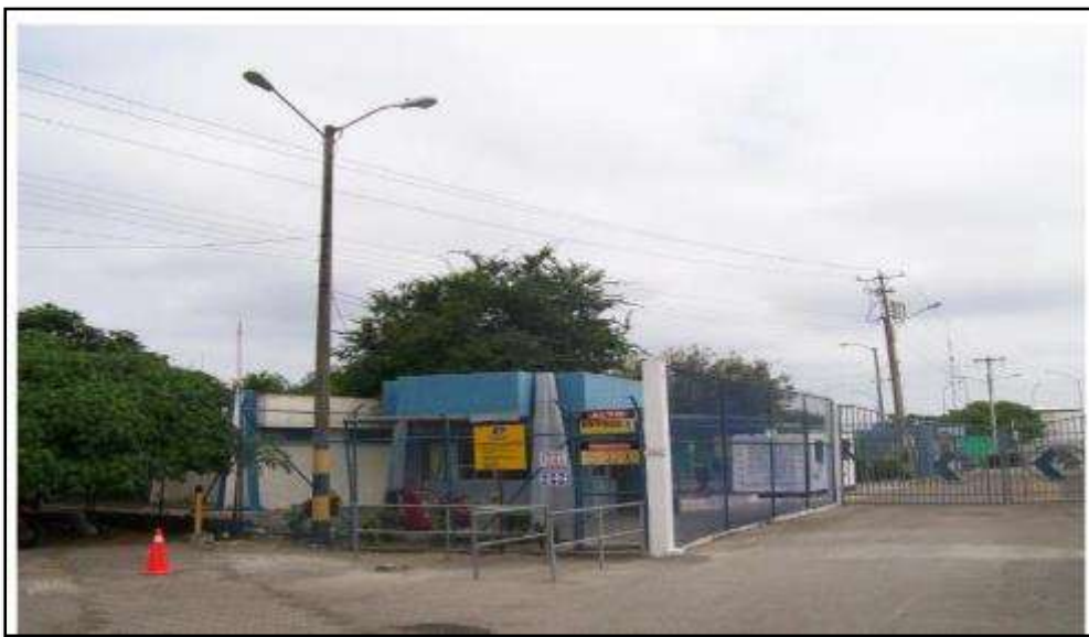
Figura 17: Garitas y árboles en peligro por redes eléctricas aéreas. Ecuador 2014.
