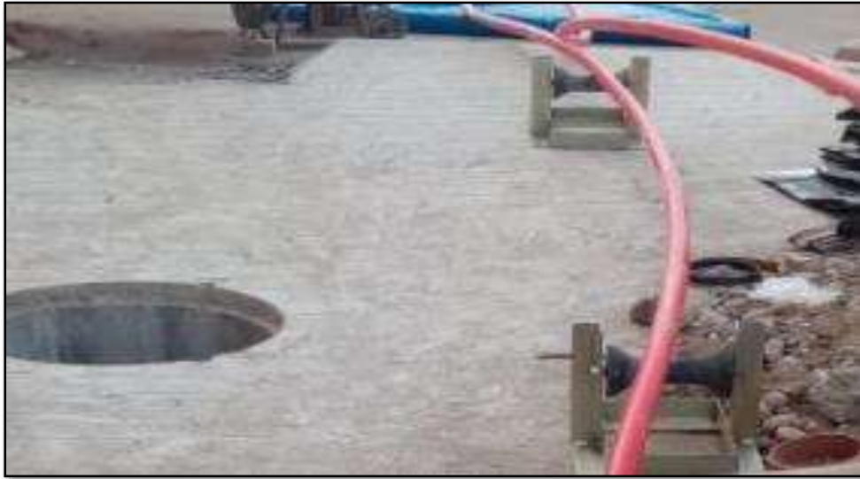
Figura 13: Rodillos rectos para evitar el rozamiento del cable contra el piso o zanja.
