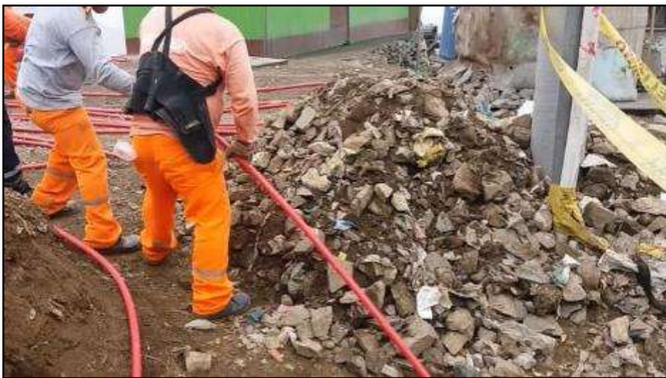
Figura 20: Trabajos de tendido de cable subterráneo en la empresa TEYCONSA S.R.L. San Juan De Lurigancho (2019).
