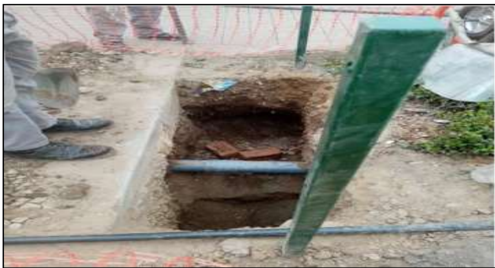
Figura 4: Tubería de instalación sanitaria de 4'' dentro de la zanja donde se realizará el tendido de red eléctrica de media tensión. Lima San Miguel Maranga 4ta etapa.2020
