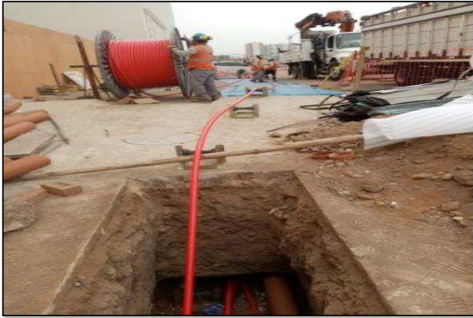
Figura 2: Tendido de redes subterráneas eléctricas de media tensión. Lima San Miguel Maranga 4ta etapa. COBRA PERU 2020
