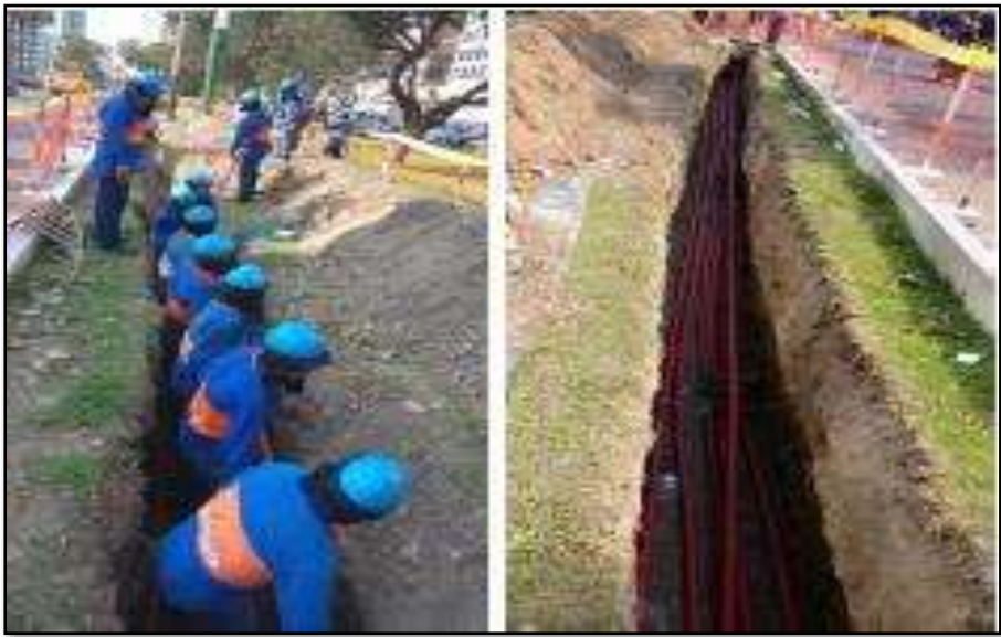
Figura 19: Tendido de cable subterráneo de forma manual. Fuente TECSUR. San Borja 2019.
