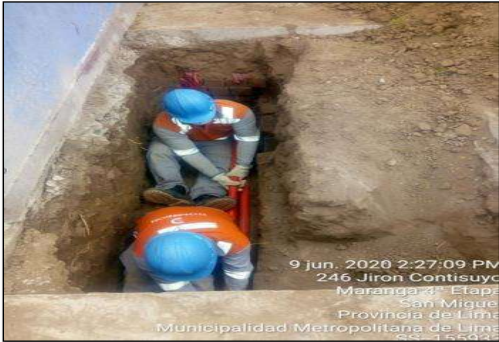
Figura 5: Obstáculos en el tendido de redes subterráneas eléctricas de media tensión. Lima San Miguel Maranga 4ta etapa.
