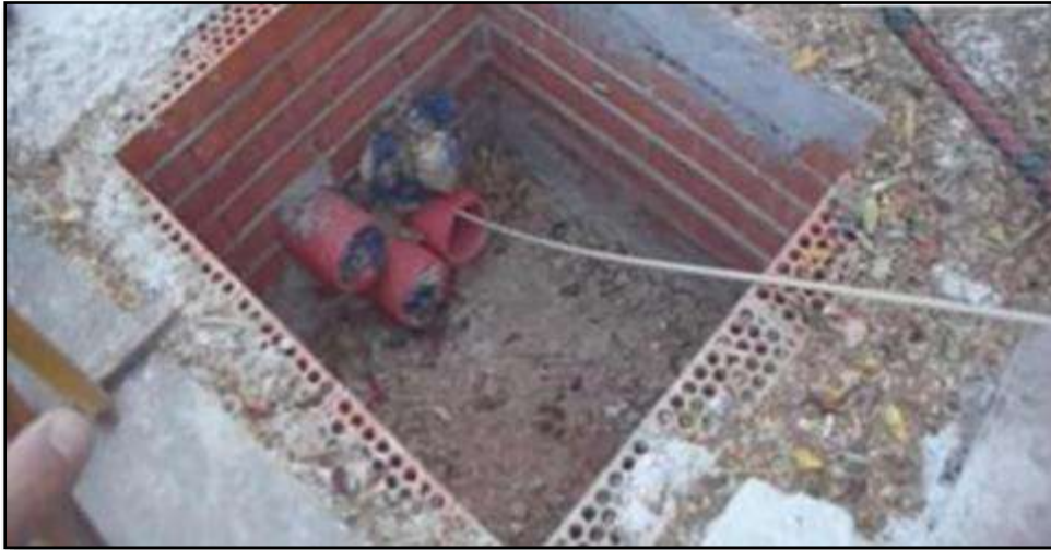
Figura 11: Guía de acero de 8 mm \varnothing pasando por ductos enterrados por donde se realizará el tendido del cable eléctrico subterráneo.
