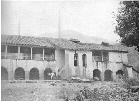
En las haciendas del Perú se encuentran valiosas muestras de una arquitectura sencilla y vigorosa que debe ser la inspiración legítima de nuestras construcciones. (Por qué dejamos influenciar por estilos exóticos, siendo los nuestros mejores?)
