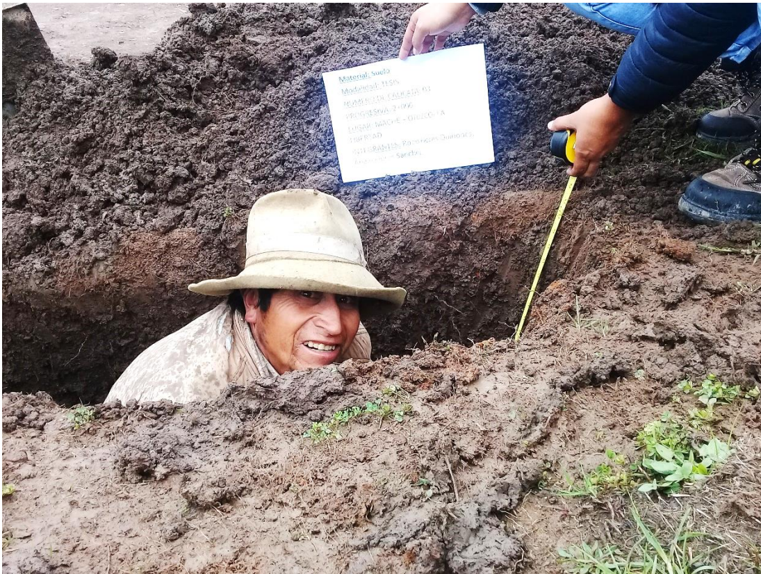
Fotografía N° 03: Excavación de la calicata.
