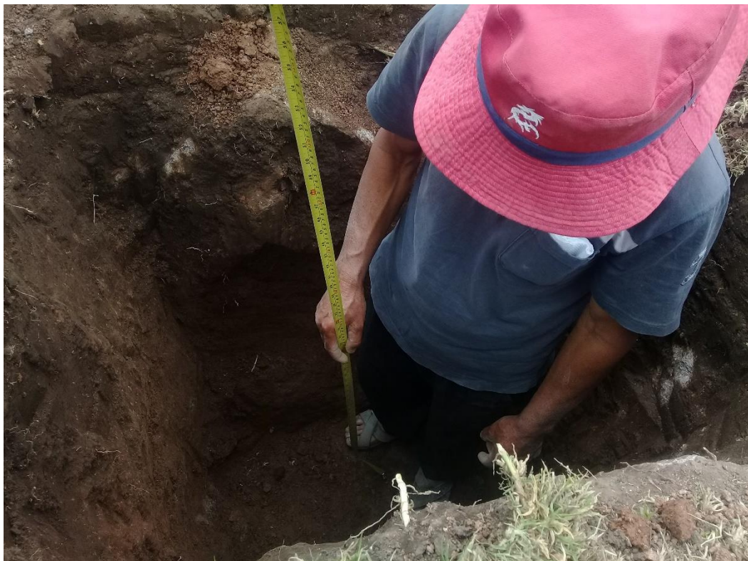
Fotografía N° 04: Medición de la altura de la calicata.
