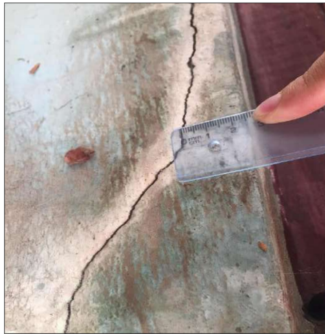
Figura 16. Fisuras.
