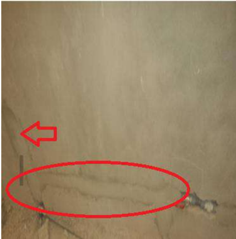
Figura 63: Mal ubicación de llave de paso sin criterio.
