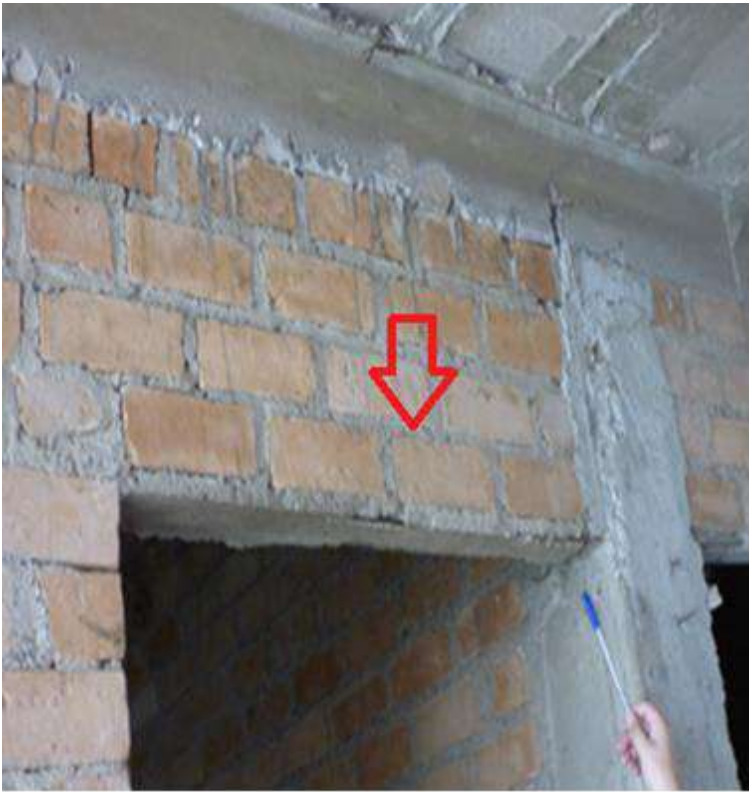
Figura 167: Recubriendo de vanos mínimos.
