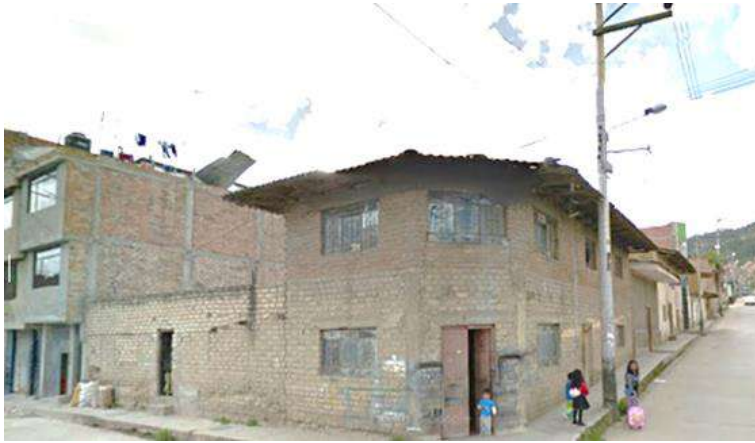
Figura 77: Fachada de vivienda de albañilería confinada.
