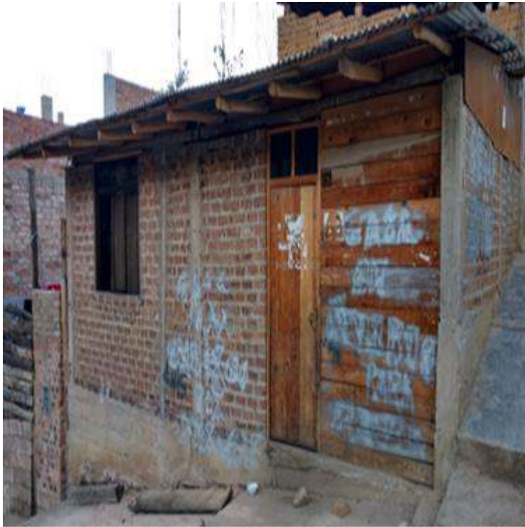
Figura 91: Fachada de vivienda de albañilería confinada.
