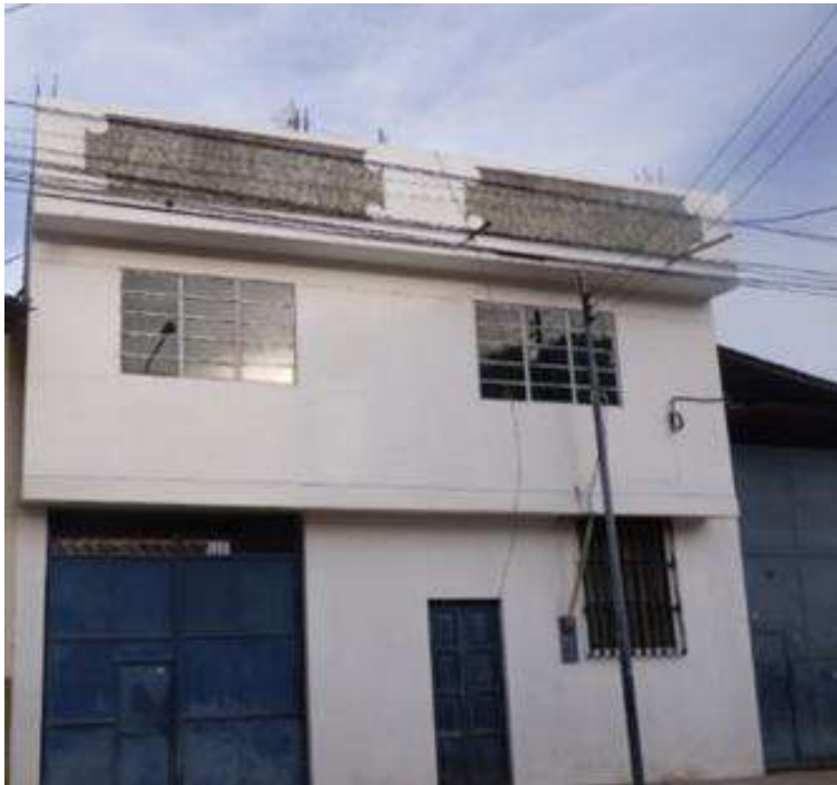
Figura 79: Fachada de vivienda de albañilería confinada.
