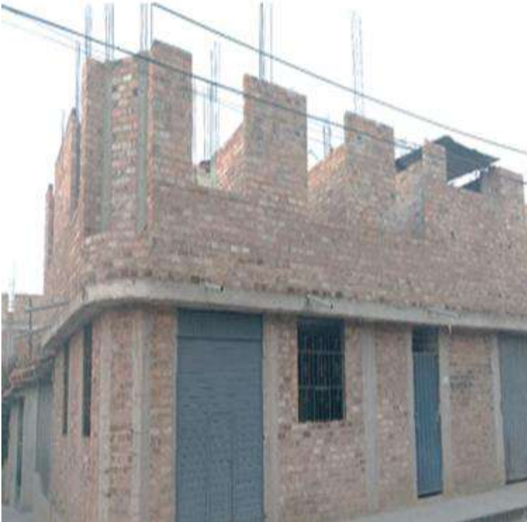
Figura 104: Fachada de vivienda de albañilería confinada.
