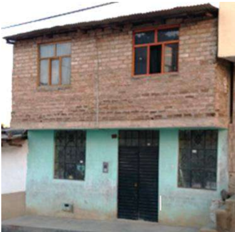
Figura 156: Fachada de vivienda de albañilería confinada.
