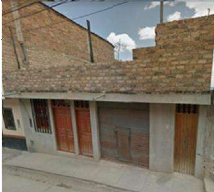
Figura 134: Fachada de vivienda de albañilería confinada.
