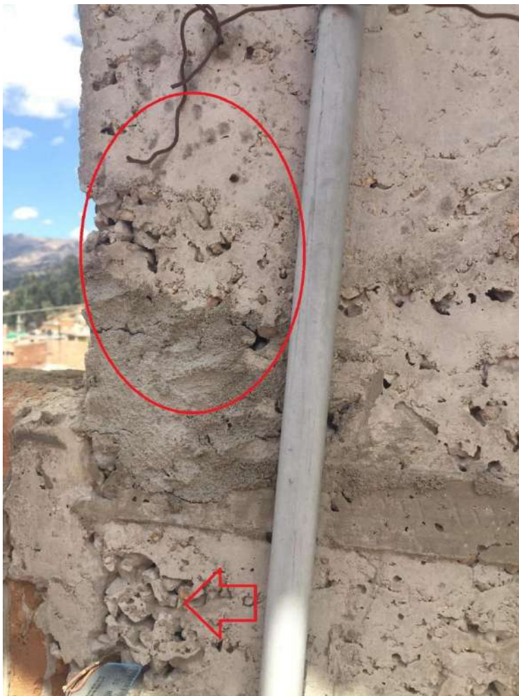
Figura 78: Cangrejas en columna por chuseado.
