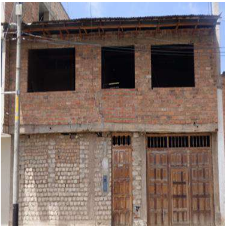
Figura 96: Fachada de vivienda de albañilería confinada.
