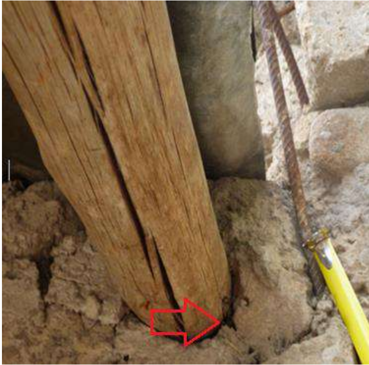
Figura 65: Mescal de acero de columna y vigas de madera para entramado de techo.
