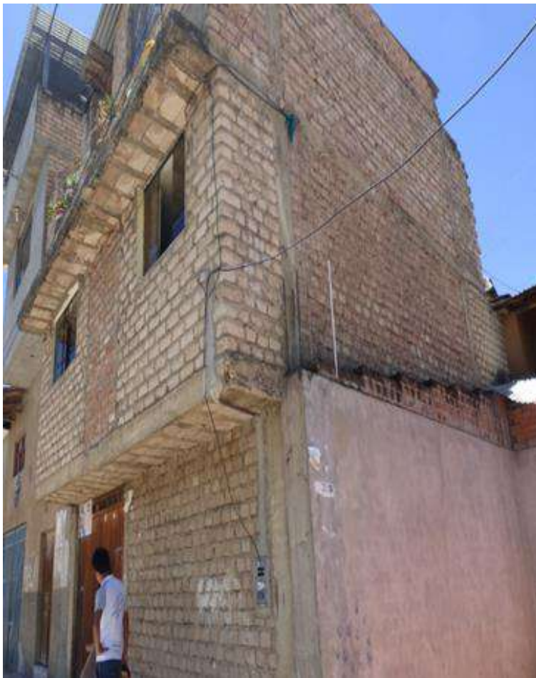
Figura 98: Fachada de vivienda de albañilería confinada.
