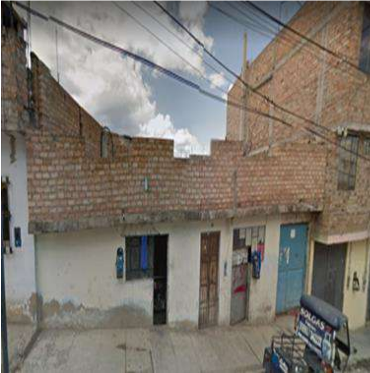
Figura 93: Fachada de vivienda de albañilería confinada.
