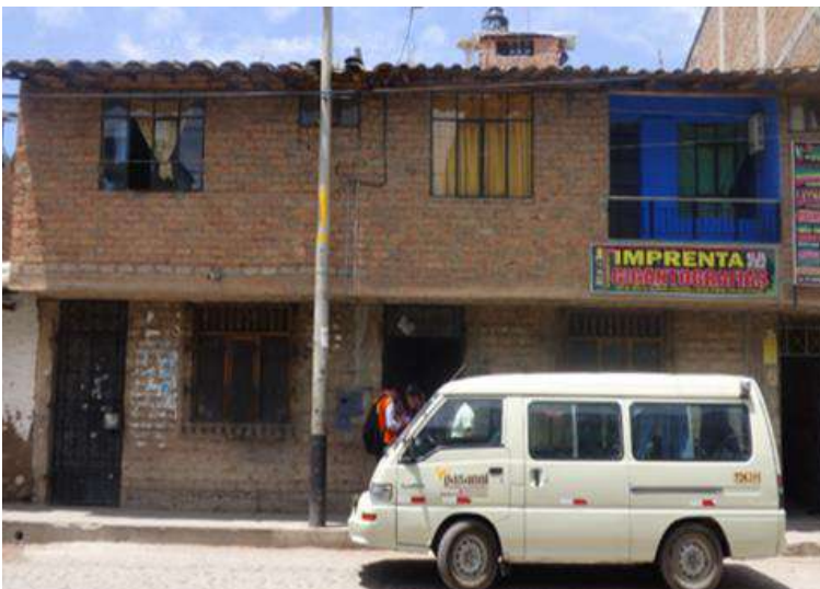
Figura 108: Fachada de vivienda de albañilería confinada
