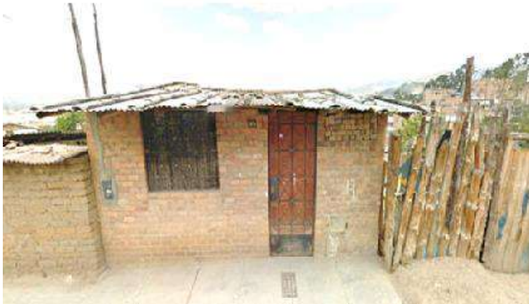
Figura 138: Fachada de vivienda de albañilería confinada.
