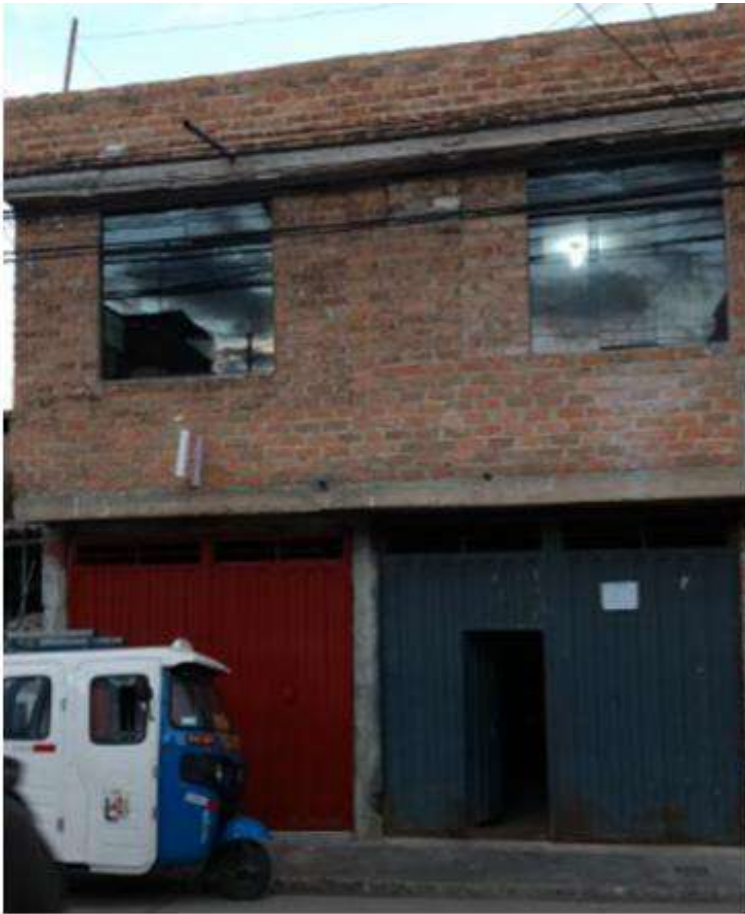
Figura 81: Fachada de vivienda de albañilería confinada.
