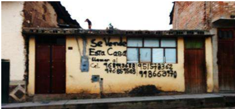
Figura 148: Fachada de vivienda de albañilería confinada.
