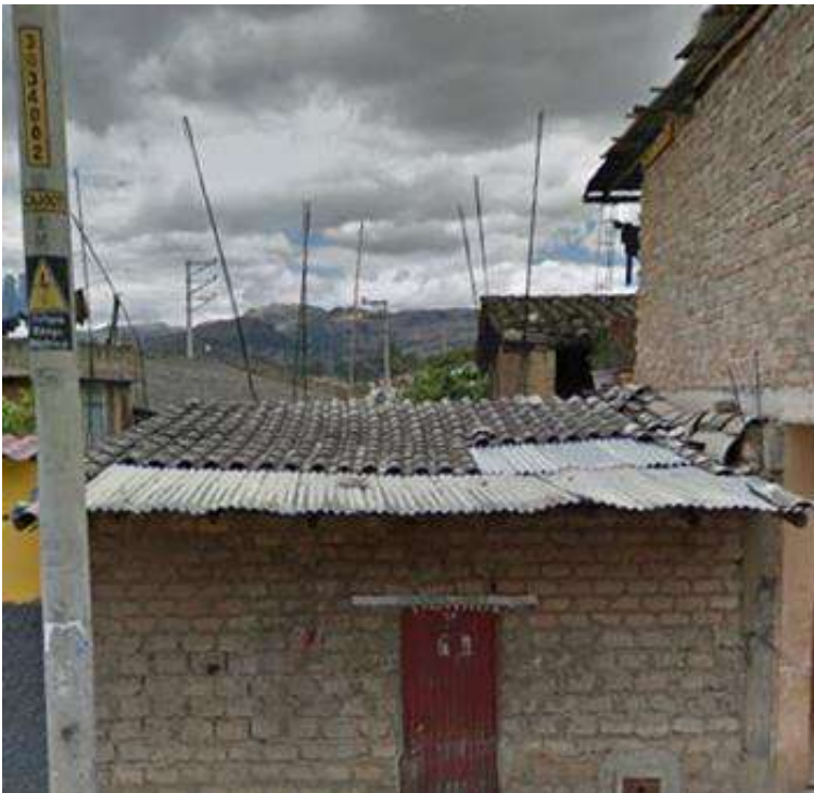
Figura 88: Fachada de vivienda de albañilería confinada.
