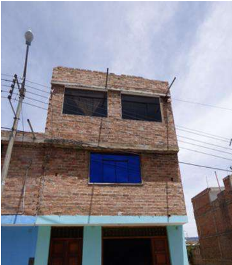
Figura 89: Fachada de vivienda de albañilería confinada.
