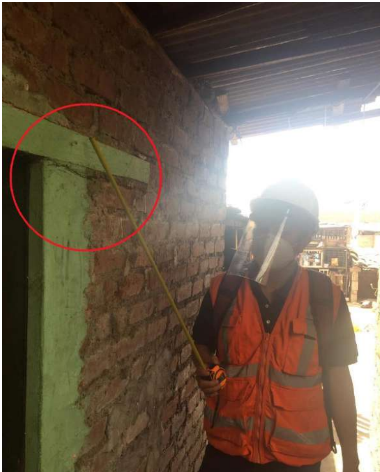
Figura 58: Combinación de viga de madera en albañilería.
