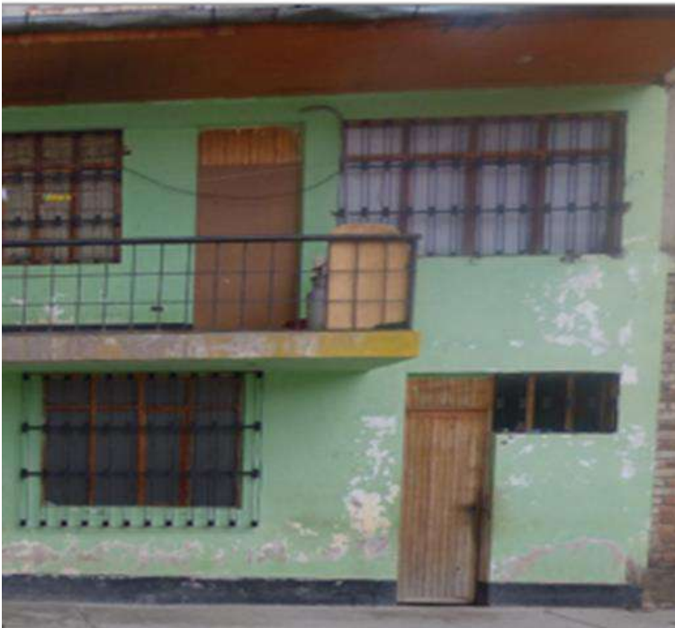
Figura 122: Fachada de vivienda de albañilería confinada.
