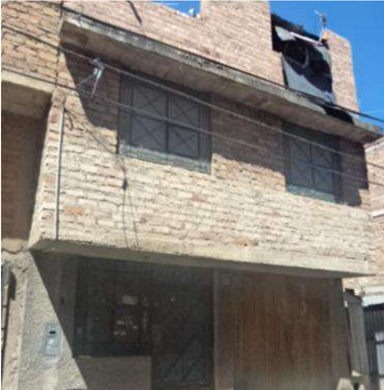
Figura 120: Fachada de vivienda de albañilería confinada.
