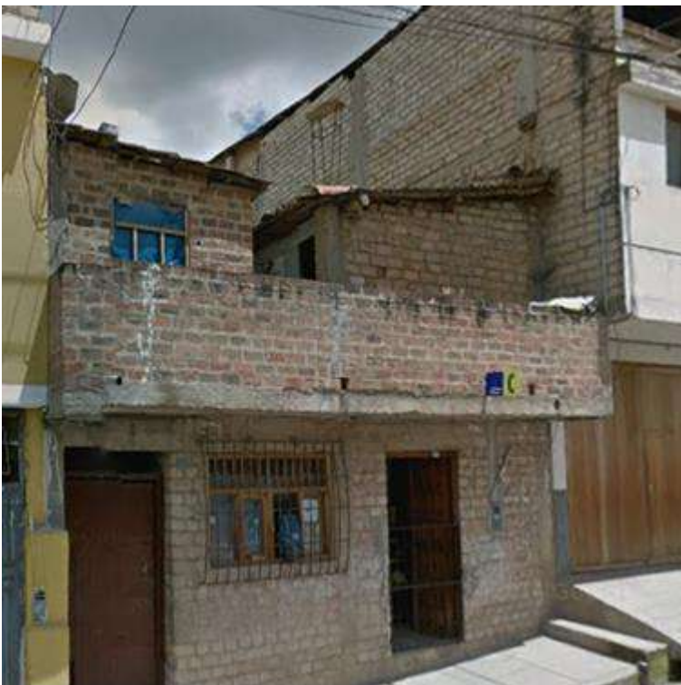
Figura 84: Fachada de vivienda de albañilería confinada.
