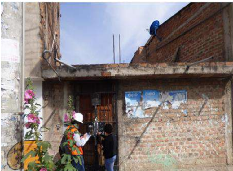
Figura 118: Fachada de vivienda de albañilería confinada.
