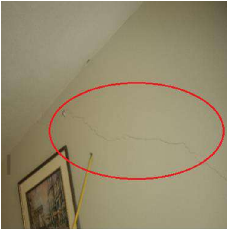
Figura 33: Presenta fisura vertical en muro.
