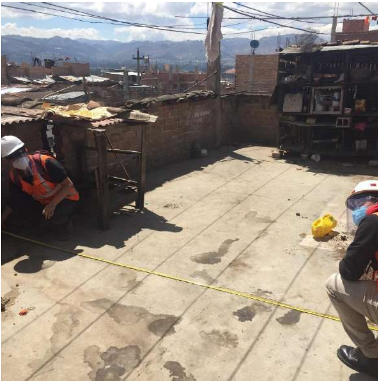
Figura 76: Tomando medidas de la vivienda de albañilería confinada.
