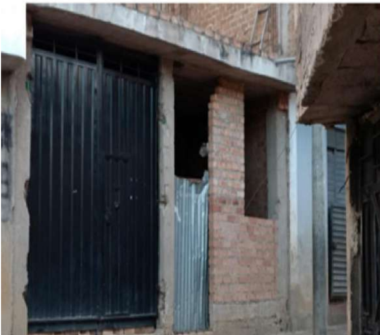
Figura 144: Fachada de vivienda de albañilería confinada.
