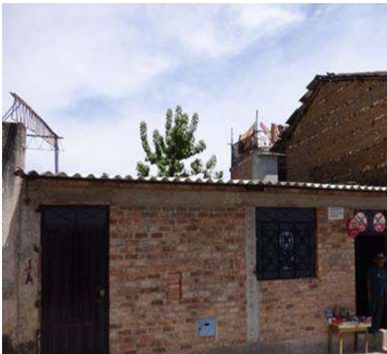
Figura 100: Fachada de vivienda de albañilería confinada.
