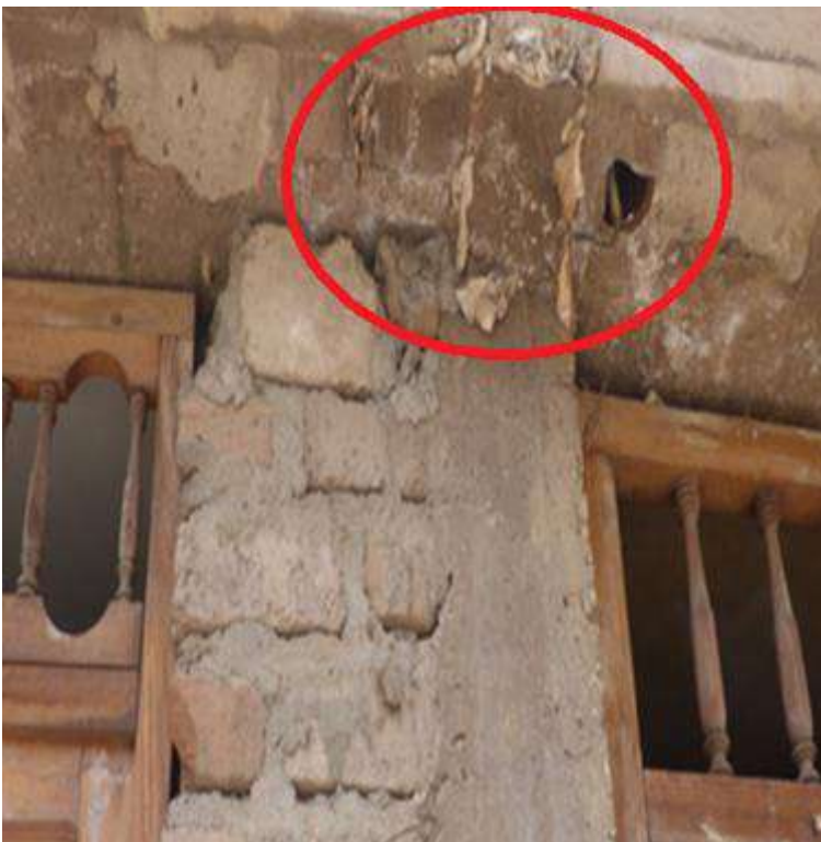
Figura 154: Residuos de encofrado.
