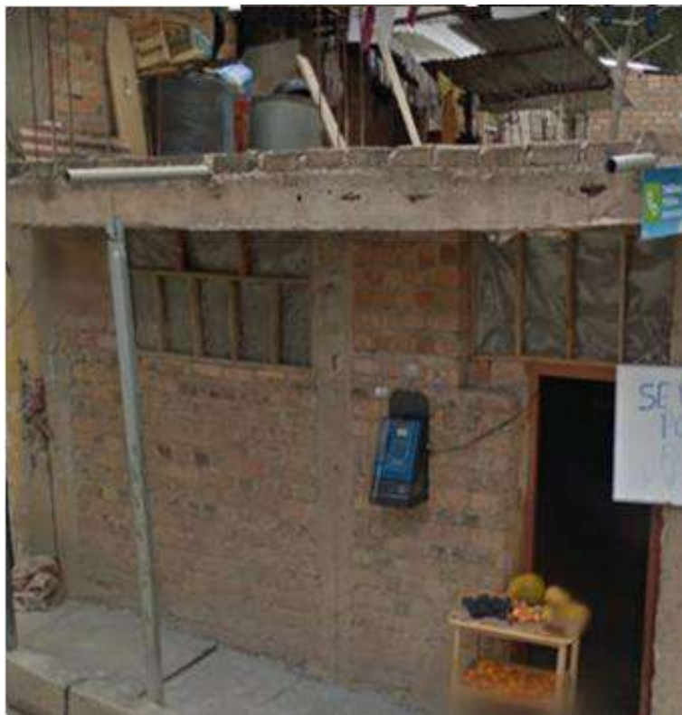
Figura 126: Fachada de vivienda de albañilería confinada.
