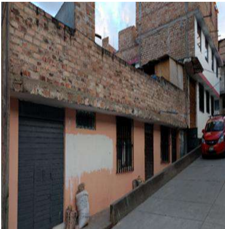
Figura 114: Fachada de vivienda de albañilería confinada.
