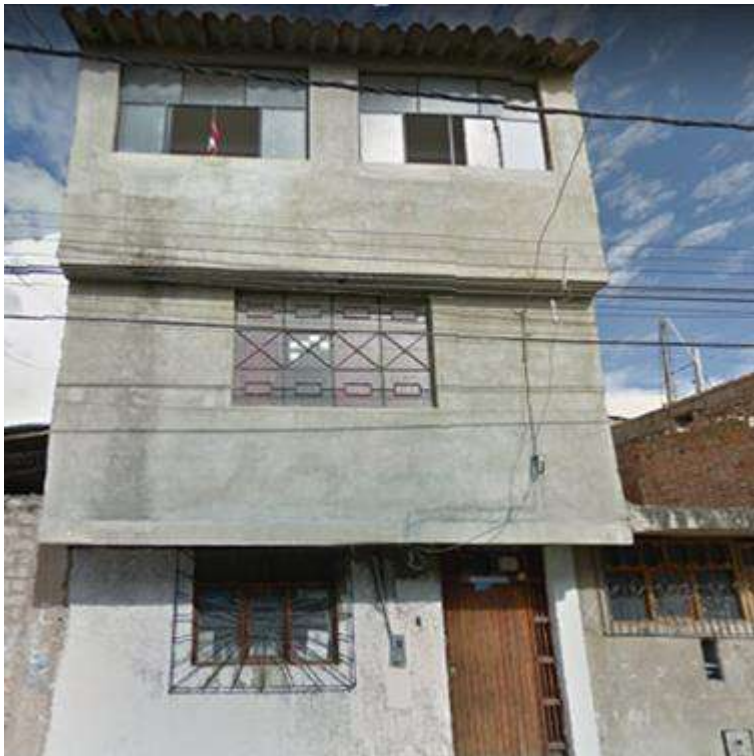
Figura 124: Fachada de vivienda de albañilería confinada.
