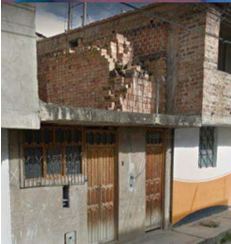
Figura 169: Fachada de vivienda de albañilería confinada.
