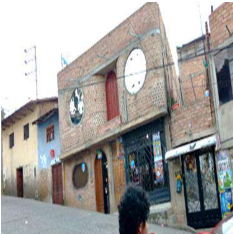
Figura 150: Fachada de vivienda de albañilería confinada.
