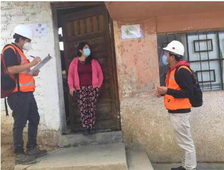
Figura 46: Inspección de viviendas de albañilería confinada.
