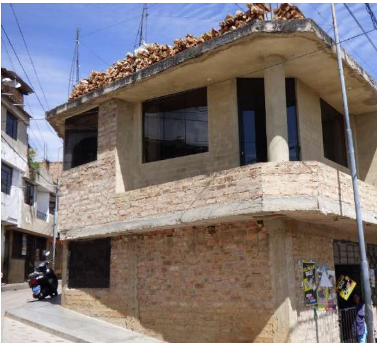
Figura 112: Fachada de vivienda de albañilería confinada.
