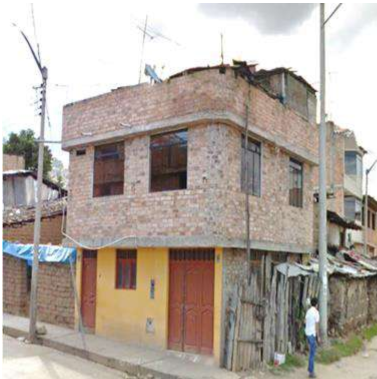
Figura 116: Fachada de vivienda de albañilería confinada.
