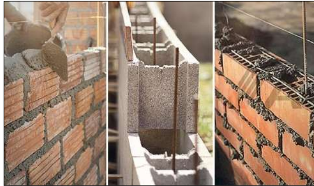
Figura 05. Albañilería Armada.
