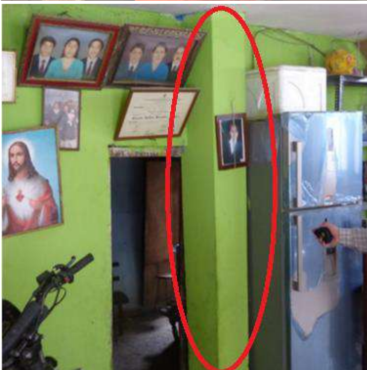
Figura 140: Columna central torcida no centrada.
