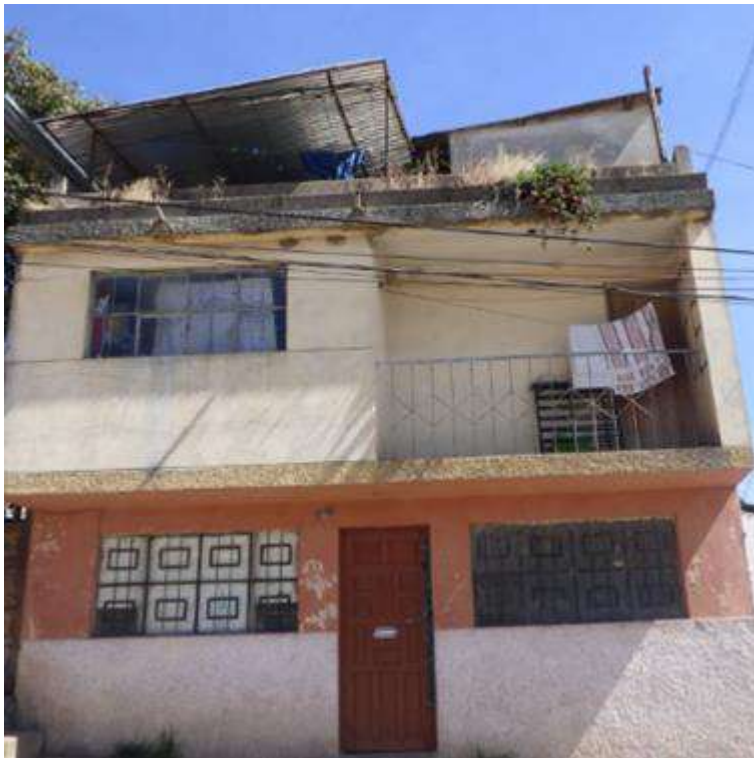
Figura 110: Fachada de vivienda de albañilería confinada.
