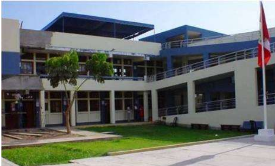
Figura 04: Vista de la Fachada
