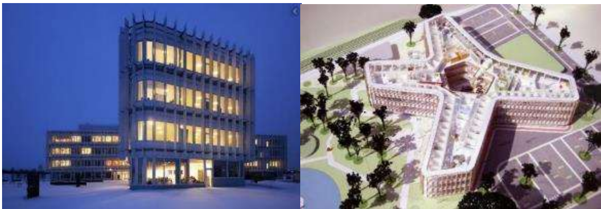
Figura 18: Vista de Fachada y Vuelo de Pájaro
