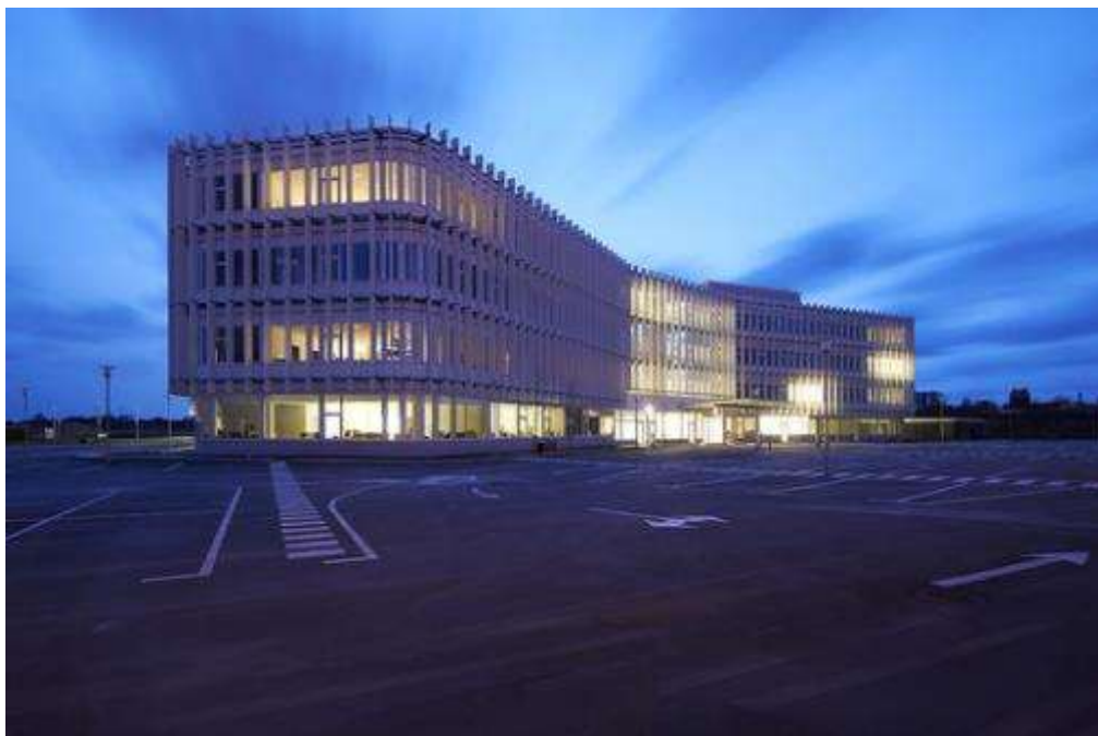
Figura 06: Vista de Fachada
