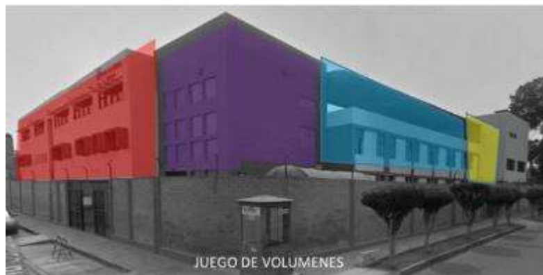
Figura 15: Vista de Fachada
