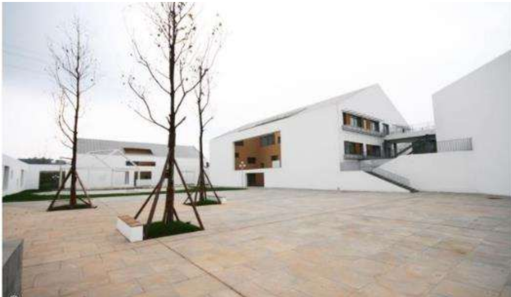
Figura 01: Vista del Patio Central
