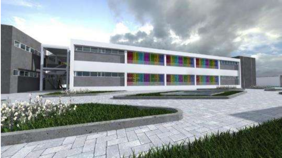
Figura 46: Fachada de Bloque de Aulas (Primaria y Secundaria)
