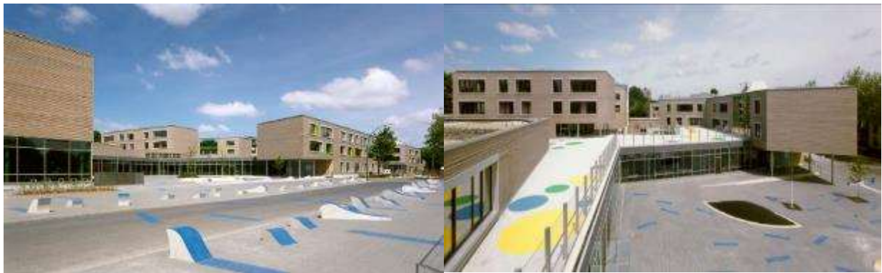
Figura 11: Vista de Fachadas y Patio Principal
