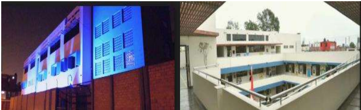
Figura 13: Vista de Fachada y de Patio Principal
