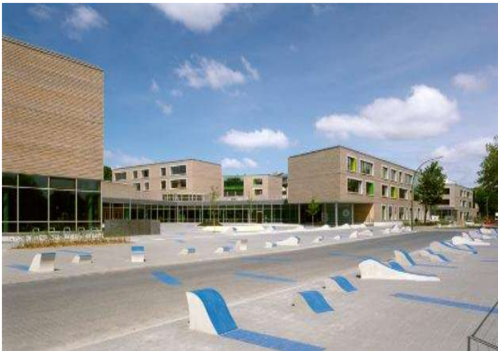
Figura 03: Vista de Fachada
