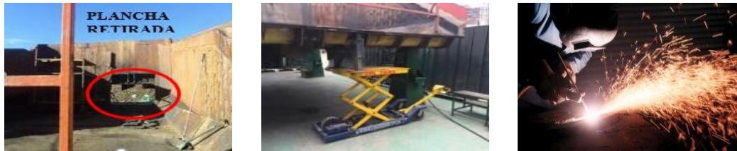
Figura 7. Reparación de tolvas
