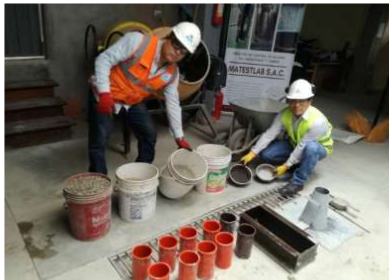
Figura 17. Tandeo de materiales.
