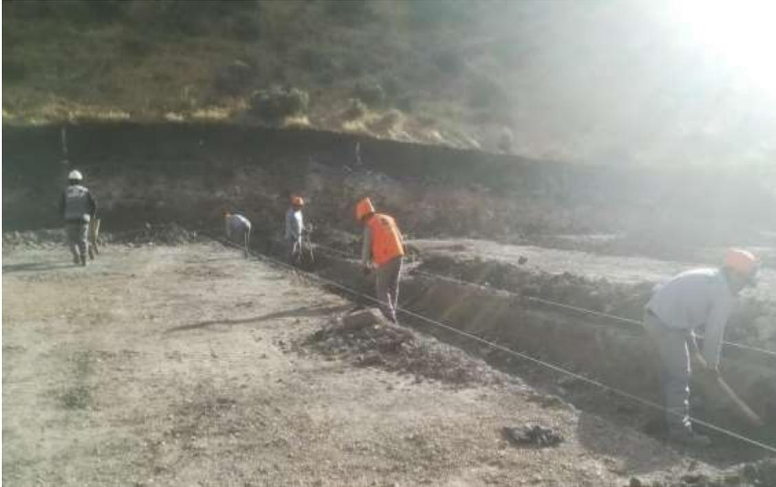
*Fotografía 5. Excavación para cimentación*
