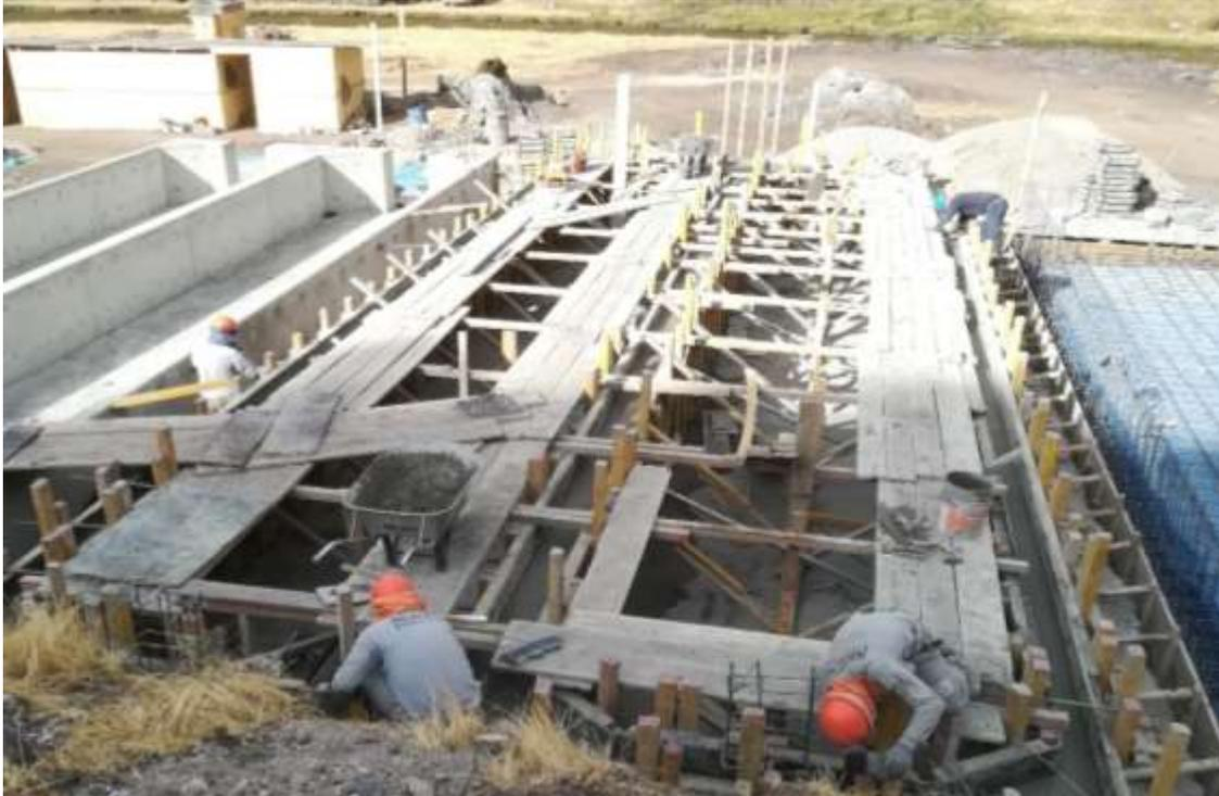
*Fotografía 11. Vaciado de concreto en muro*
