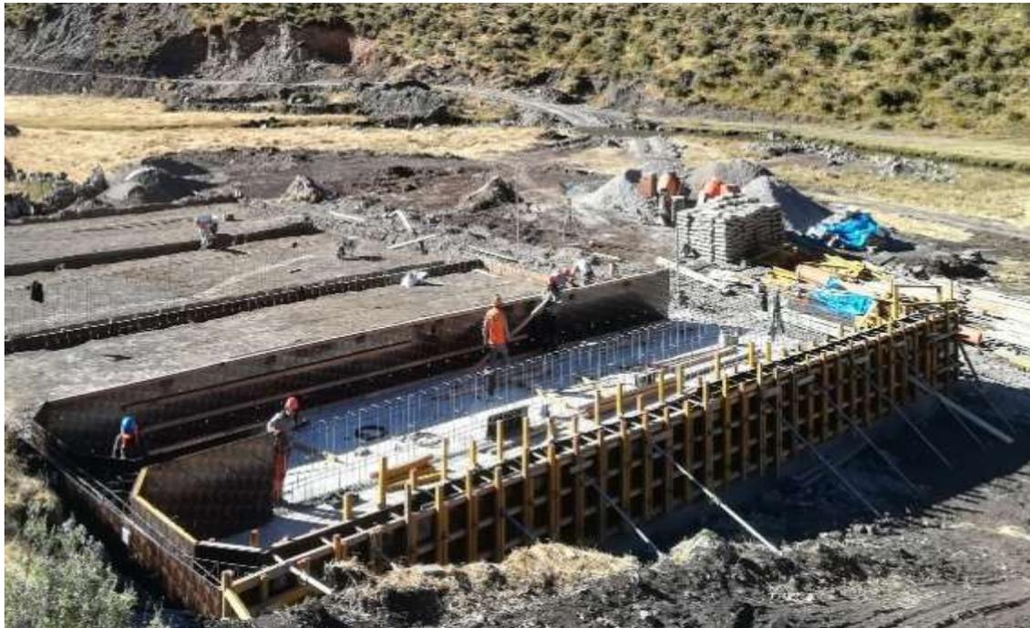
*Fotografía 10.* Encofrado de muros
