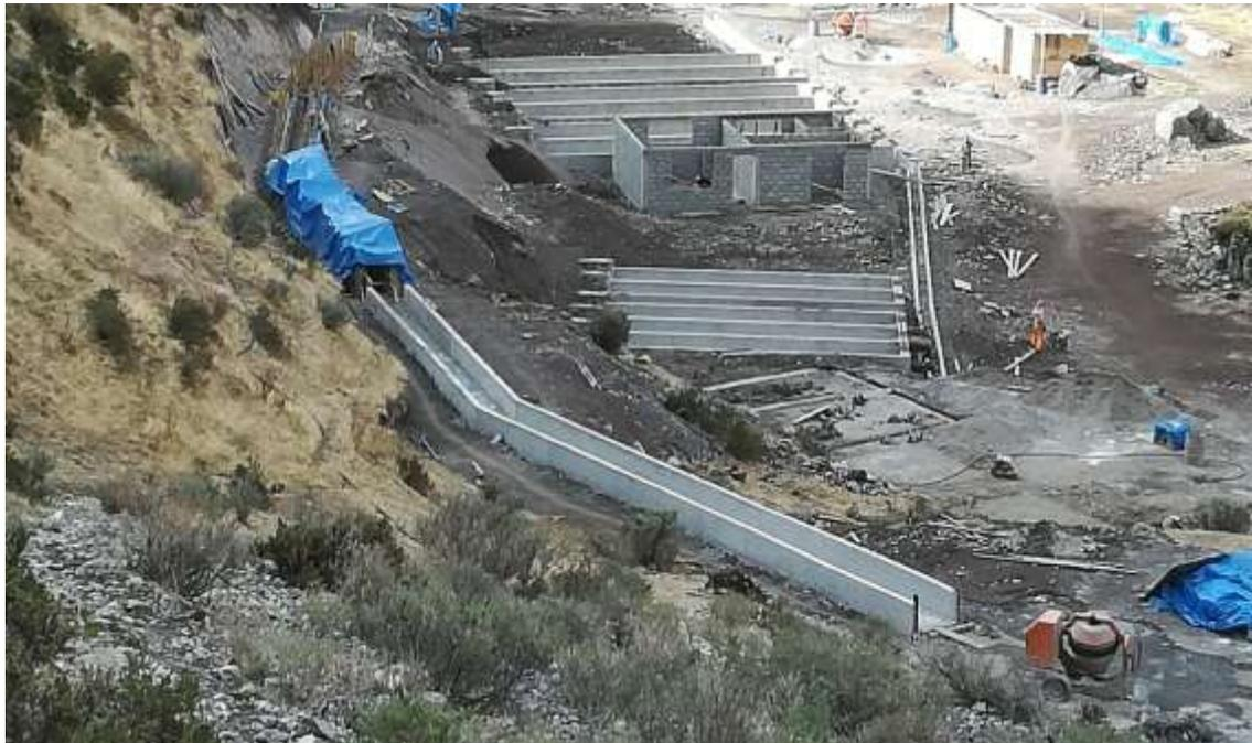
*Fotografía 18. Construcción de canales hidráulicos de alimentación*
