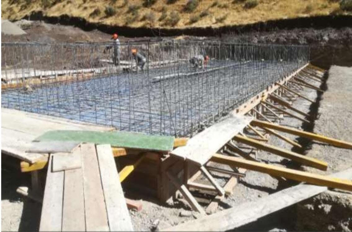
*Fotografía 7. Encofrado de cimentación*
