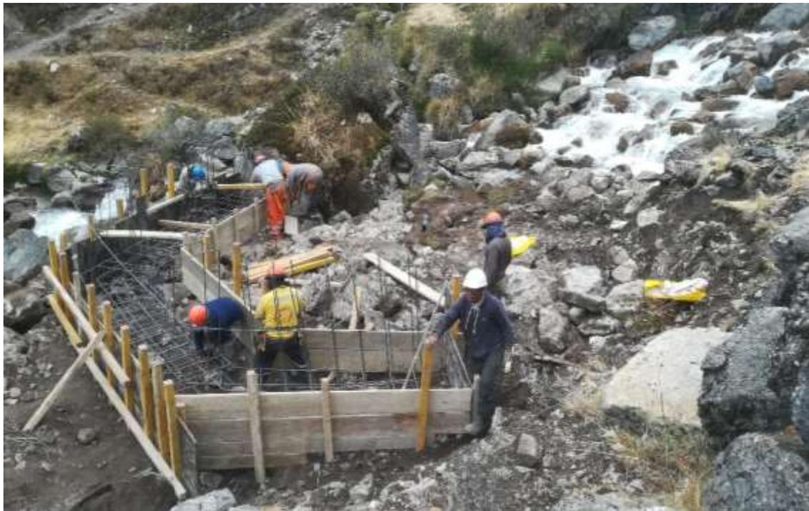
*Fotografía 14.* Construcción de bocatoma
