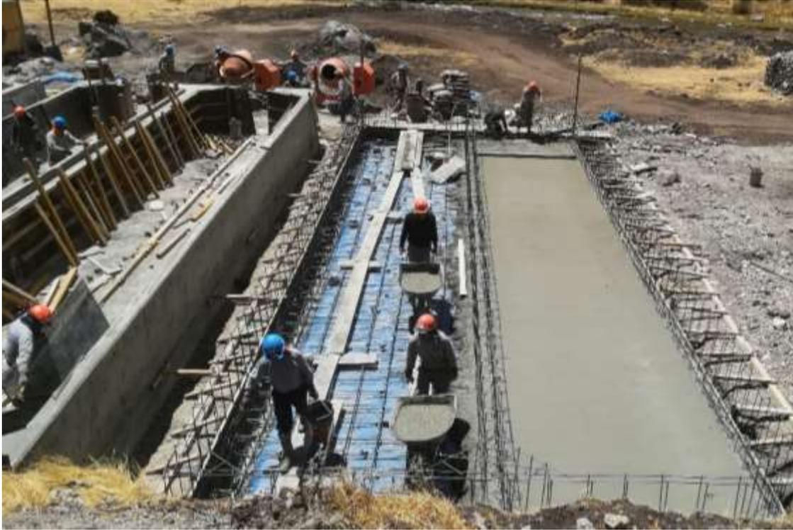
*Fotografía 9.* Vaciado de Losa y Cimentación
