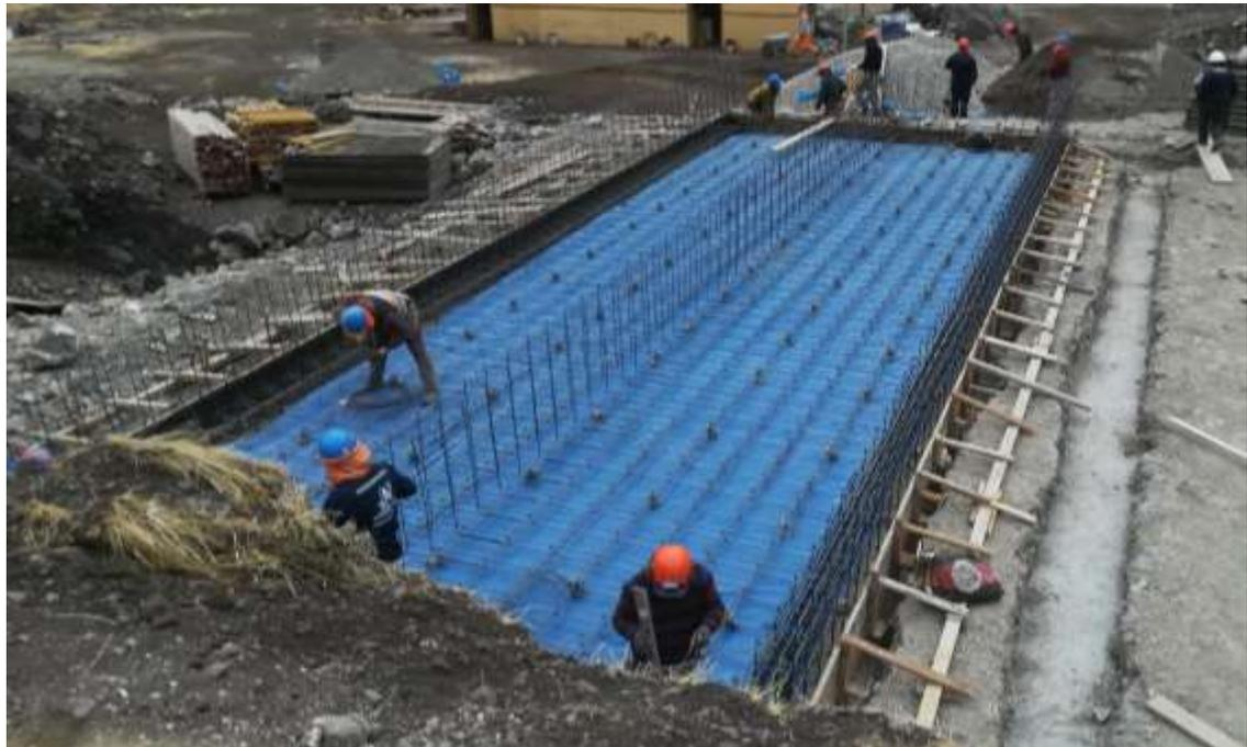
*Fotografía 8. Colocación de acero*
