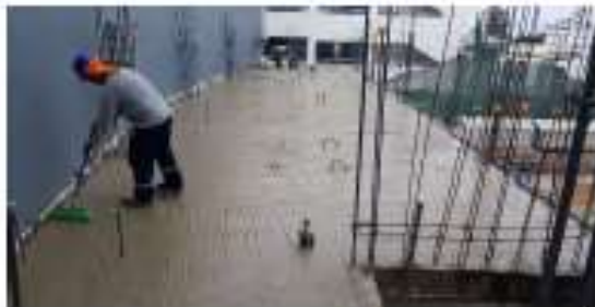
Película de impermeabilizante sobre losa.
