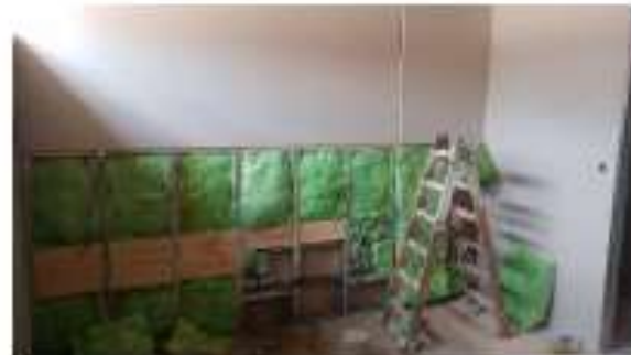
Se realizan instalaciones eléctricas y data, en tabiques.
