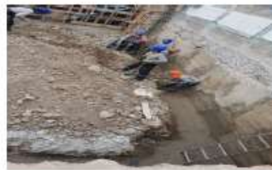
Calzaduras terminadas, se perfila y nivela para cimentación.
