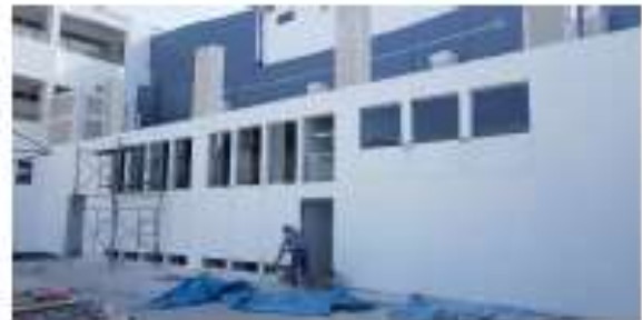
Se instala vidrios y carpintería.
