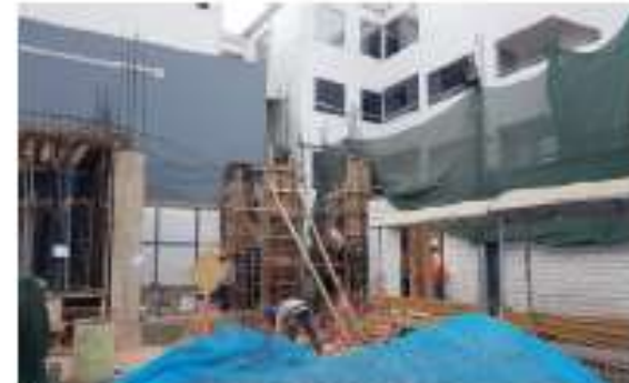
Se finaliza con columnas.
