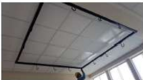
Se instala estructura metálica adosada en el techo.
