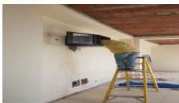
Se instala gabinete para puntos de data.
