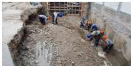
Se realiza talud contra la zona del patio.
