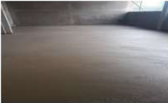
Contrapiso en Psicomotricidad.
