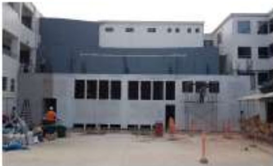
Se aplica primera capa de sellador en muros.
