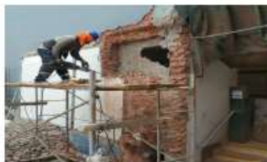
Se empieza con demolición con parte del muro existente, para ubicar una columna nueva.
