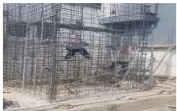
Enmallado de la caja del ascensor.
