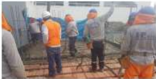
Se realiza vaciado con concreto premezclado y acelerante de 3 días.
