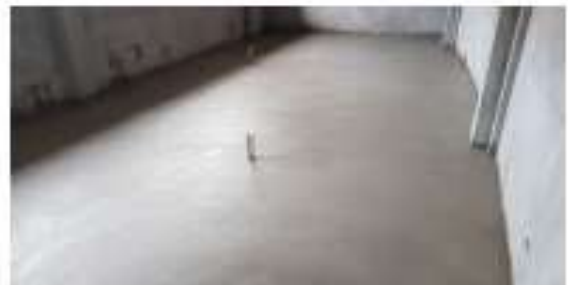
Contrapiso en el depósito de deportes.
