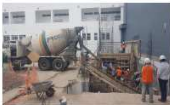
Se realiza vaciado de zapatas y cimiento de placas.
