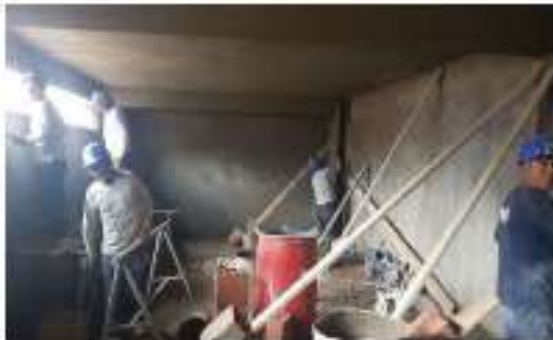
Se finaliza tarrajeo en el depósito, terminando derrames.
