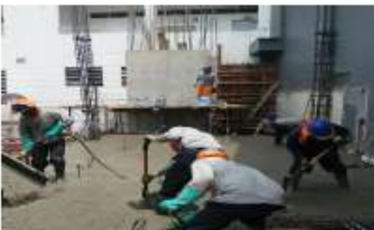
Se realiza vaciado con concreto premezclado y acelerante de 3 días.
