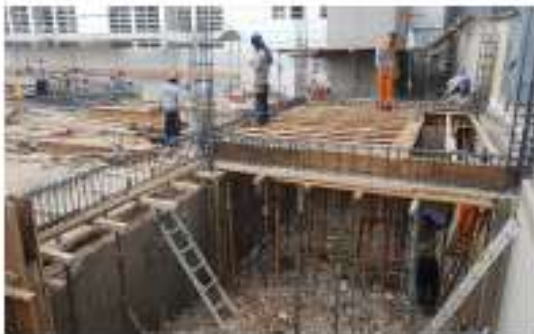
Se realiza encofrado de primer techo.
