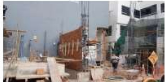
Asentado de muro portante con viga de amarre.
