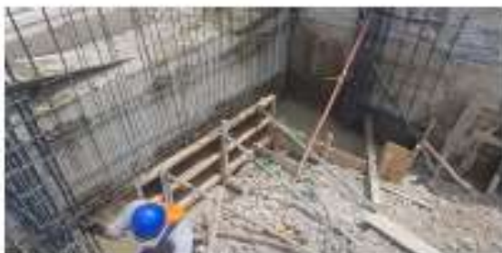
Se empieza con el vaciado de zapatas y cimiento de placas.
