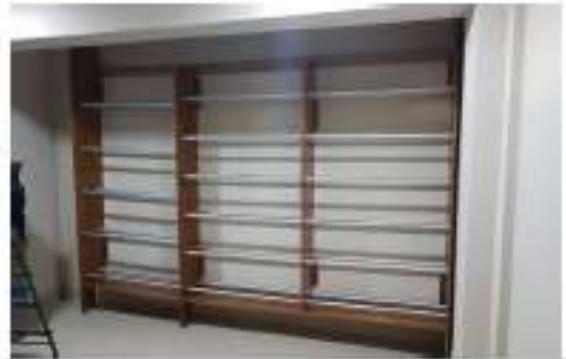
Se realiza instalaciones de muebles fijos en los ambientes.
