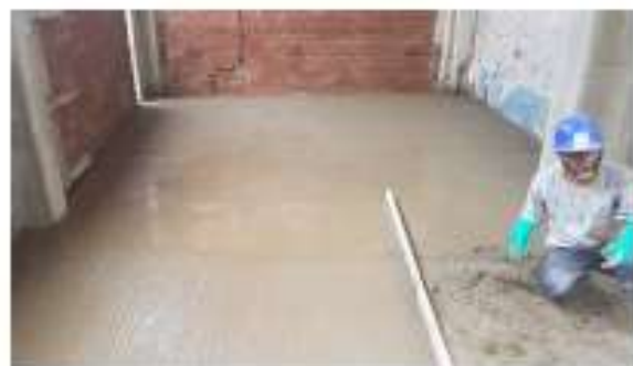
Se realiza falso piso en el Aula 21.
