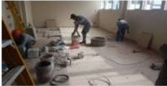
Enchape de porcelanato en el aula de Psicomotricidad.
