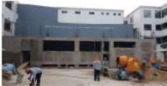
Tarrajeo de fachada.
