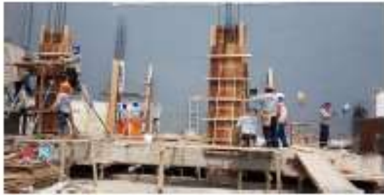
Encofrado y vaciado columnas primer piso.
