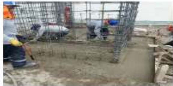
se realiza vaciado de zapata de ascensor.
