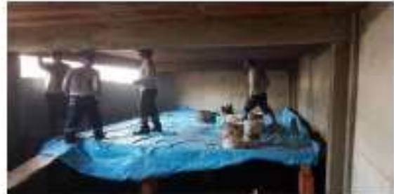
Se inicia tarrajeo en cieloraso en el depósito.
