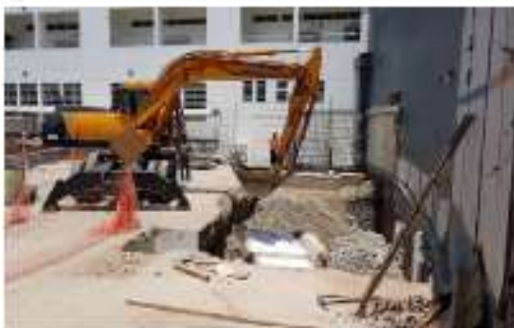
Eliminación de desmonte.
