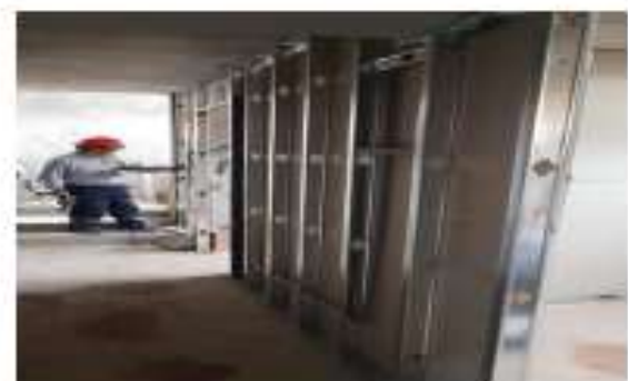
Se realizan tabiques de drywall en semisótano.
