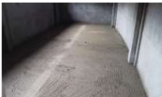
Se realiza falsopiso en el depósito de deportes.
