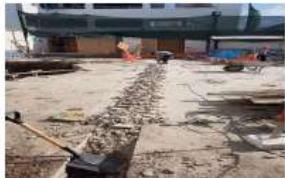
Reubicación de tuberías de agua.
