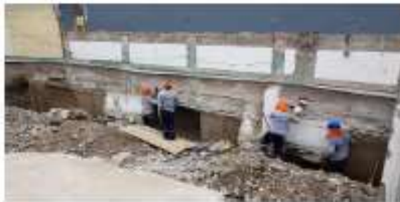
Se empieza con las calzaduras, segunda etapa.
