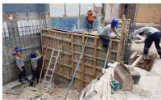
Encofrado de placas y columnas.
