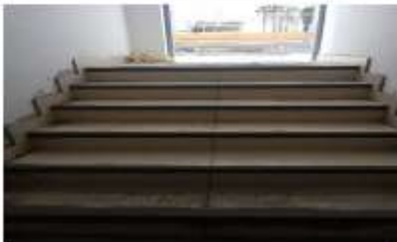
se realiza voleado de mortero en esquinas de escalera
