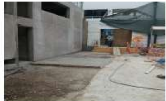
Falso piso zona de patio.
