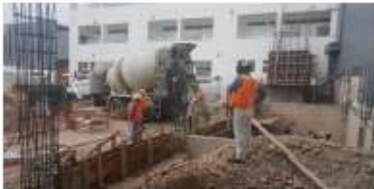
Se finaliza el vaciado de zapatas y cimiento de placas, zona del sótano.
