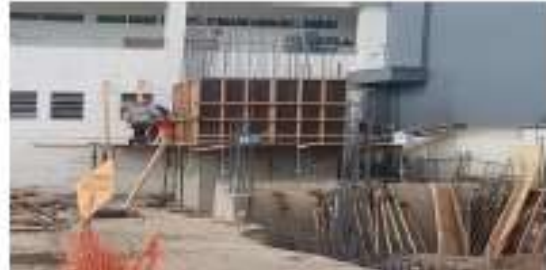
Se realiza vaciado de la caja del ascensor, en 2 etapas.
