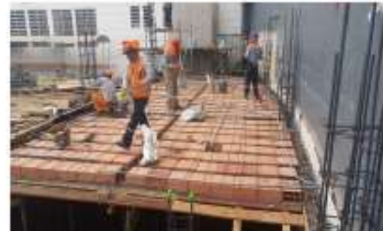
Se realiza IIEE, y se corrobora el acero correspondiente.
