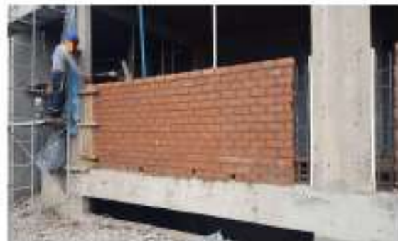
Se realiza muros de albañilería confinada con columnas de amarre.
