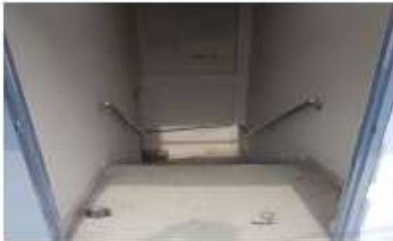
Instalación de barandas en escaleras.
