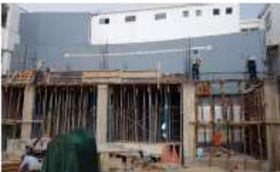
Se continua con segundo paño del techo.
