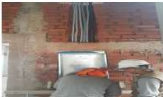
Colocación de tablero de distribución.
