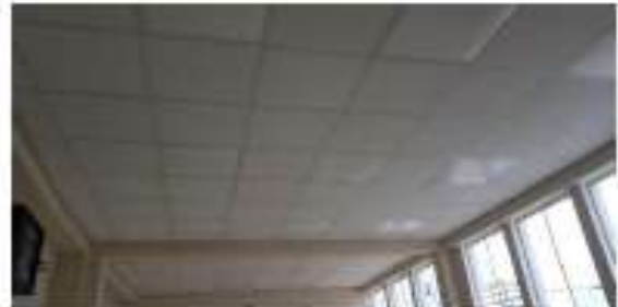
Instalación de baldosas acústicas en el aula de Psicomotricidad.
