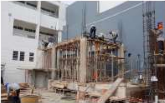
Se empieza con encofrado de segundo techo.
