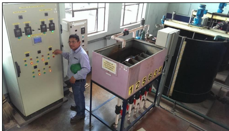
Figura 7. Trabajos eléctricos en zona de inyección de reactivos planta atarjea Fuente: Phoenix EPC S.A.C.
