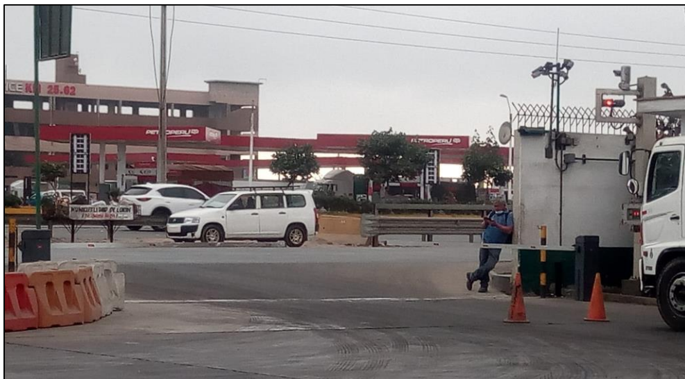
Figura 56. Montaje de Lector RFID, semáforos y cámara PTZ en puerta de salida
