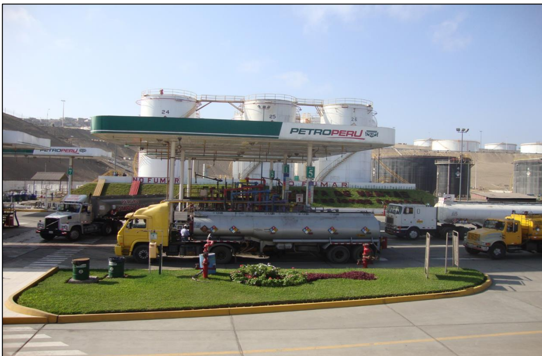
Figura 18. Despacho de combustibles a camión cisterna en el terminal de refinería conchán
