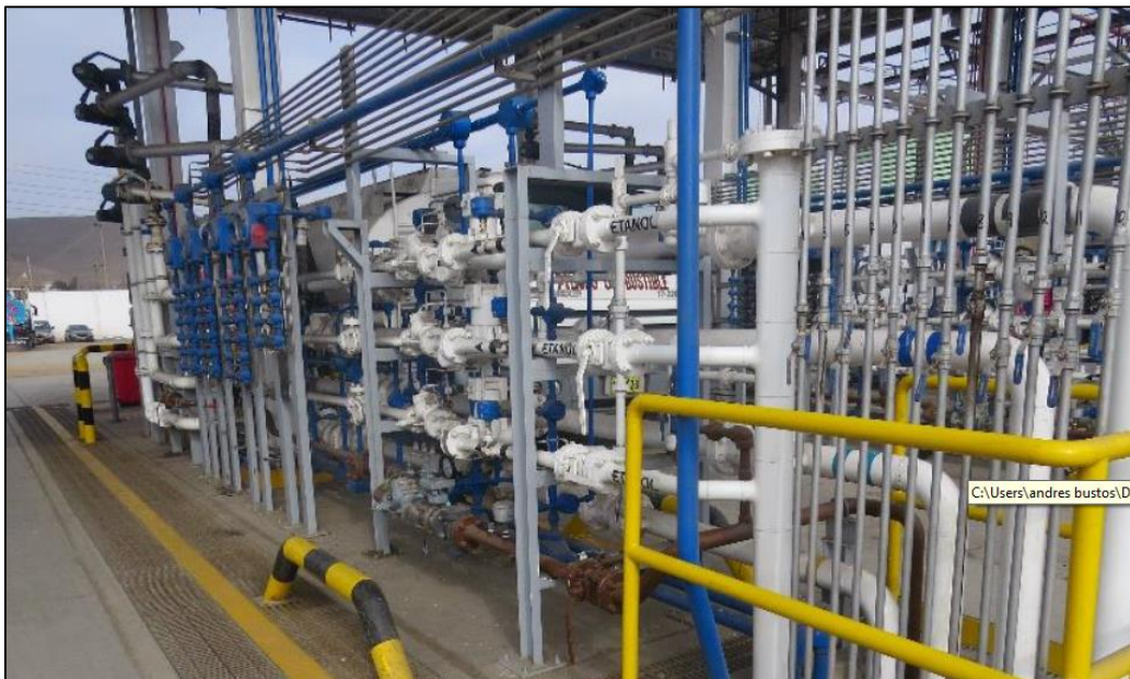
Figura 8. Sistema de mezcla en línea para diésel – planta PBF del Perú
