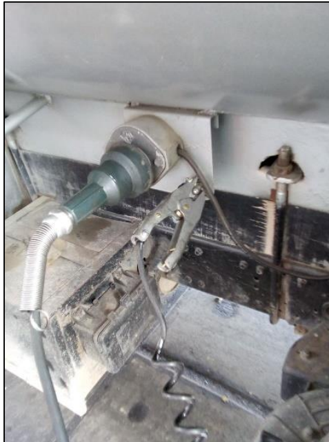
Figura 30. Tenaza de puesta a tierra y sensor de sobrellenado en cisterna Fuente: Phoenix EPC S.A.C.
