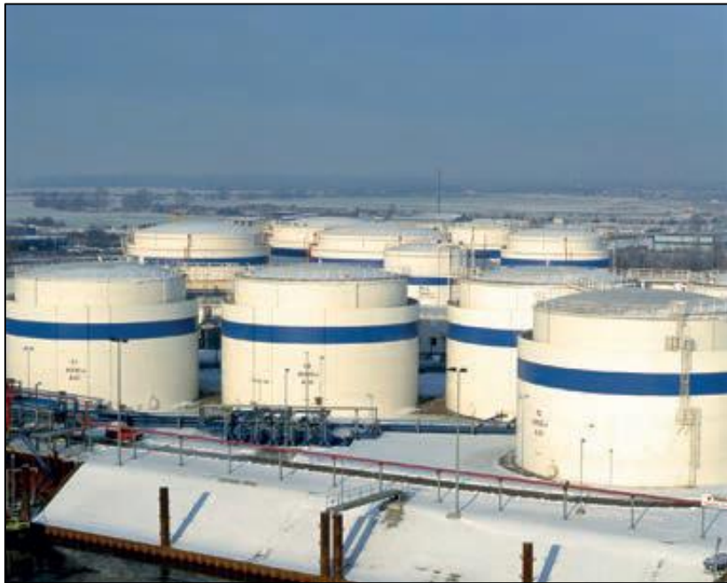
Figura 17. Patio de tanques de almacenamiento de combustibles
