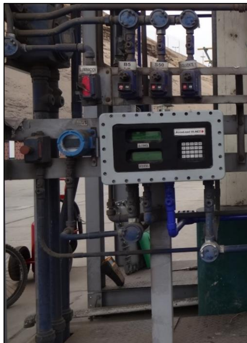
Figura 29. Lectora de proximidad de islas de despacho Fuente: Phoenix EPC S.A.C.
