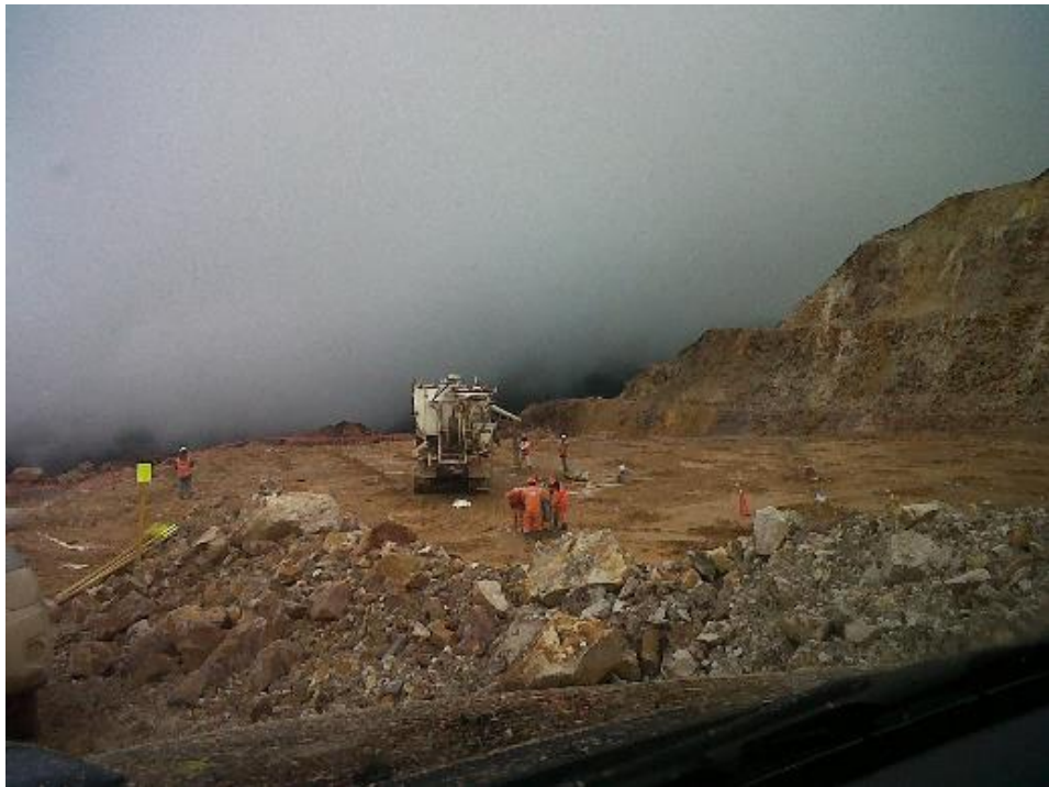
Foto 2. Carga de explosivos con el camión fábrica en dominios de sílice masiva
