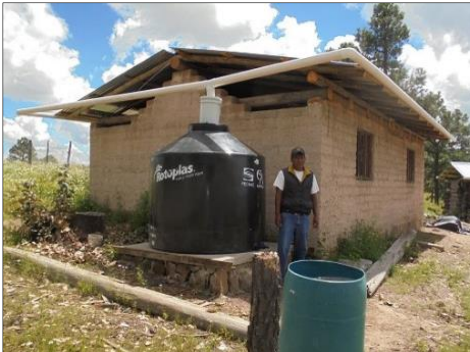
Figura2: Techos de viviendas para colocar canaletas y tuberías de PBC para conducir agua hacia un sistema de almacenamiento.
