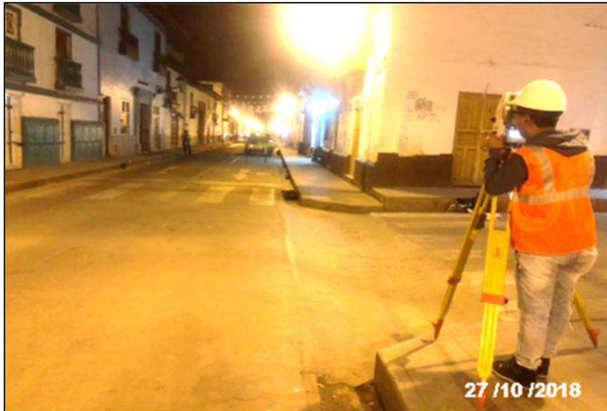
Fotografía 3: Levantamiento topográfico intersección sin semáforo Jirón Tarapacá y Jirón Del comercio.
