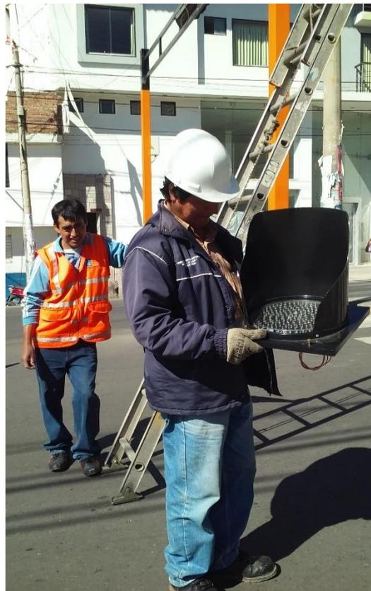
*Figura 03:* en la figura 03 muestra al técnico realizando el mantenimiento a una pantalla óptica de semáforo.
