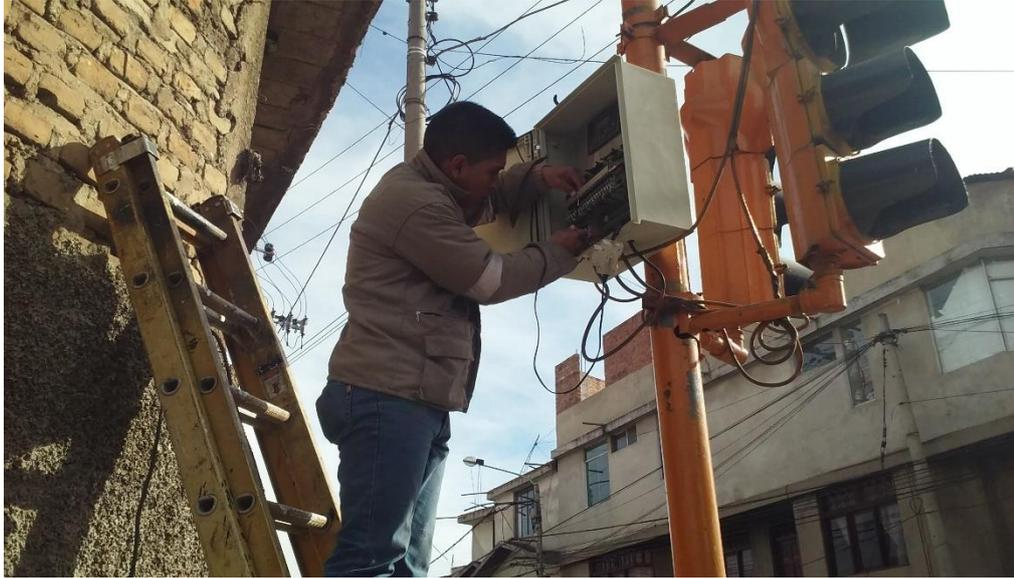
*Figura 02:* la figura 02 muestra al técnico realizando la inspección preventiva del controlador electrónico vehicular.
