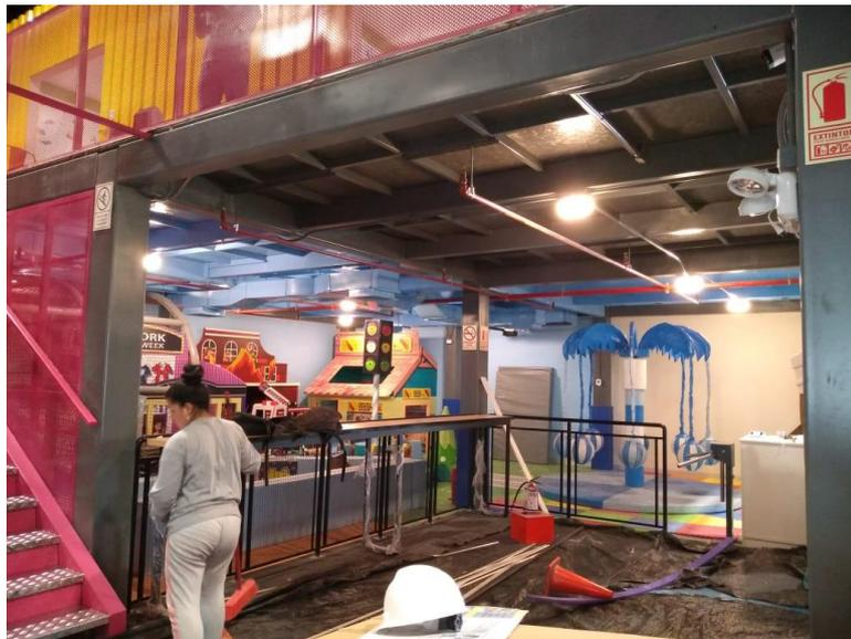
*Figura 2.* Construcción de mezzanine metálico para oficinas en las tiendas de Happy Land Perú Mall Santa Anita, distrito de Santa Anita, año 2019.
