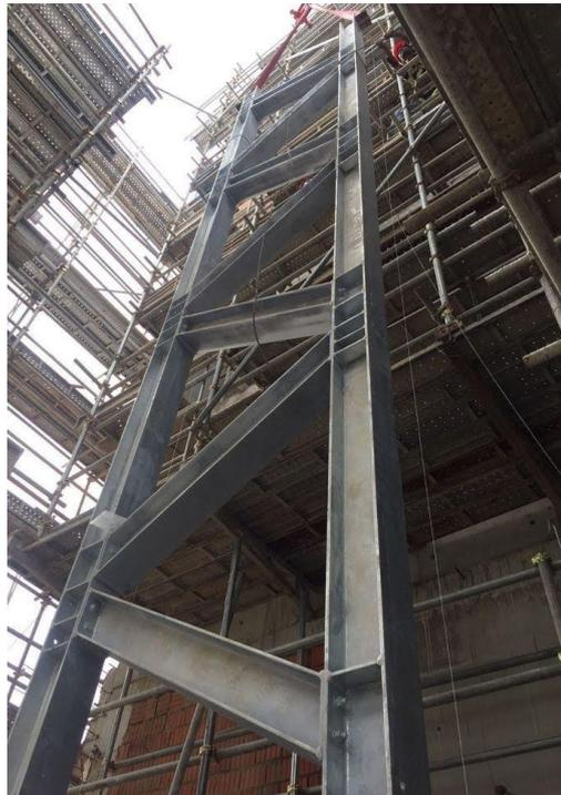
*Figura 9.* Reforzamiento de vigas peraltadas de concreto con vigas HD 10 x 30 pulgadas x libras/pie Mall del Sur, distrito de San Juan de Miraflores 2017.
