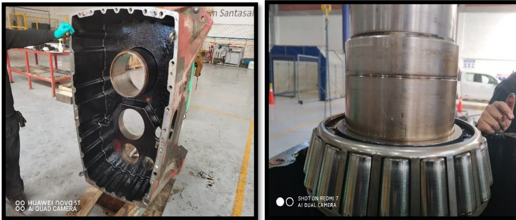
Figura 24: Ejemplo de inadecuado montaje en la caja reductora.
