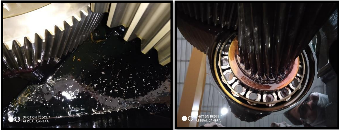
Figura 22: Ejemplo de inadecuada lubricación.
