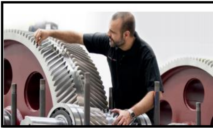
Figura 34: Instalación de caja de engranajes.
