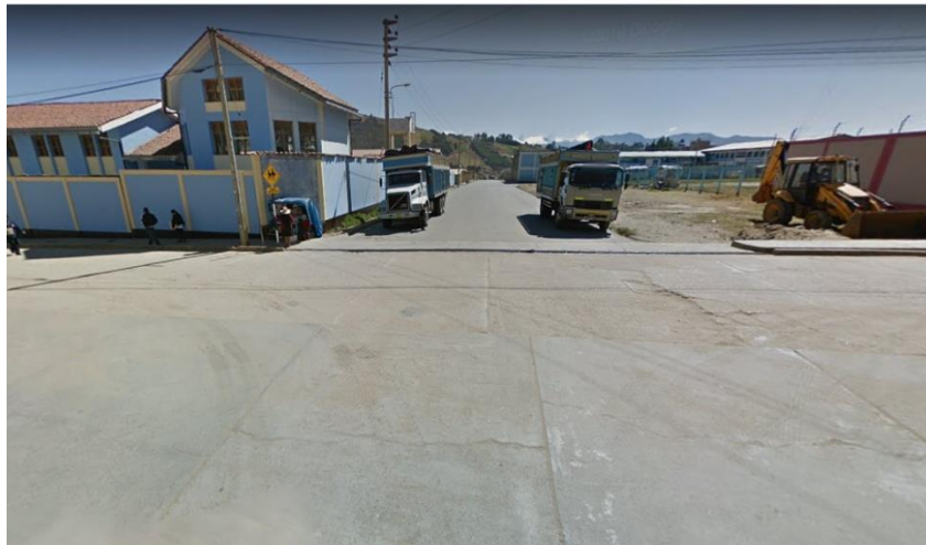
Figura N° 02. Estado Actual Av. Trujillo, Huamachuco.
