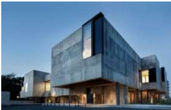
Figura 1 Vista del exterior del edificio
