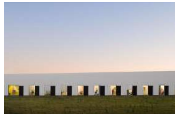
Figura 20 Vista desde el patio interior
