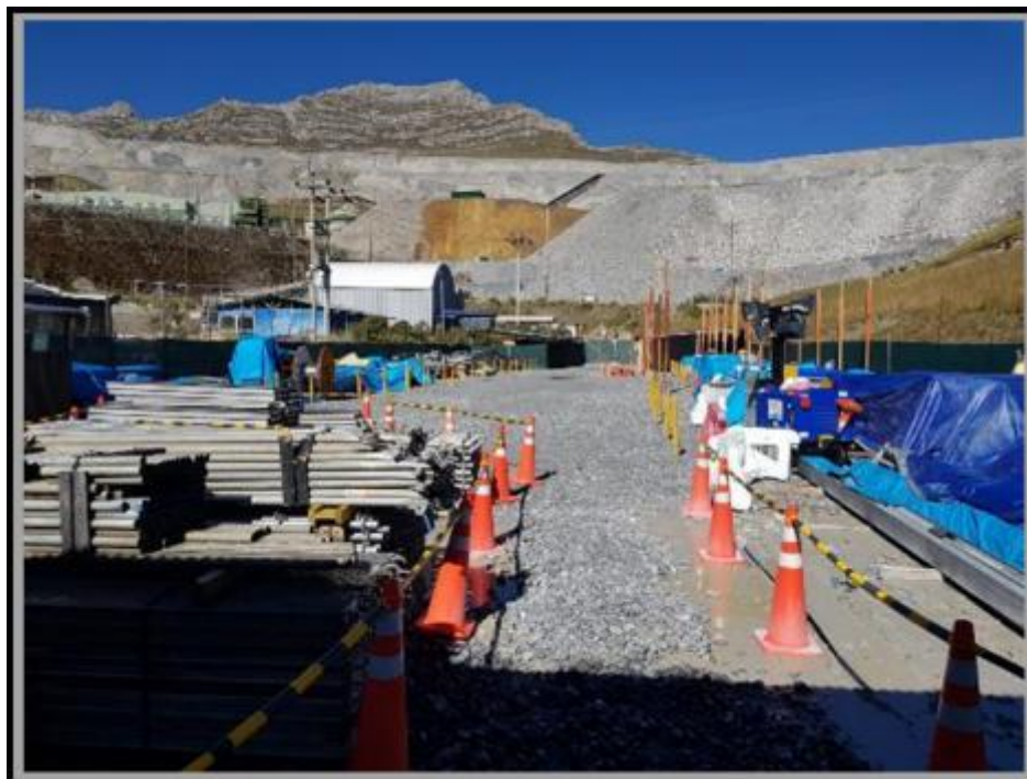
Figura 9. Diagnóstico de observación almacén de campamento Antamina. Fuente: Elaboración propia
