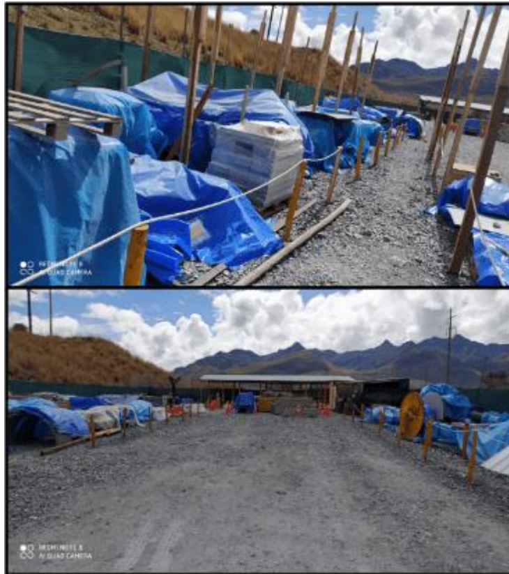
Figura 50. Evidencia de falta de señalización en almacén. Fuente: Elaboración propia
