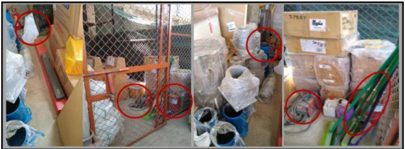
Figura 49. Evidencia de falta de señalización y obstrucción de extintores en almacén. Fuente: Elaboración propia
