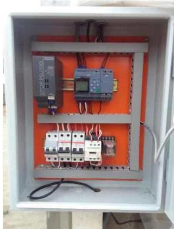
Tablero de control de humedad del prototipo n°2, sistema compuesto por un PLC Siemnes modelo Logo 8.
