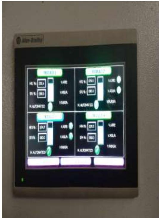
Tablero de control con pantalla HMI de la cámara humidificadora.
