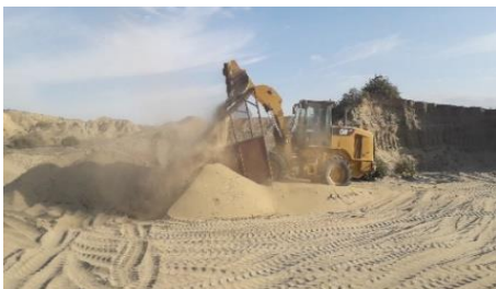
Figura 5 SERNIDO DE ARENA CATODICA PARA LOS TANQUES DE ASC
