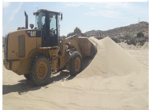
Figura 4 PROCESO DE RECABE DE ARENA CATODICA PARA TANQUES ASC
