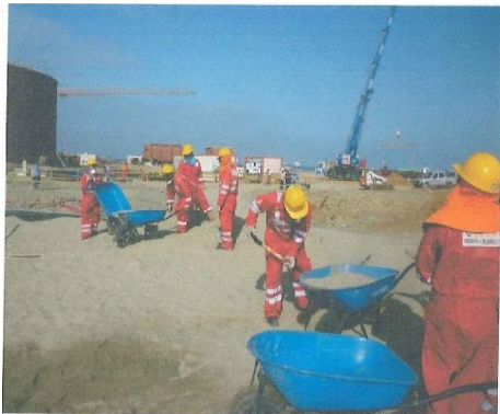
Figura 3 PROCESO DE ESPARCIDO DE ARENA CATODICA EN LA BASE DONDE IRA SENTADA EL TANQUE DE ACS
