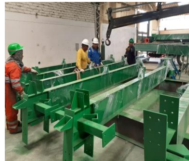
Figura 4. PROCESO DE RETIRO DE VIGAS CON CAMION GRUA
