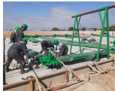
Figura 6. IDENTIFICACION DE VIGAS MARCAS PARA SOPORTE DE TECHO
