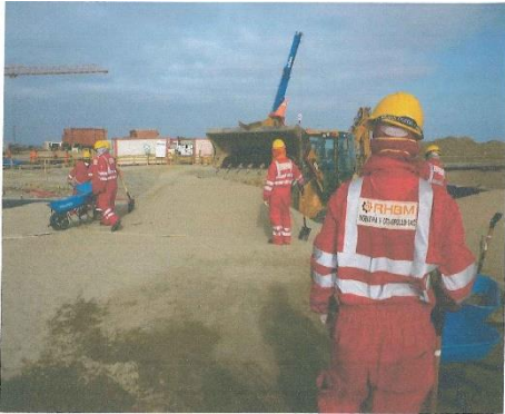
Figura 1 PROCESO DE ESPARCIDO DE ARENA CATODICA A LA BASE DONDE IRA ASENTADA AL TANQUE ACS
