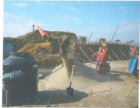
Figura 2 PROCESO DE ESPARCIDO DE ARENA CATODICA EN EL INTERIOR DE LA BASE DONDE IRA SENTADO EL TANQUE DE ACS
