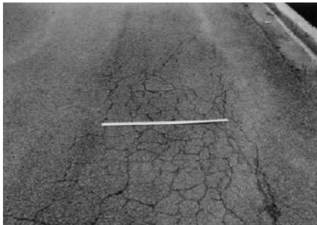
Figura 6: Piel de cocodrilo - severidad media
