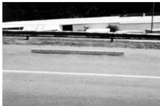
Figura 18: Corrugación - severidad media
