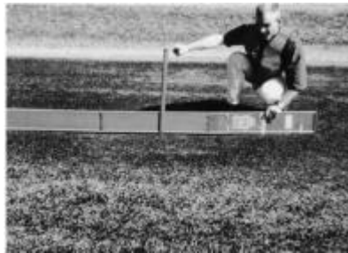
Figura 20: Depresión - severidad baja
