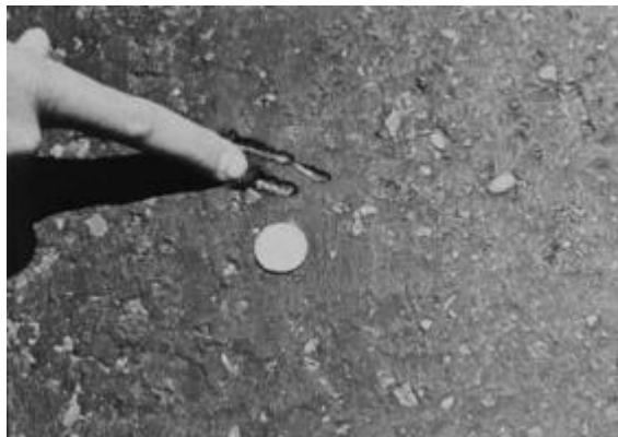
Figura 9: Exudación - severidad media
