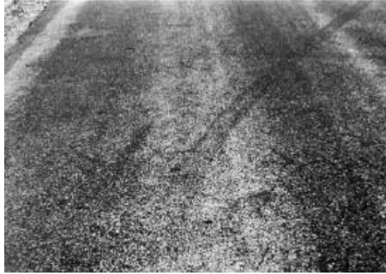
Figura 8: Exudación - severidad baja
