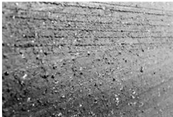
Figura 10: Exudación - severidad alta
