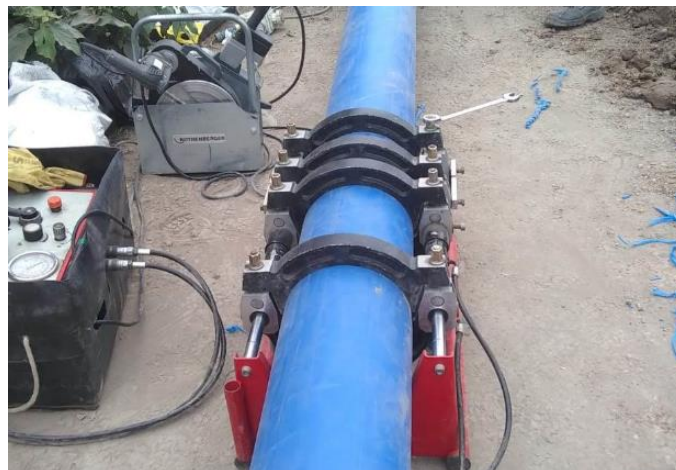
Figura N° 7. Fijación de tubos en maquina
