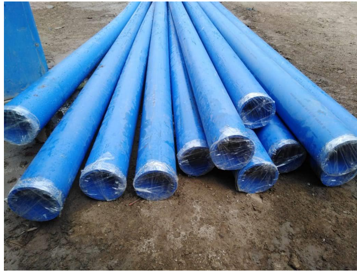
Figura N° 25. Tapado de tuberías
