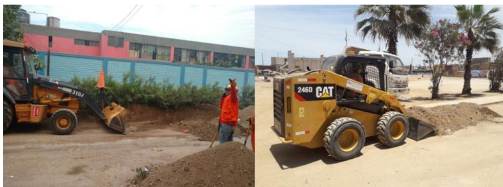
Figura N° 43. Limpieza y acopio de material
