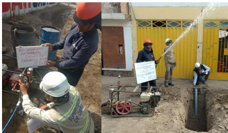
Figura N° 33. Prueba Hidráulica
