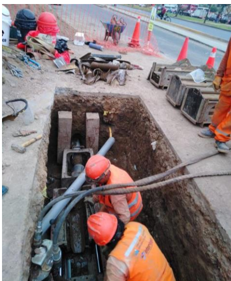
Figura N° 27. Instalacion de maquina Pipe Bursting
