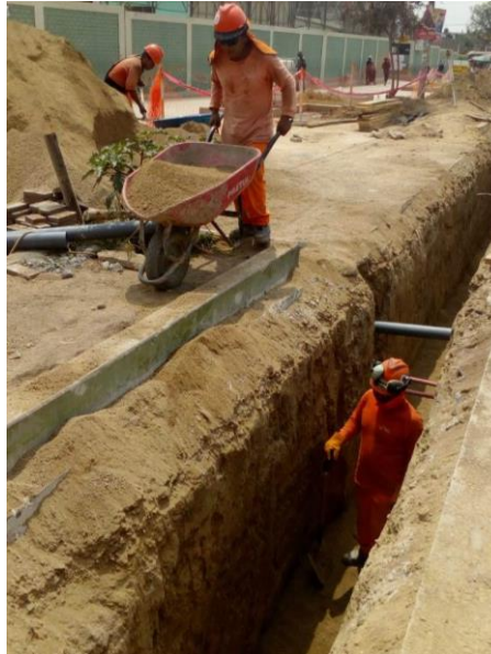
Figura N° 38. Colocación de cama de apoyo
