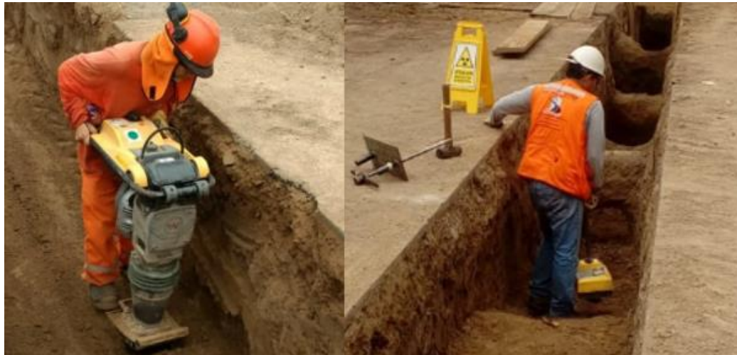
Figura N° 42. Proceso y prueba de conformidad de compactación.
