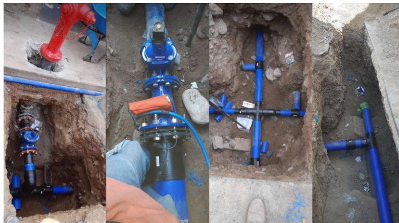
Figura N° 32. Instalación de Hidrantes, Válvulas, Cruz y Tee
