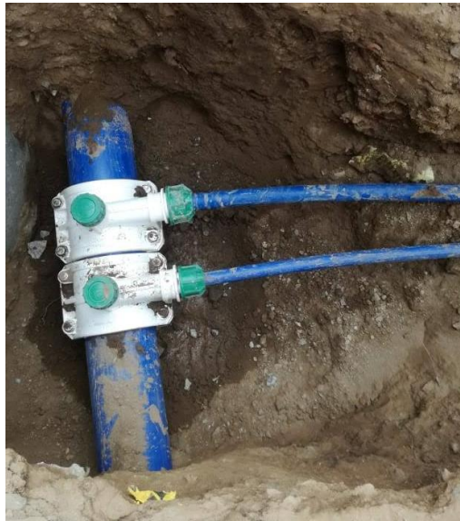
Figura N° 31. Instalación de abrazaderas
