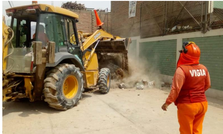
Figura N° 37. Trabajos de excavación
