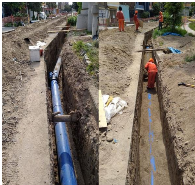
Figura N° 39. Colocación de cama de apoyo e instalación
