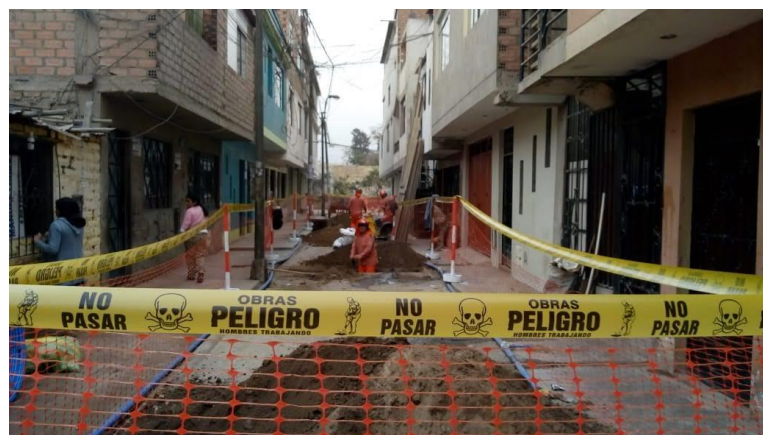
Figura N° 30. Excavación de conexiones
