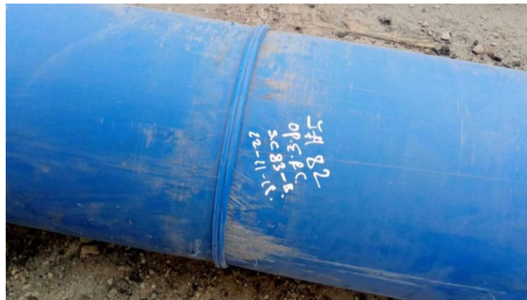
Figura N° 9. Pega por termofusión
