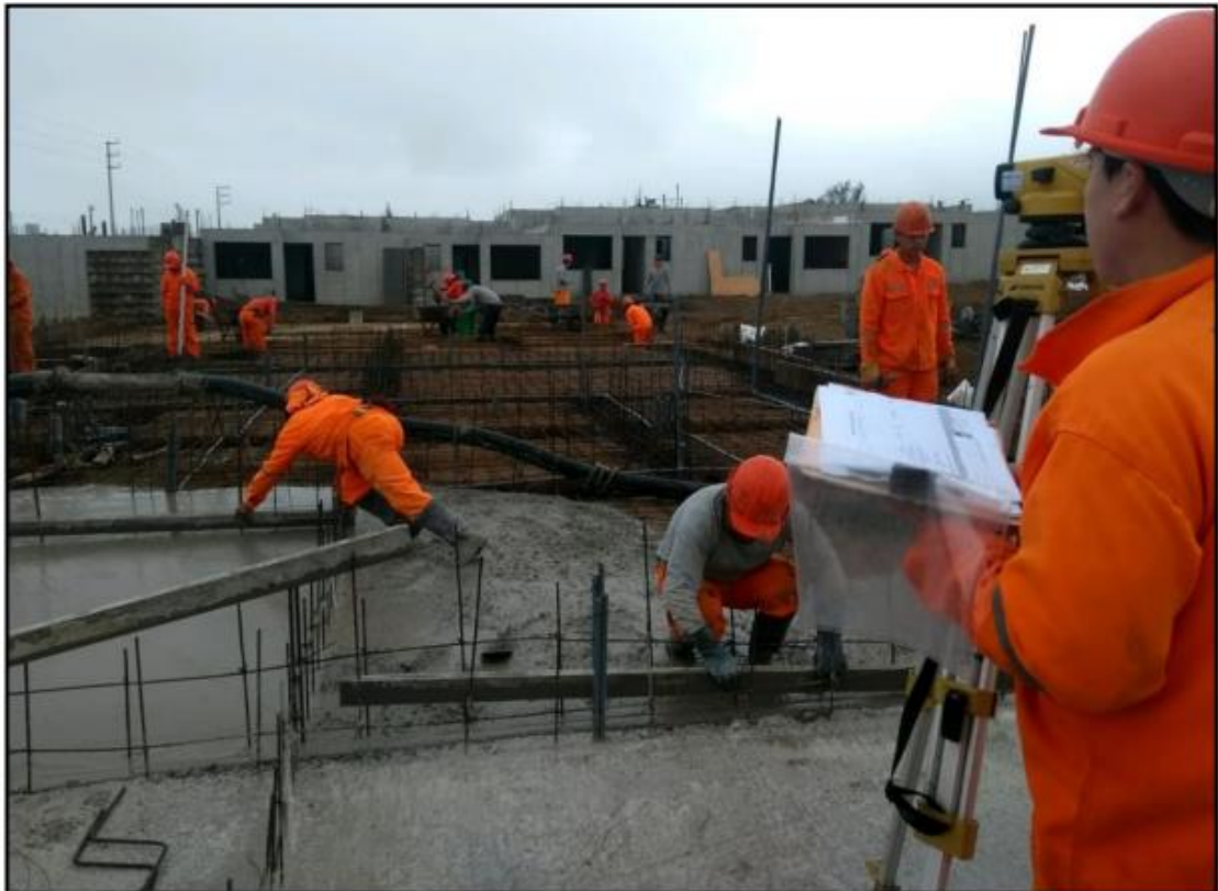
Figura 18. Control de Calidad de concreto fresco, Fuente: Palacio E. Estudio de pre factibilidad para el montaje de una planta de concreto premezclado en las instalaciones de la cantera de Colombia, en el municipio de Pereira (2019)
