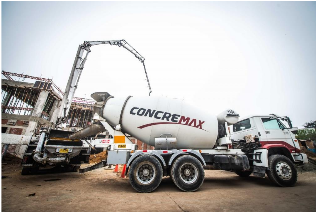
Figura 22. Camión mezclador Concremax en Obra
