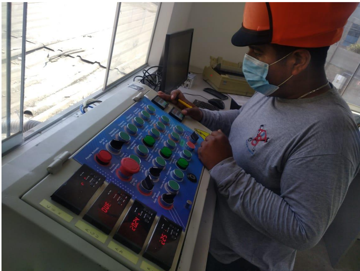
Figura 6. Servicios de mantenimiento a consola de control manual, de fabricación propia.
