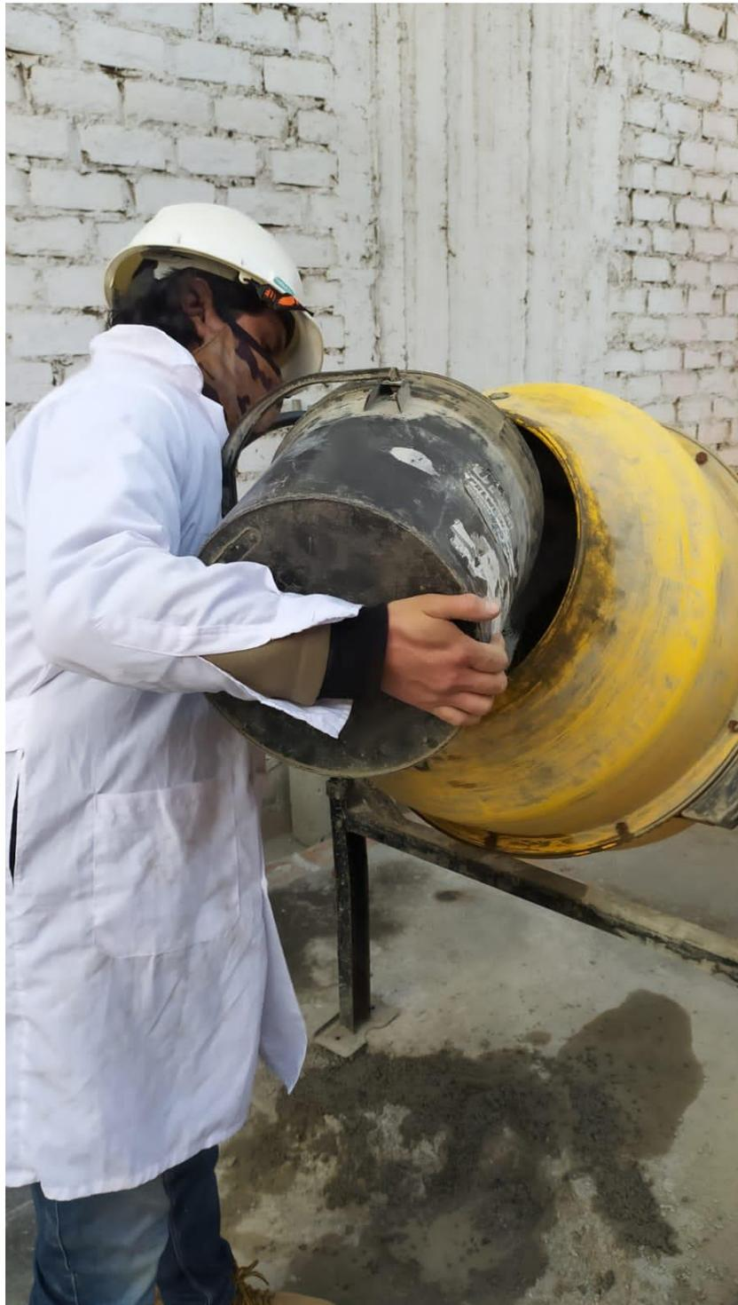
*Figura 56: Vertiendo el agua en el trompo*
