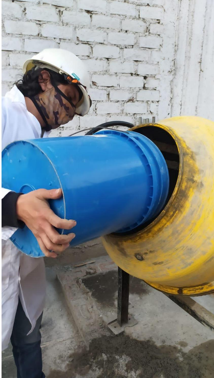
*Figura 59: Vertiendo el cemento portland tipo I*
