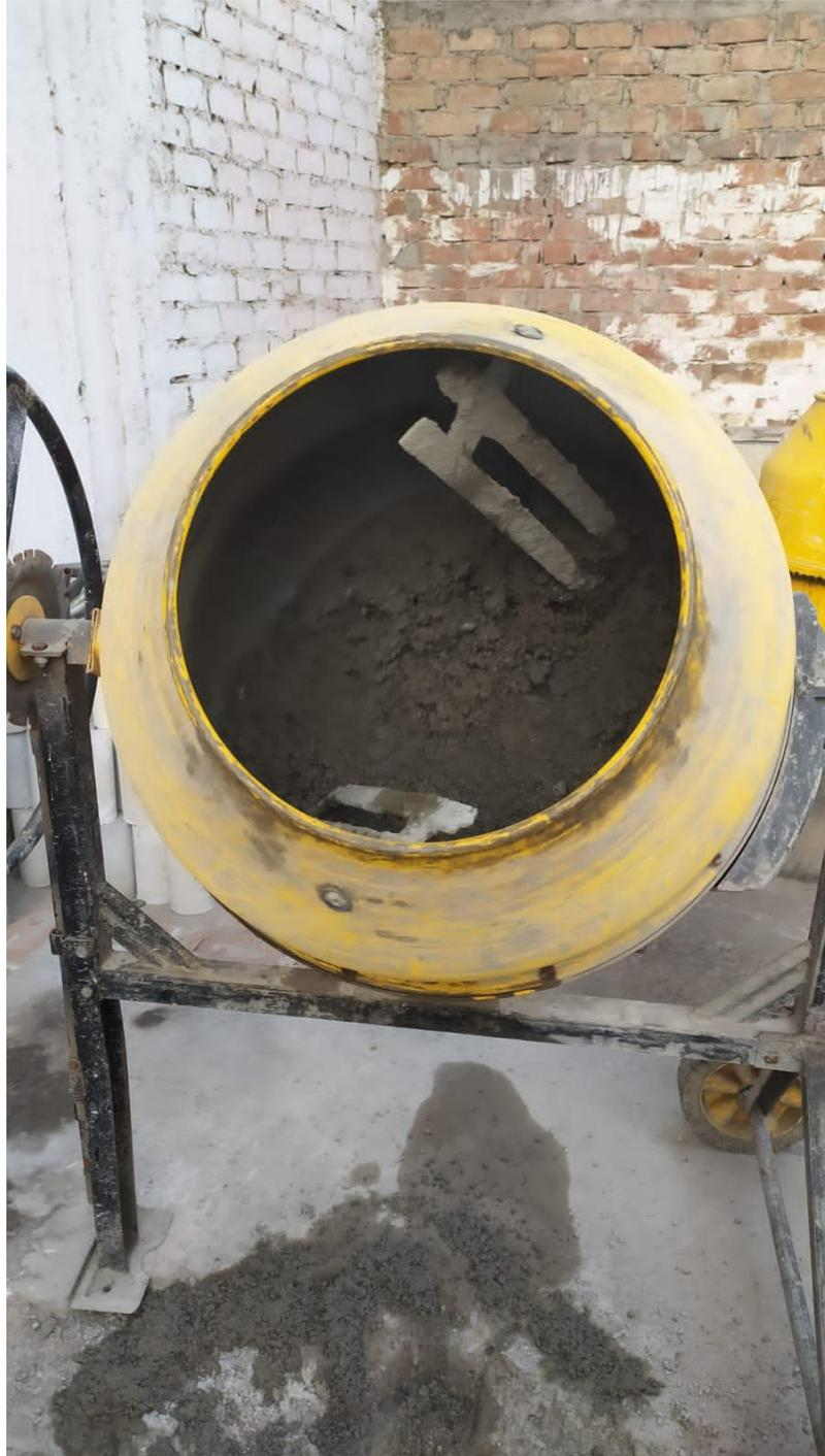
*Figura 60: Elaborando el concreto en el trompo*
