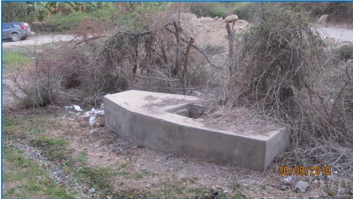
Fotografía 1. Caja de ingreso de la planta de tratamiento de aguas residuales Fuente: Expediente Técnico (Rehabilitación de los Servicios de Agua Potable, Alcantarillado y Planta de tratamiento de aguas residuales en la Localidad Huambo, Distrito Leoncio Prado, Provincia Huaura, Departamento Lima)
