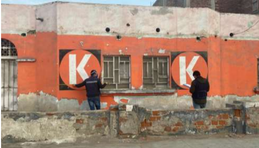
Foto N° 05: Toma de medidas referenciales para plano de elevaciones
