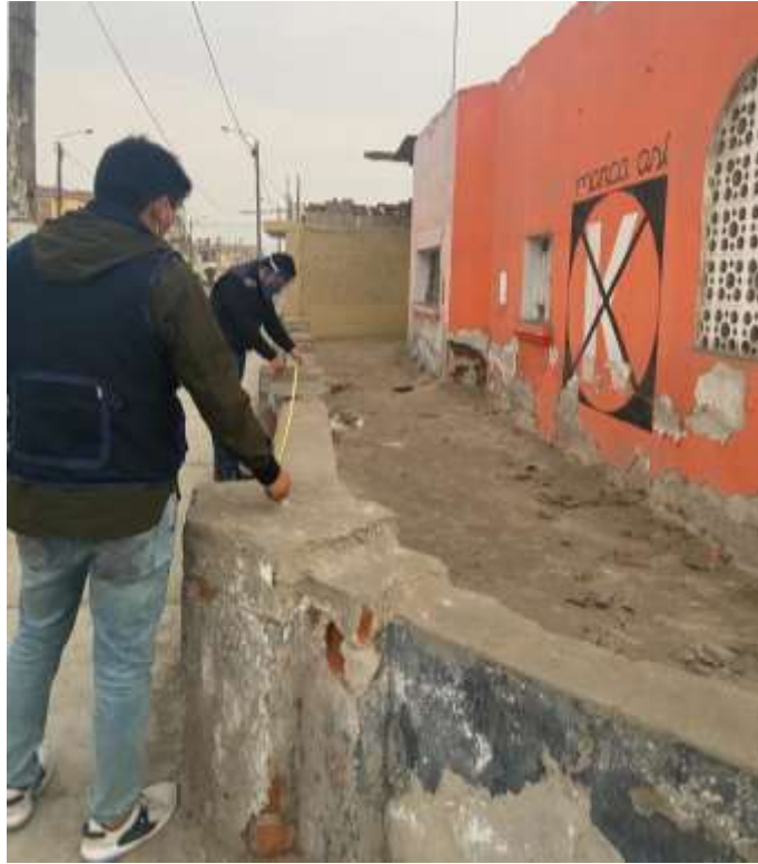
Foto N° 09: Toma de medida de longitud del cerco perimétrico vista posterior
