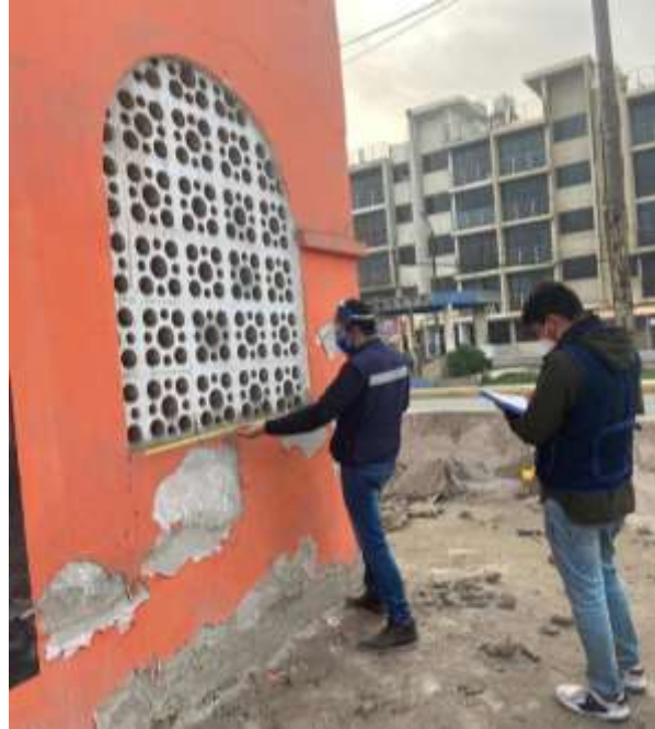
Foto N° 01: Medición de ventanas a reemplazar.
