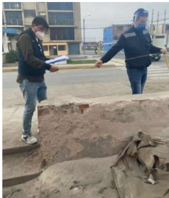
Foto N° 08: Toma de medida de longitud del cerco perimétrico vista anterior
