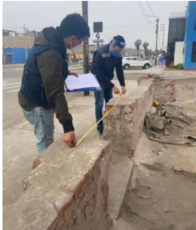
Foto N° 07. Longitudes de la entrada principal
