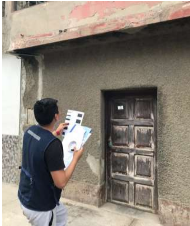
Foto N° 03: Utilización de regla para medir espesor de fisuras y grietas
