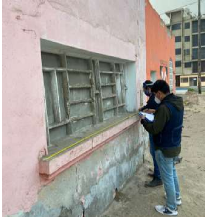
Foto N° 03: Medidas de vanos posteriores a reemplazar
