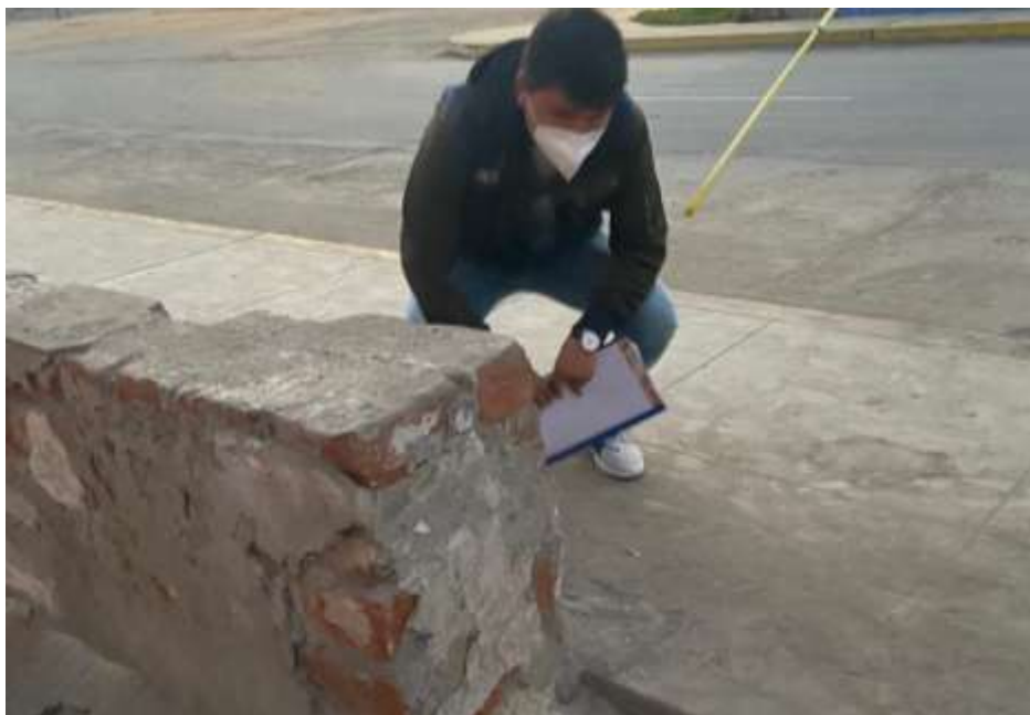
Foto N° 06: Medidas del cerco perimétrico
