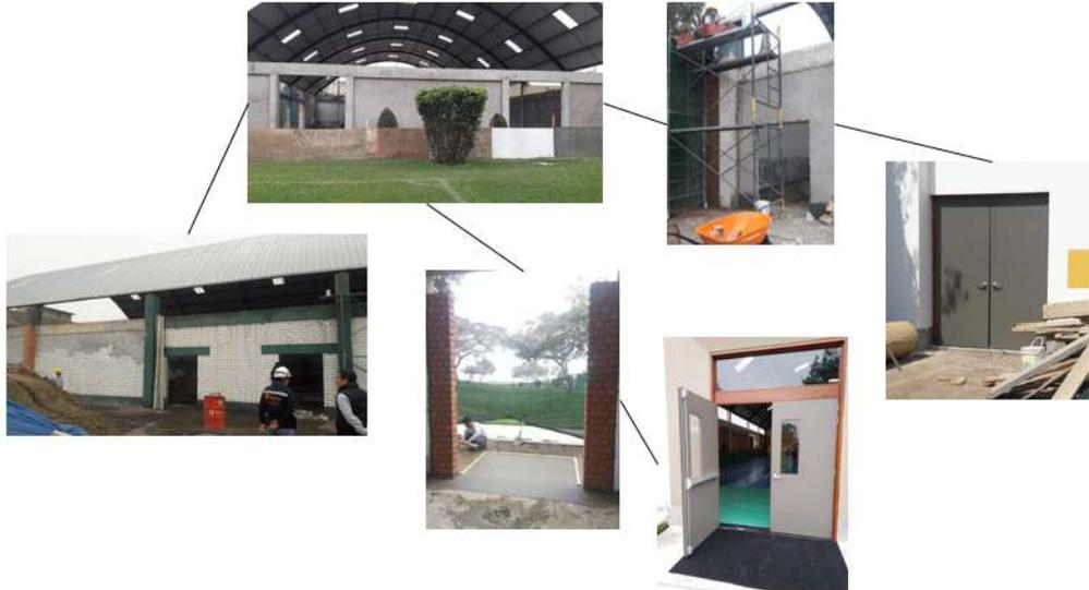
*Figura N° 42 Remodelación de los vanos de evacuación*
