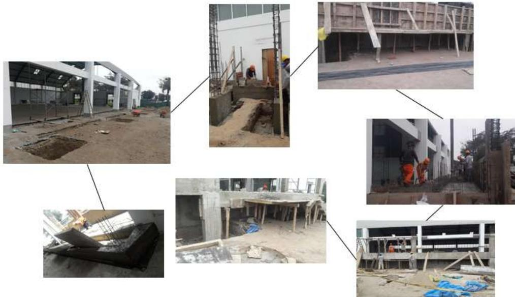
*Figura N° 48 Excavaciones, armado y vaciado de estructuras*
