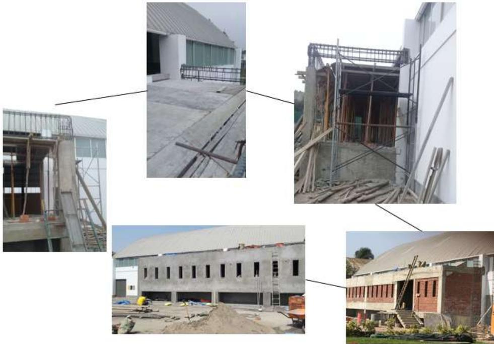
*Figura N° 49 Anclaje de la nueva estructura con la existente*
