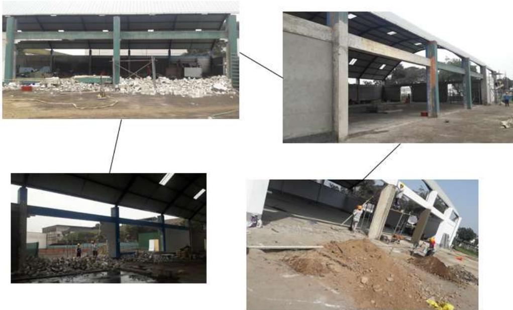
*Figura N° 47 Demolición para ampliación de tribunas*
