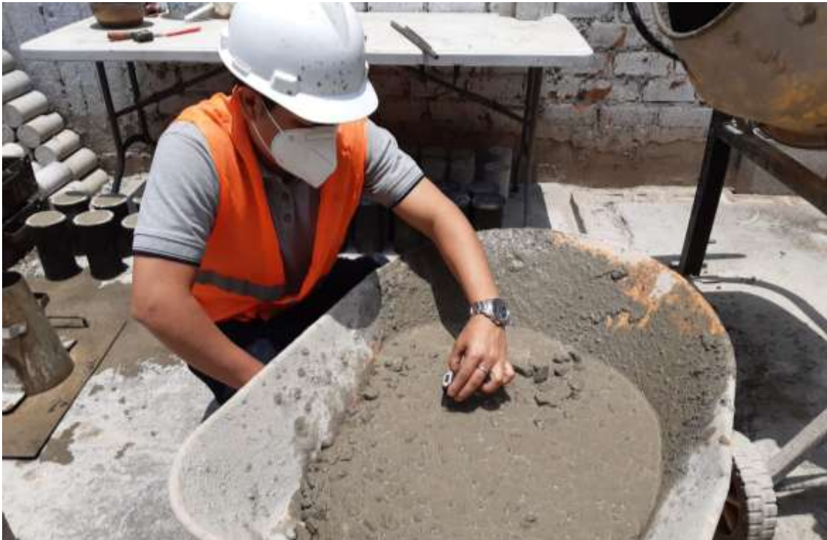
Figura N° 39: Ensayo de temperatura del concreto.
