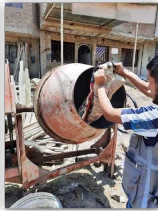
Ilustración 30.- Vaciado del cemento.
