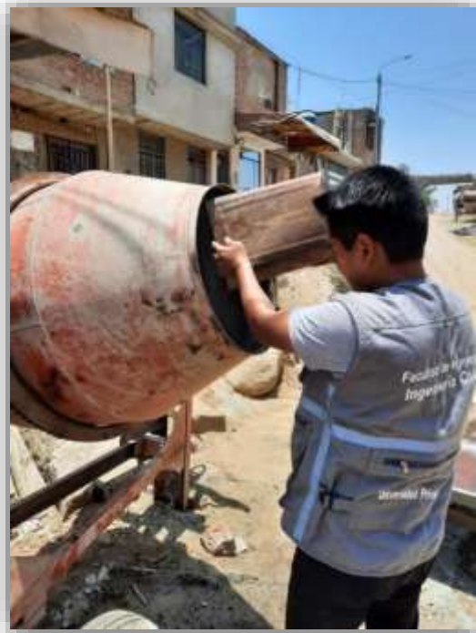
Ilustración 31.- Vaciado de los agregados al trompo
