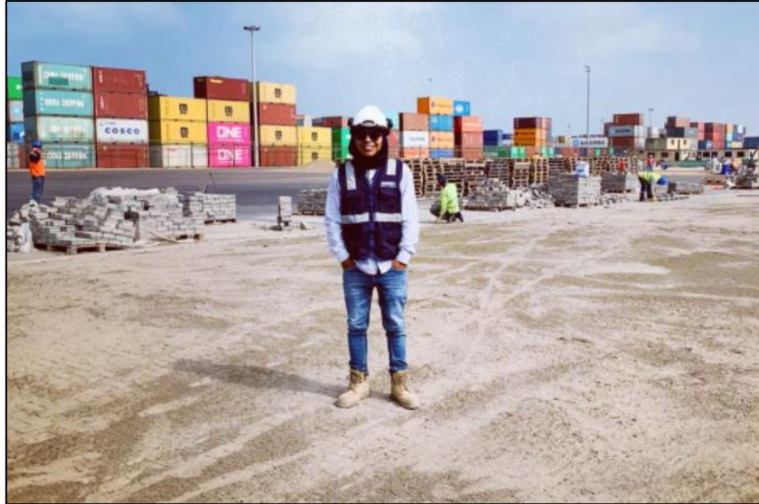
Figura 7 Pavimentación de Ransa Fox Trop
