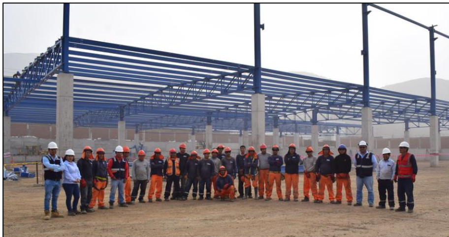
Figura 6 Construcción bloque "H"
