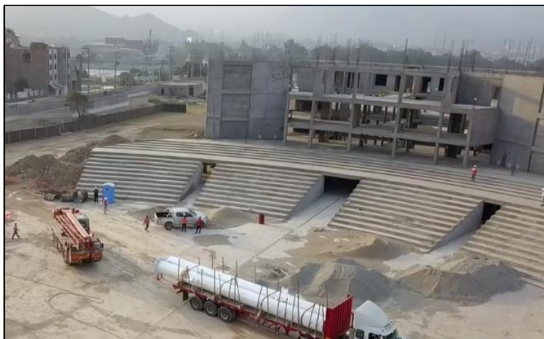
Figura 8 Supervisión de construcción de Nuevo Templo
