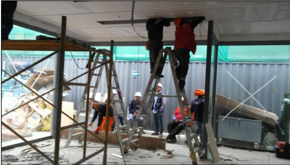
N°5: Instalación subterránea
