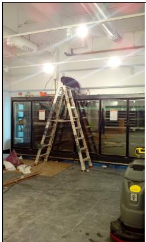
N° 6: Instalación equipo de frío
