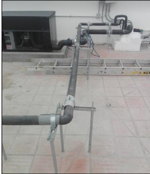
N° 1: Trenzado de tubería
