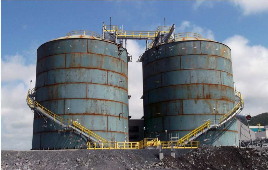
Figura n.o 25 Tanques verticales con los anillos soldados.
