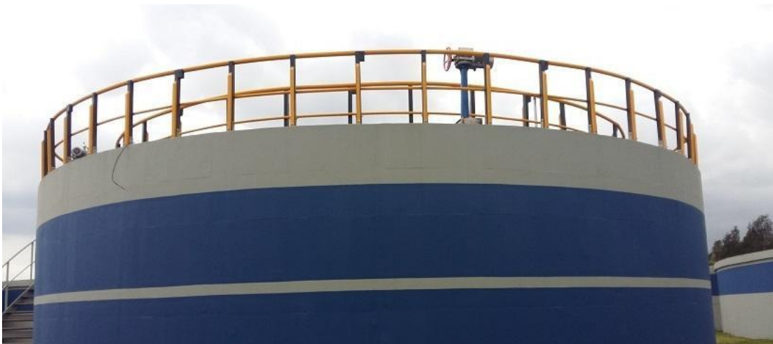
Figura n.o 26 Barandas de seguridad de tanques de almacenamiento.
