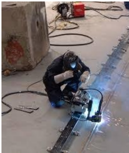
Figura n.o 33 Máquina de soldadura automática.
