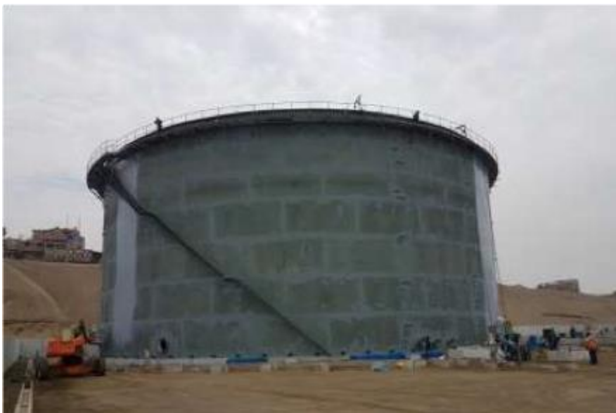
Figura n.o 23 Proceso de pintado del tanque.
