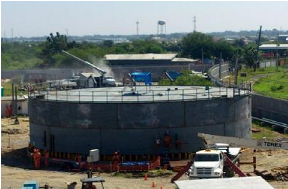
Figura n.o 37 . Izaje de anillos de un tanque.
