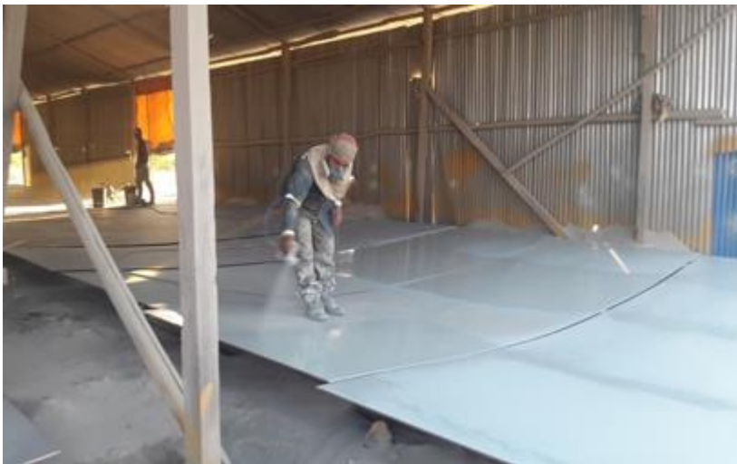
Figura n.o 22 Imprimación de planchas con Zinc Inorgánico – JET ZINC I860
