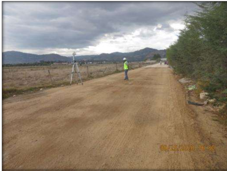
Imagen 7. Fin de aplicación con agua y registro de material particulado.
