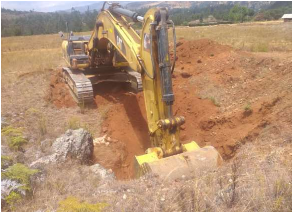
Figura N° 03: Construcción de calicatas, con la ayuda de una excavadora 336-DL.
