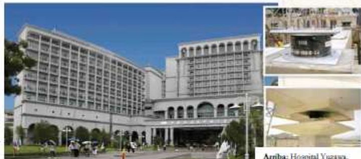
Arriba: Hospital Yuzawa, Japón. Debajo: Un deslizador instalado en el Hospital Takasu, Japón.
