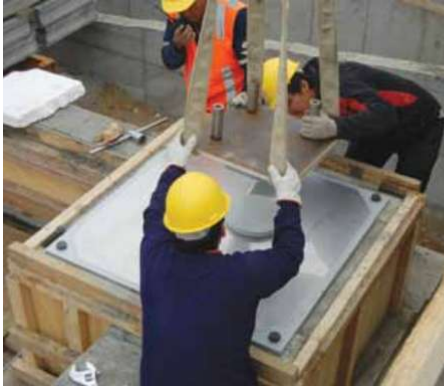
Figura 8: Apoyo deslizante Plano
