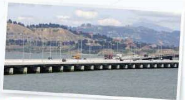
Puente San Rafael en Richmond: Dynamic Isolation Systems ha desarrollado y fabricados soportes para puentes para Caltrans con una mayor resistencia a la corrosión. Los soportes se encuentran dos metros por encima de la línea de flotación y se fabricaron con una baja permeabilidad del caucho y fabricados en acero inoxidable.
