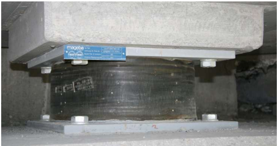
Figura 7: Aislador HDRB.
