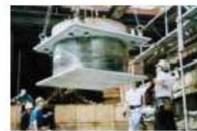
Instalación de un aislador de 1500mm de diámetro para el Condominio High City Kyosumi en Japón.
