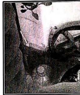
Imagen 01 : Se visualiza fisura de 4mm aprox. en primer nivel de predio piso y alfeizer de jardín interior.
