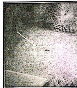
Imagen 02 : Se visualiza fisura de 2 mm aprox. en límite jardín – muro ( en fondo de predio)
