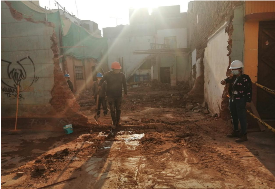
Figura 12. Trabajos de inspección en obra
