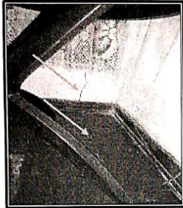
Imagen 01 : Se visualiza fisura de 4mm aprox. en primer nivel de predio piso y alfeizer de jardín interior.
