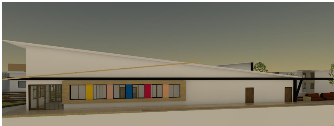
Figura 4.36: Vista de módulo de zona biblioteca
