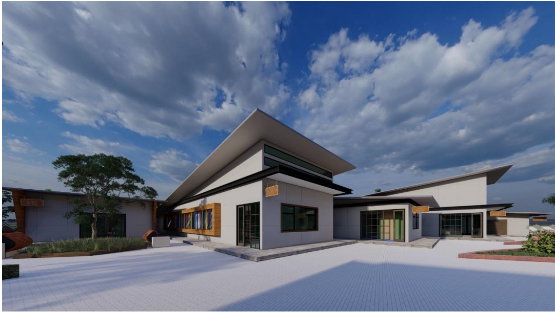
Figura 4.37: Vista zona Biblioteca
