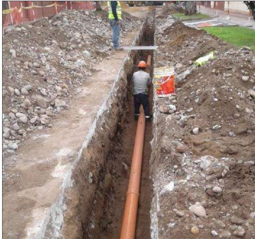
*Figura N°24: Tendido e Instalación de tuberías de PVC*
