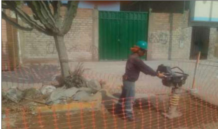
*Figura N°25:* Relleno y compactación de tramo.
