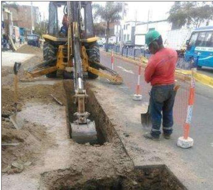
*Figura N°23:* Excavación de zanjas con retroexcavadora
