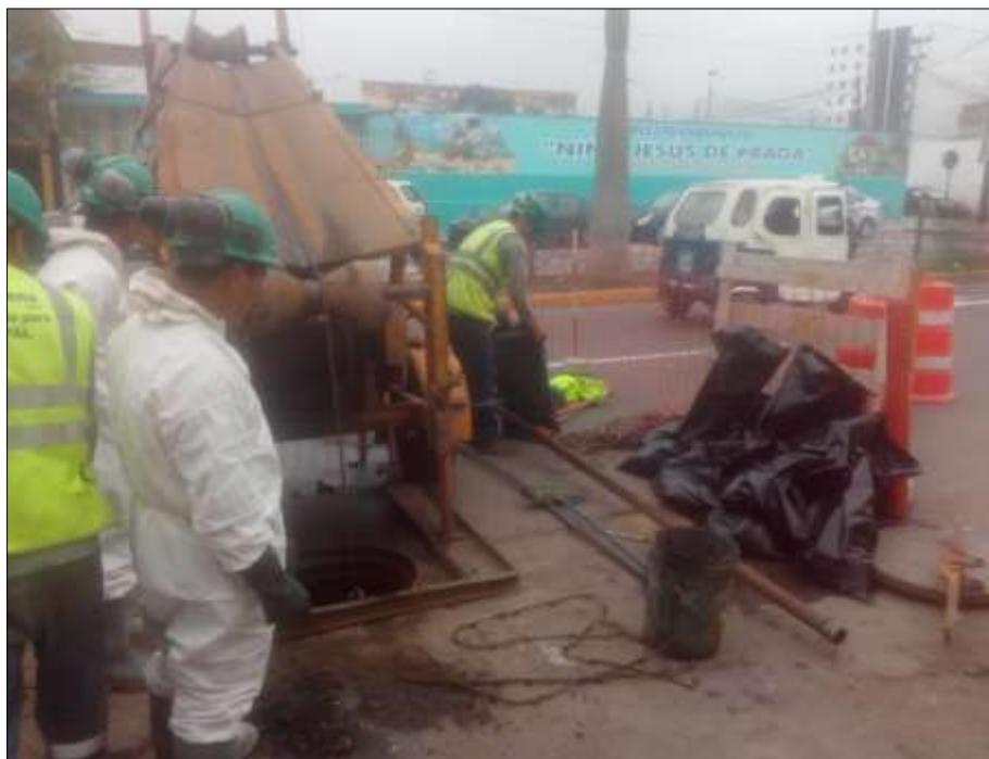
**Figura N°37:** Operario sacando material de Buzón
