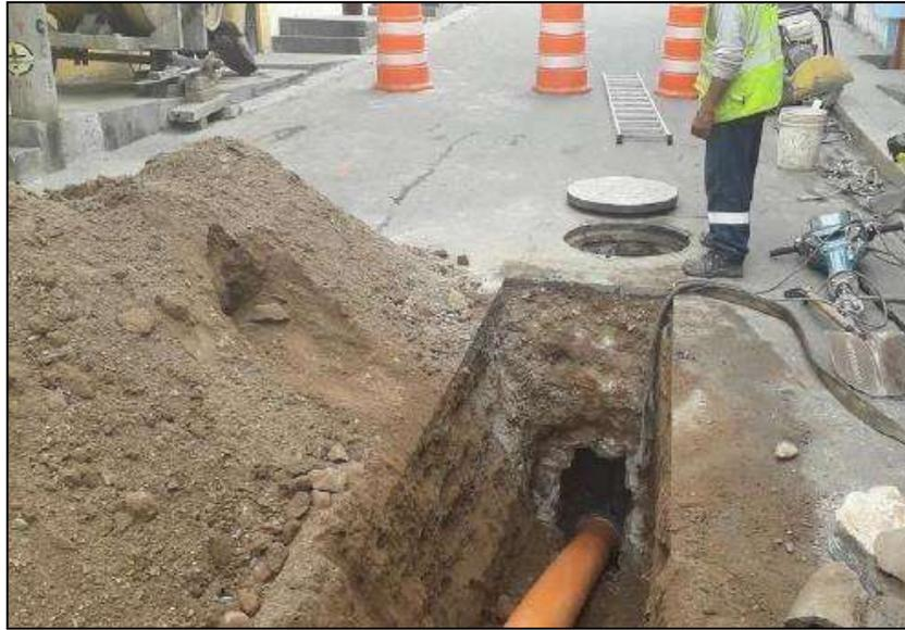
*Figura N°13:* Tubería del HDPE ingresado por tubería existente de CSN
