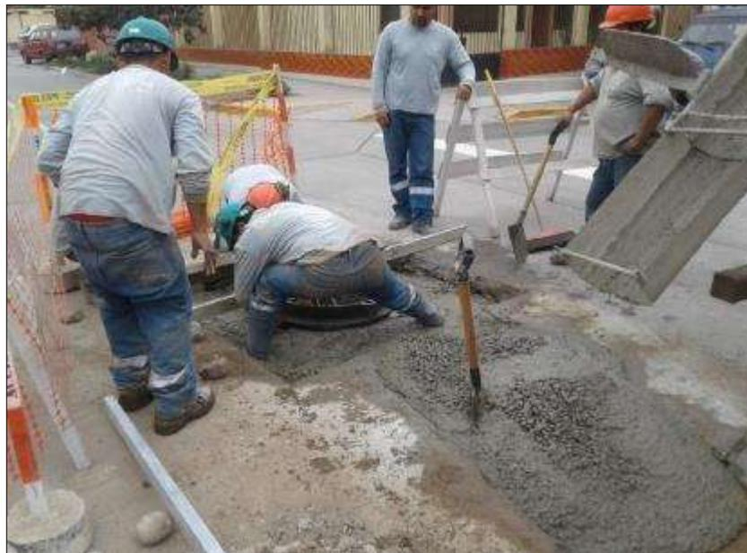
*Figura N°26:* Reposición de techo de buzón.
