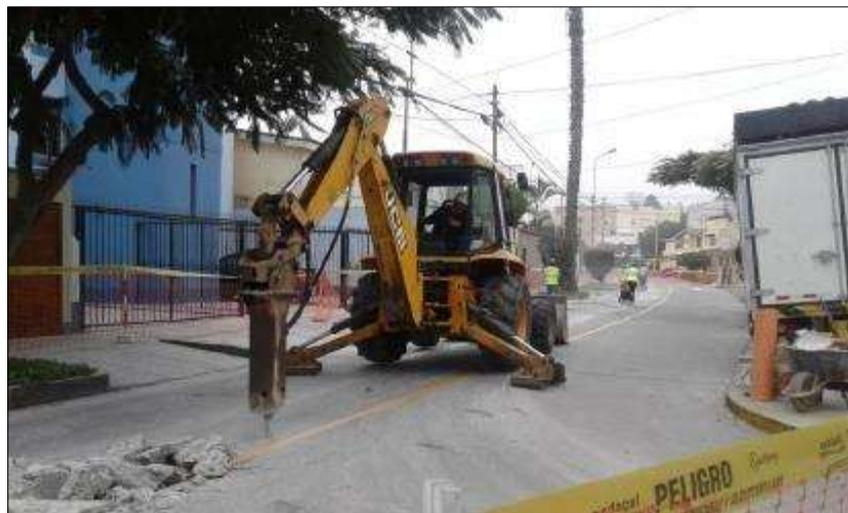
*Figura N°22: Rotura de pavimento con retroexcavadora*
