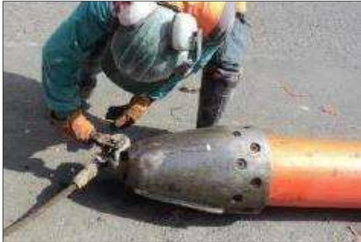
*Figura N°44:* Cabezal de rotura o expansor
