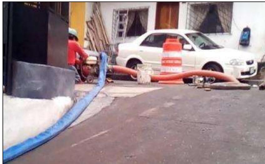
*Figura N°05:* Desvío de flujo existente con motobomba de 4”.
