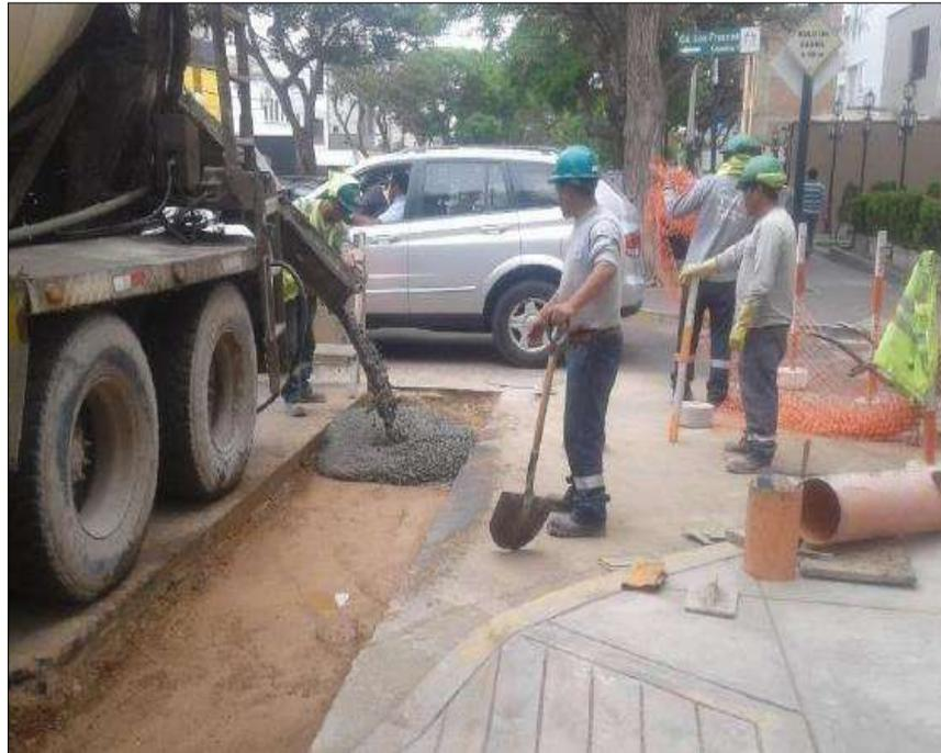
*Figura N°27:* Reposición de pista con concreto premezclado
