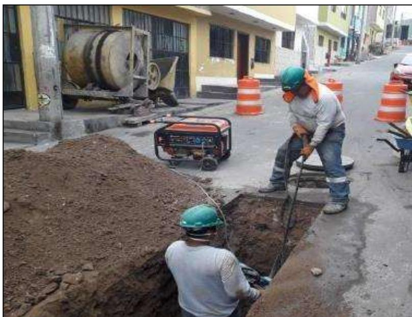
Figura N°04: Operarios demoliendo pared externa de buzón.
