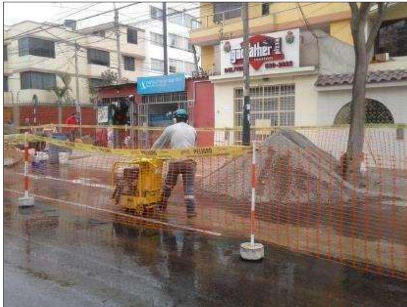
*Figura N°21: Corte de pavimento de concreto.*
