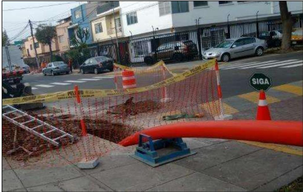
*Figura N°08:* Instalación de la tubería por la ventana de inserción.
