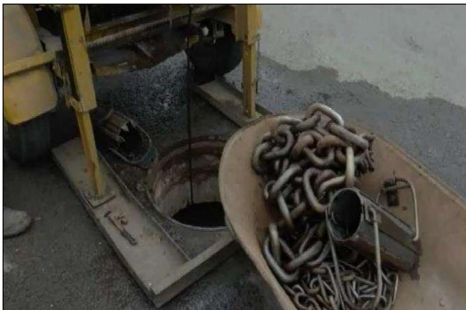
*Figura N°38:* Cadena y Balde – Máquina de Balde
