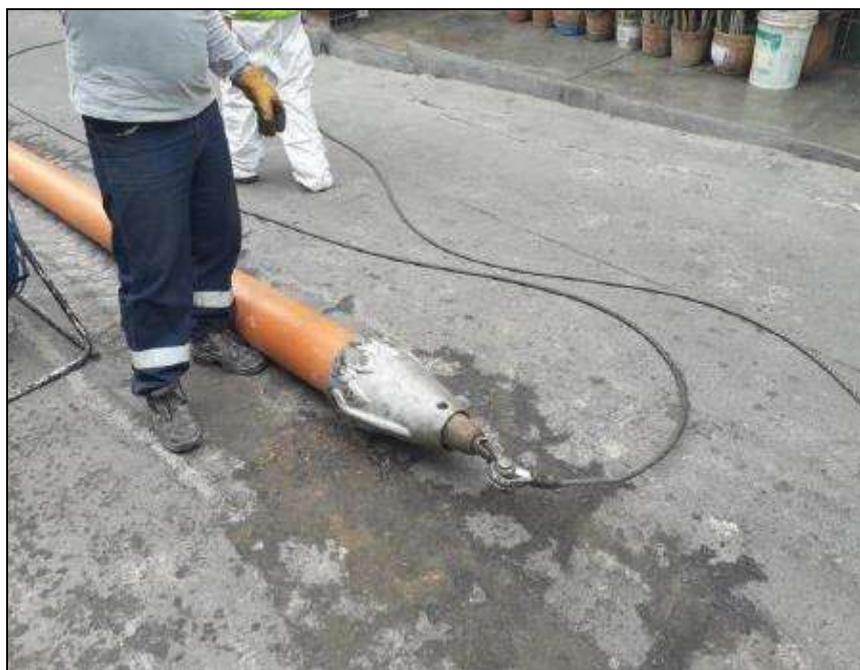
*Figura N°12:* Puesta del grillete a la montura del topo unido al cable del winch
