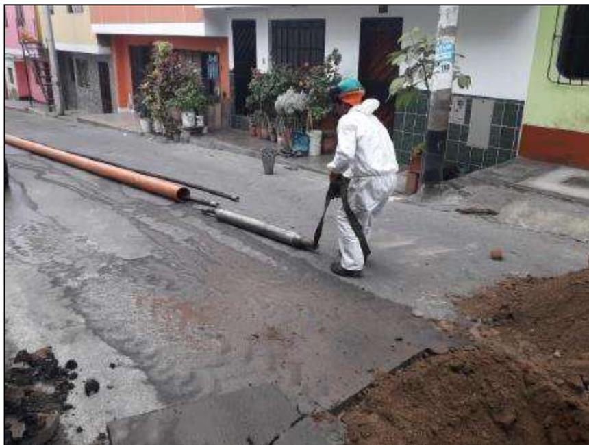
*Figura N°11:* Ingreso del Topo hidráulico por la tubería nueva de HDPE
