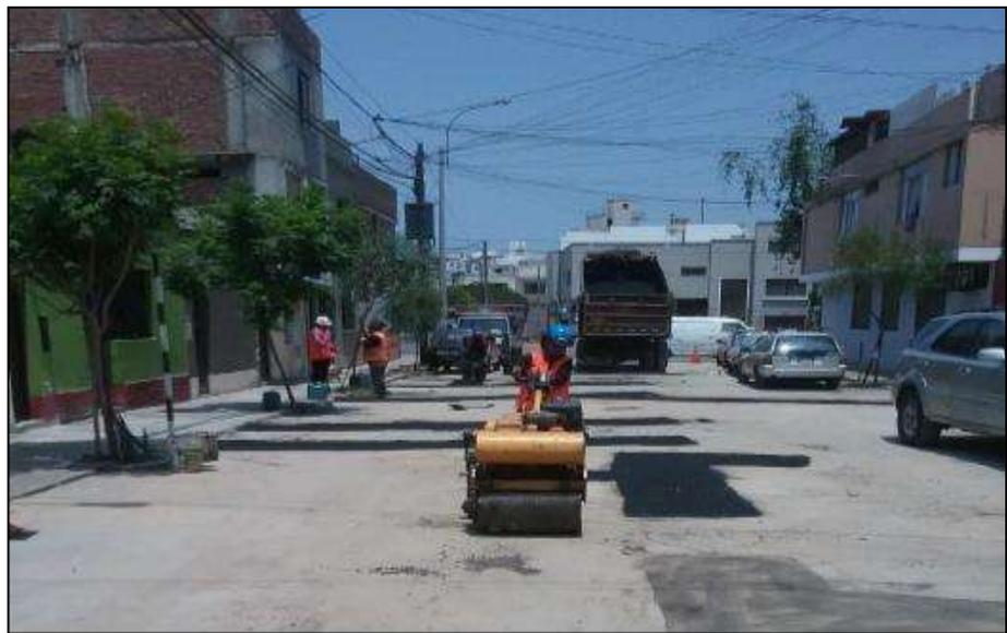
*Figura N°19:* Reposición de carpeta asfáltica en ventanas y conexiones
