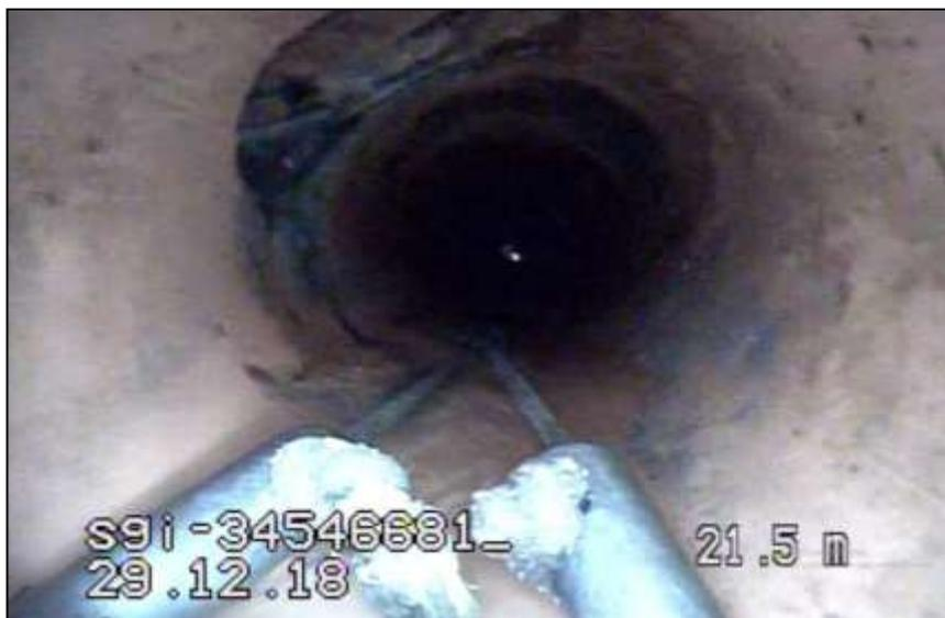
Figura N° 03: Inspección Televisiva – Tuberías de PVC.
