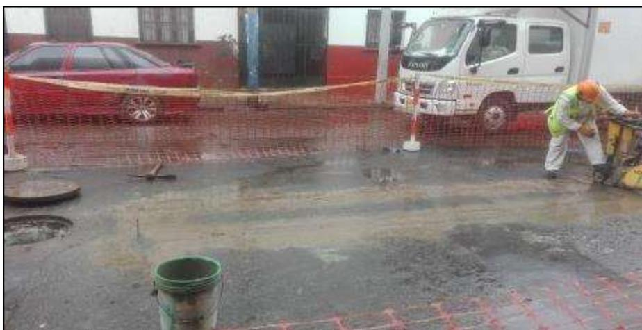
*Figura N°06:* Operario realizando el corte de la ventana de inserción.
