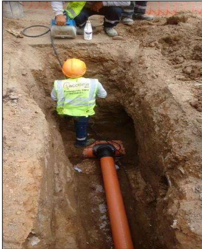
Figura N°16: Electrofusión de conexión con colector.
