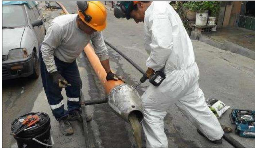
*Figura N°10:* Perforación de la tubería para empalmar el cabezal de rotura
