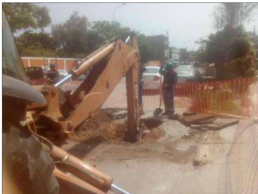
*Figura N°07:* Excavación de ventana con retroexcavadora y un vigía.
