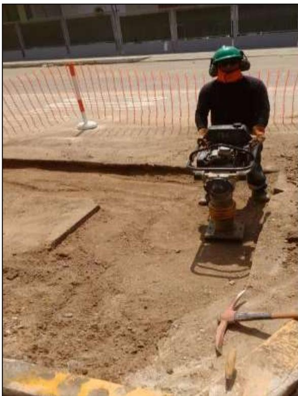
*Figura N°17: Compactación de conexión.*
