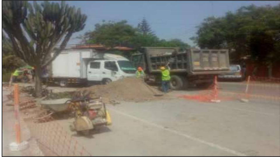
*Figura N°20: Limpieza y eliminación de material excedente a pulso.*
