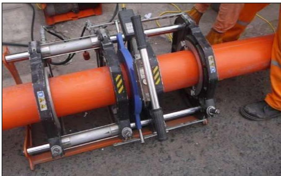
**Figura 35:** Colocación de plato calefactor
