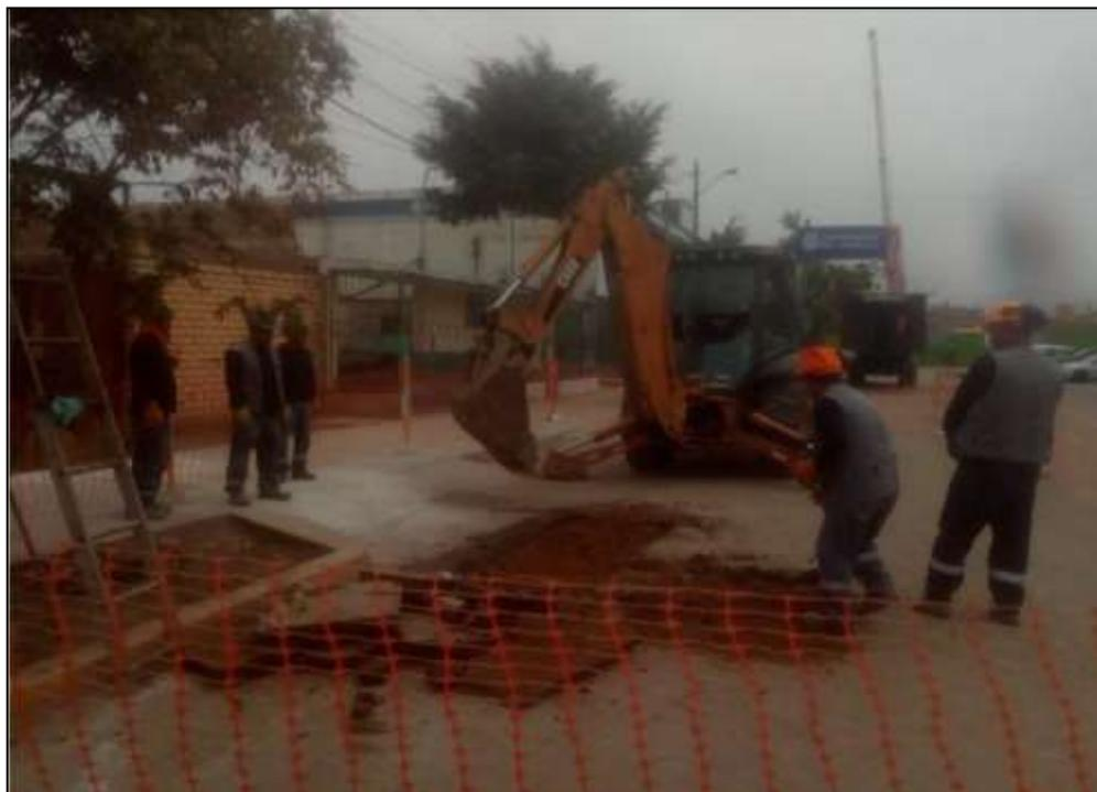
*Figura N°15: Excavación de Conexión*
