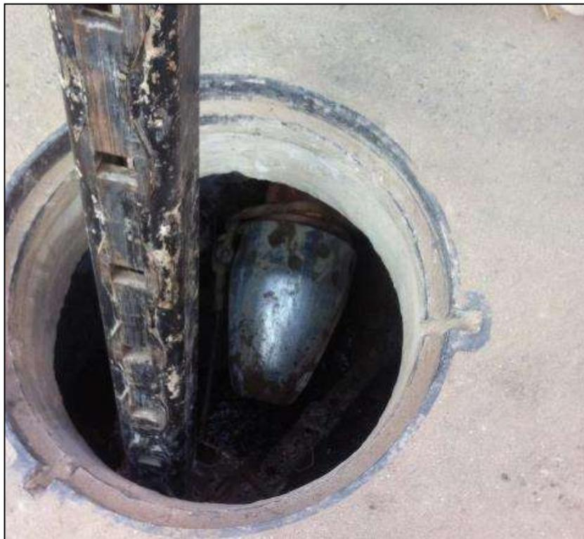
*Figura N°14:* Llegada de la tubería en el buzón de salida.
