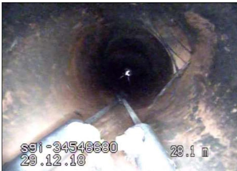
*Figura N°39:* Vista de la inspección televisiva en un colector de PVC
