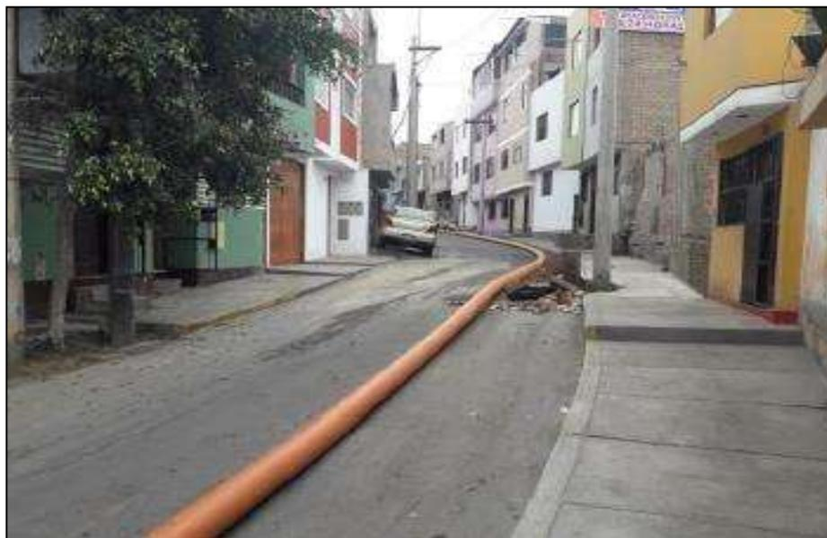
*Figura N° 02:* Tubería soldada de HDPE habilitada para la fragmentación
