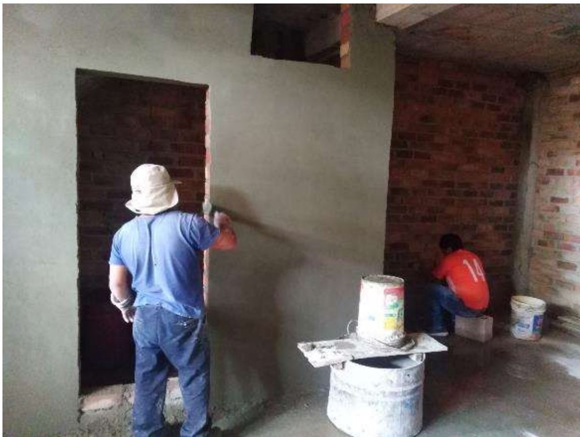
Figura 47. Acabado en muro de interiores vivienda N° 01.
