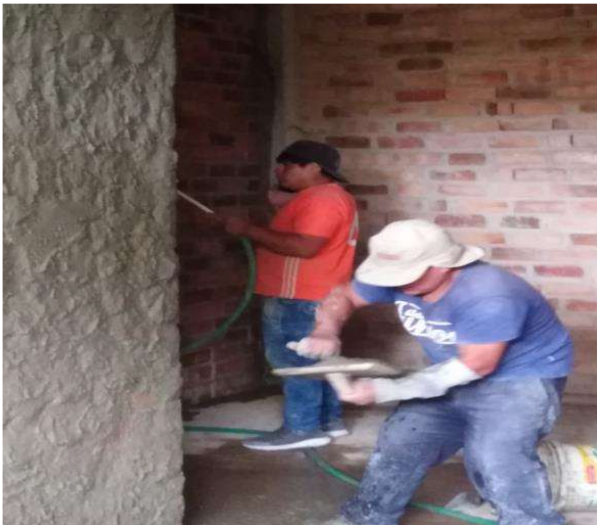
Figura 10. Se observa la colocación de mezcla en muro de interiores – Vivienda N° 01.
