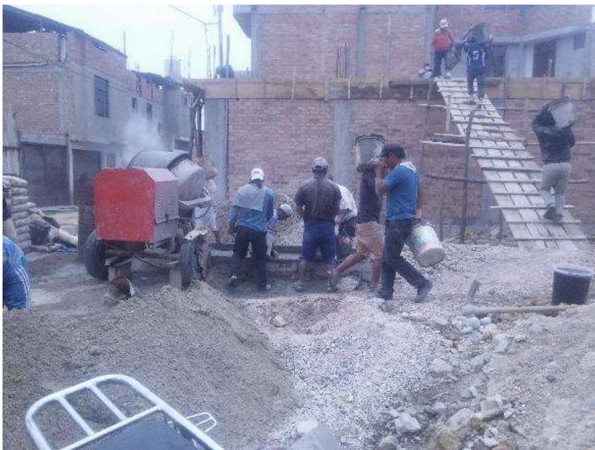
Figura 36. Preparación y traslado de mezcla vivienda N° 2.
