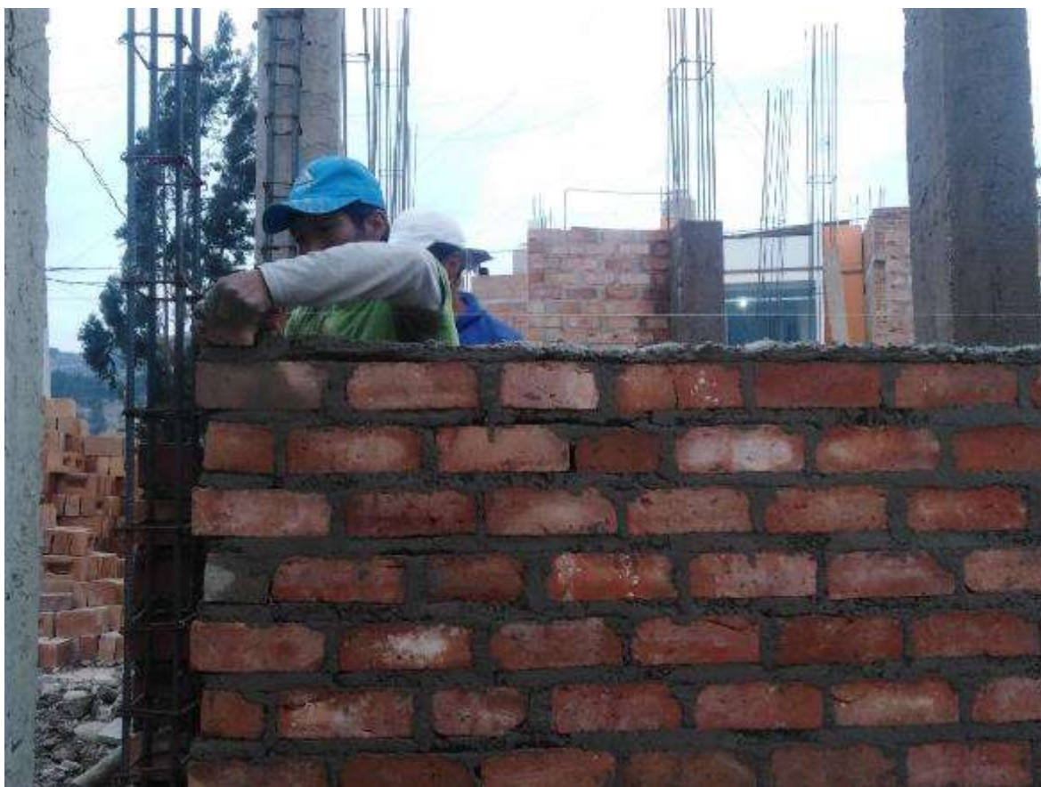
Figura 42. Se observa la actividad de colocación de mezcla en la vivienda N° 02.
