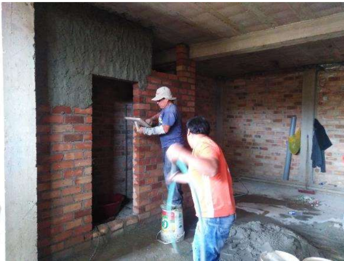
Figura 44. Traslado de mezcla para y colocado de mezcla Vivienda N° 01
