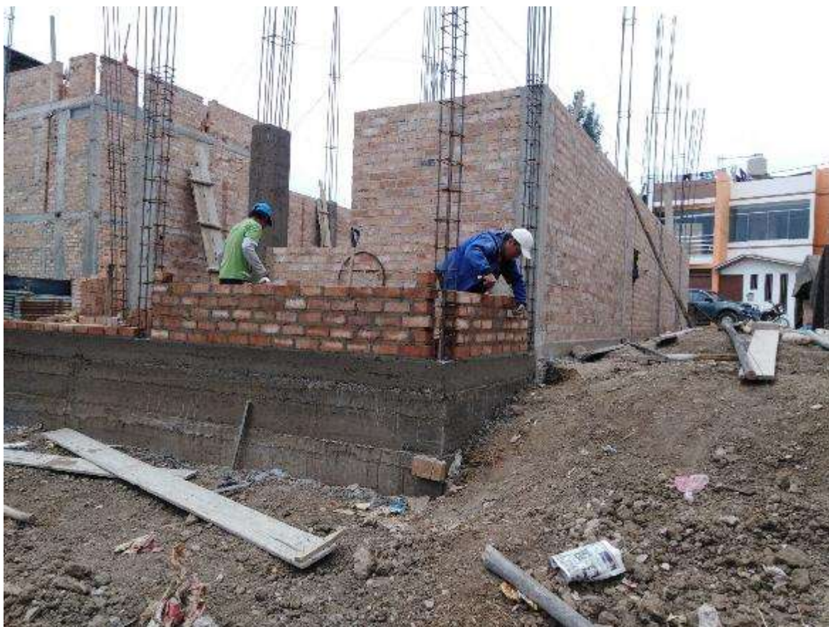
Figura 41. Verificación de acentado de ladrillo vivienda N° 2.
