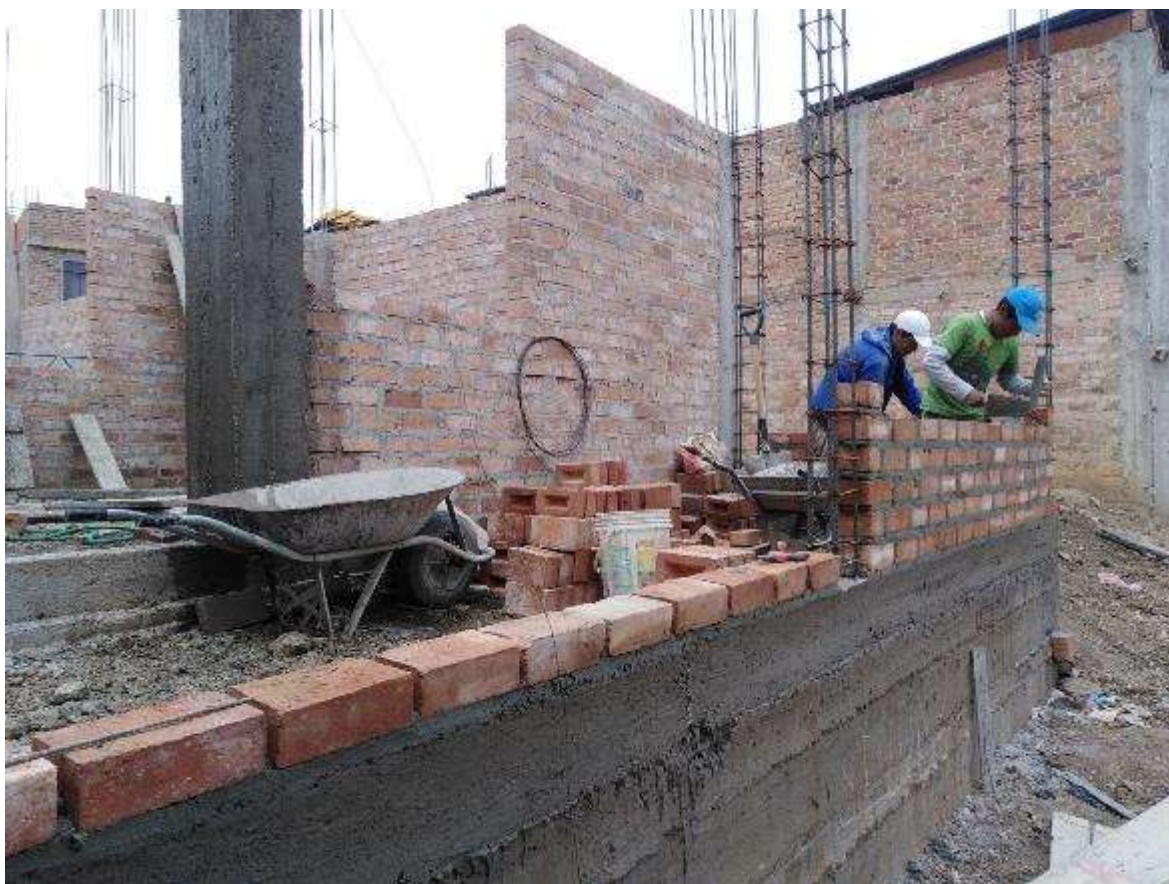
Figura 40. Plantillado de ladrillo vivienda N° 2.
