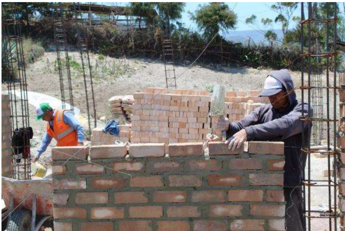
Figura 43. Enplantillado de ladrillo vivienda N° 3
