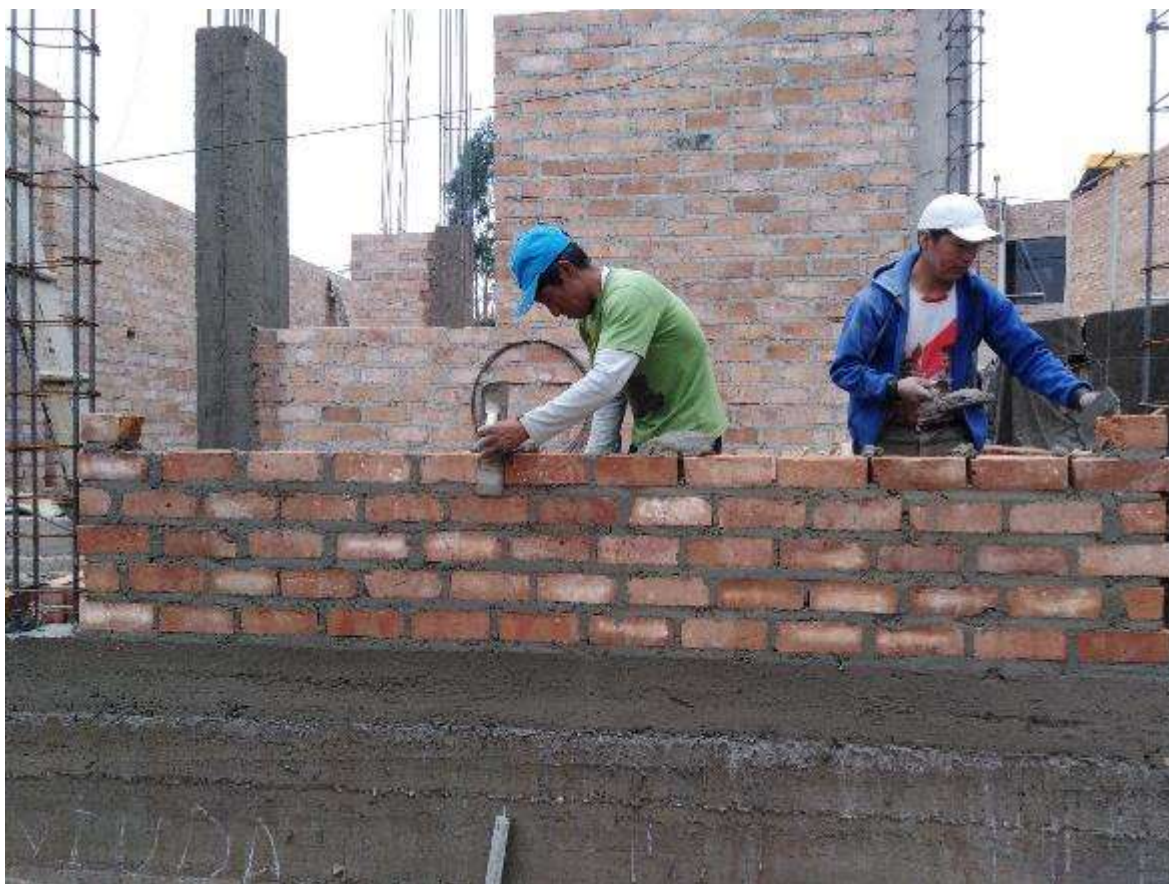
Figura 39. Acentado de ladrillo vivienda N° 2.
