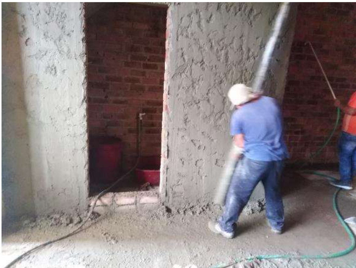
Figura 46. Reglado de muro en interiores en vivienda N° 01.
