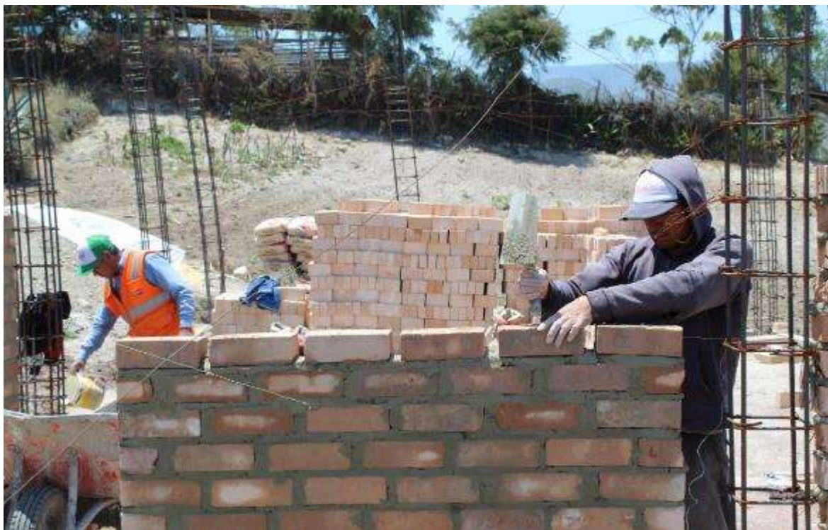
Figura 16. Se observa los muros de albañilería – Vivienda N° 02.
