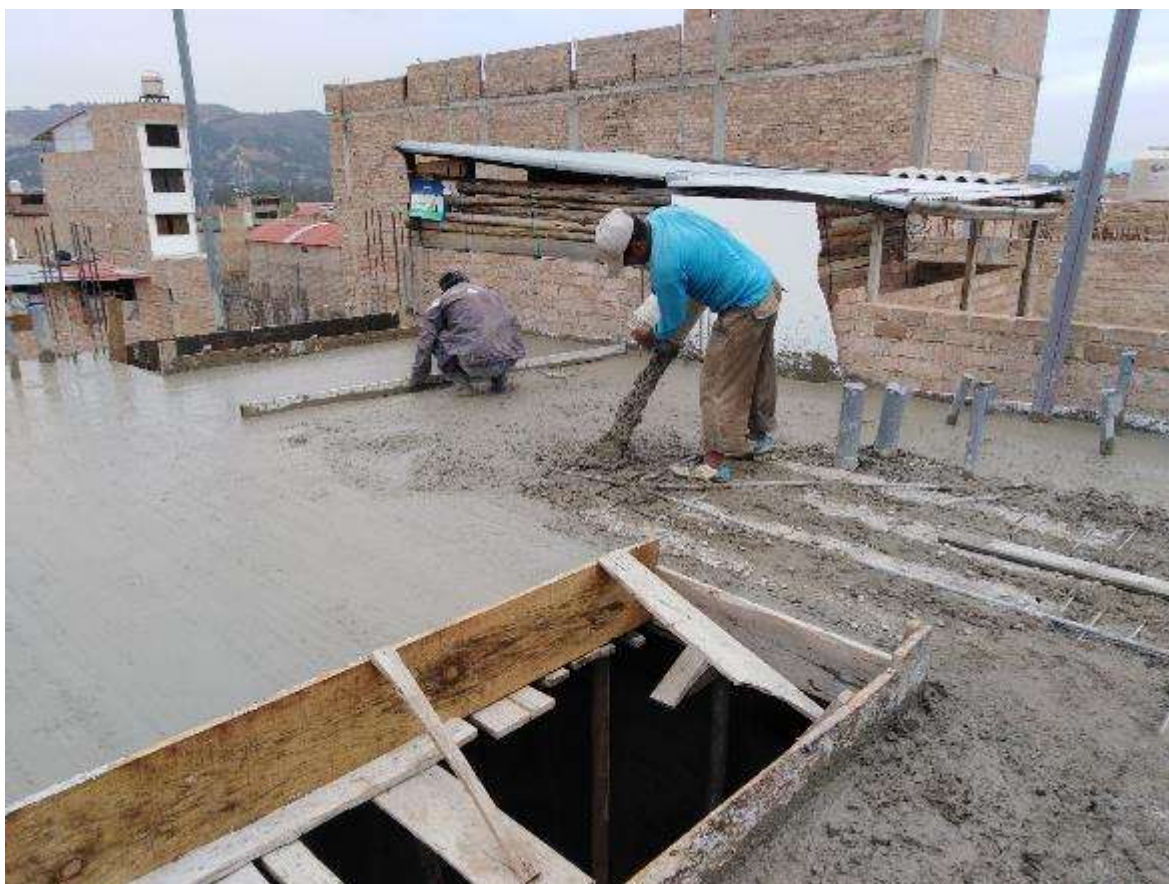
Figura 35. Vaciado de mezcla vivienda N° 3.
