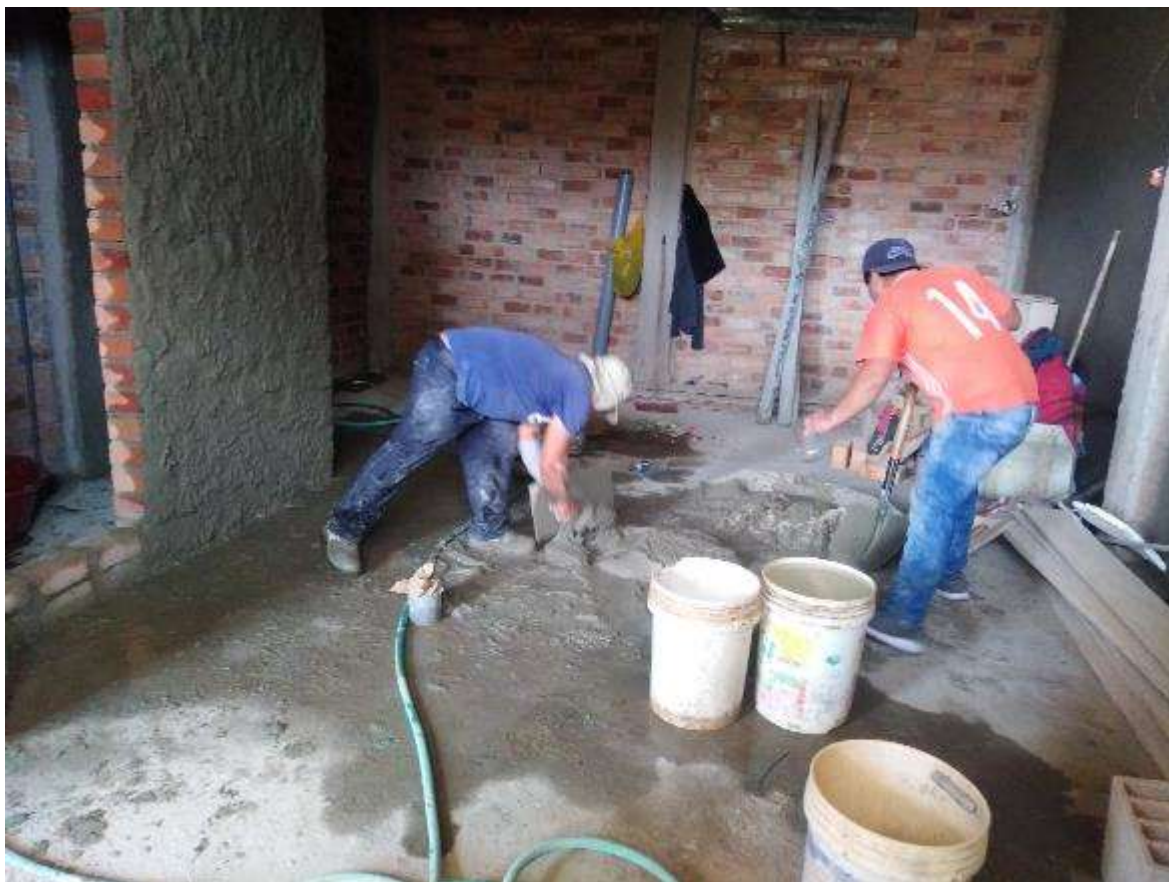
Figura 45. Elaboración de mezcla para tarrajoe de muro en interiores vivienda N° 01.
