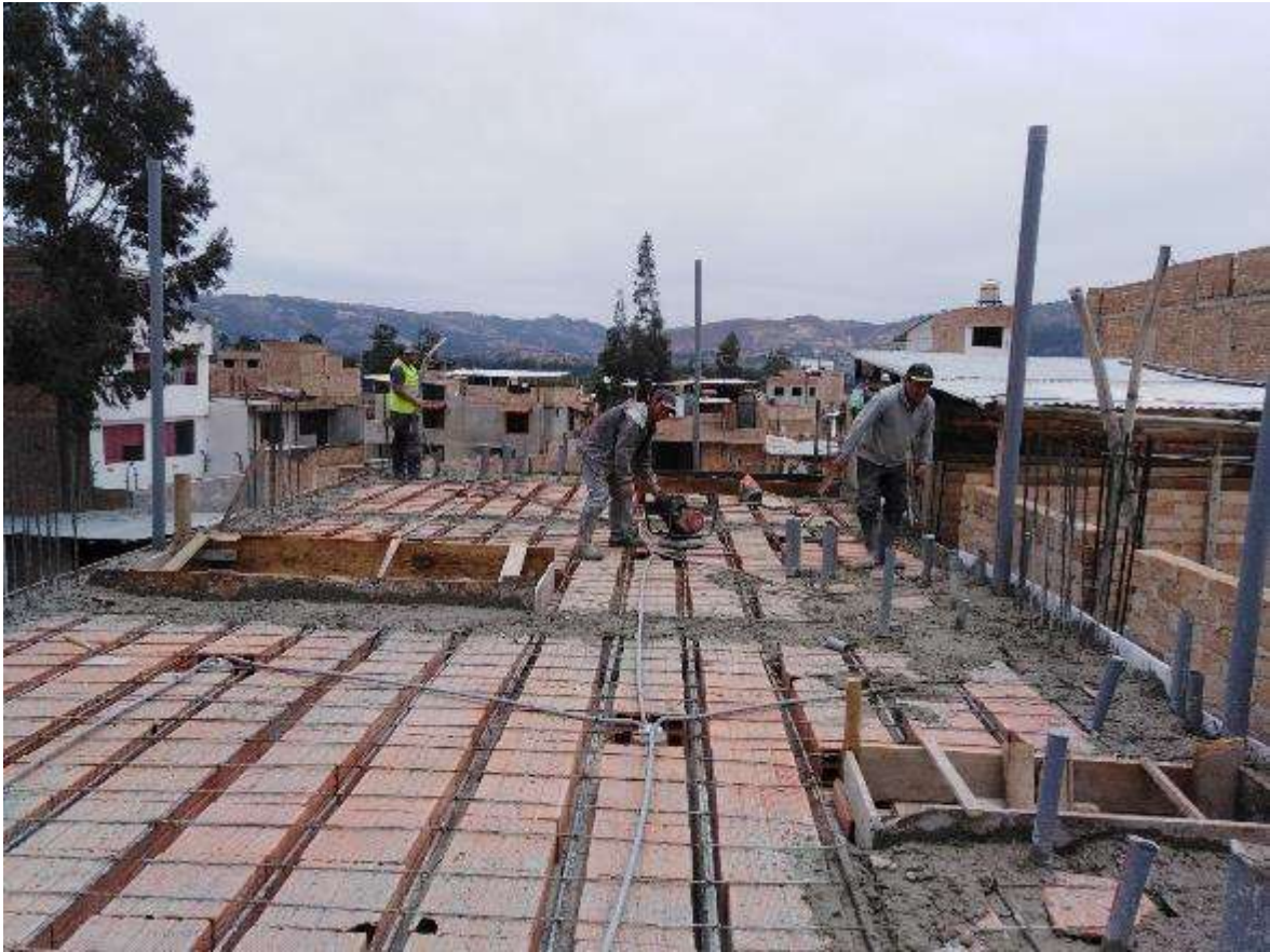
Figura 33. Vaciado de concreto en losa aligerada en elementos estructurales vivienda N° 2.
