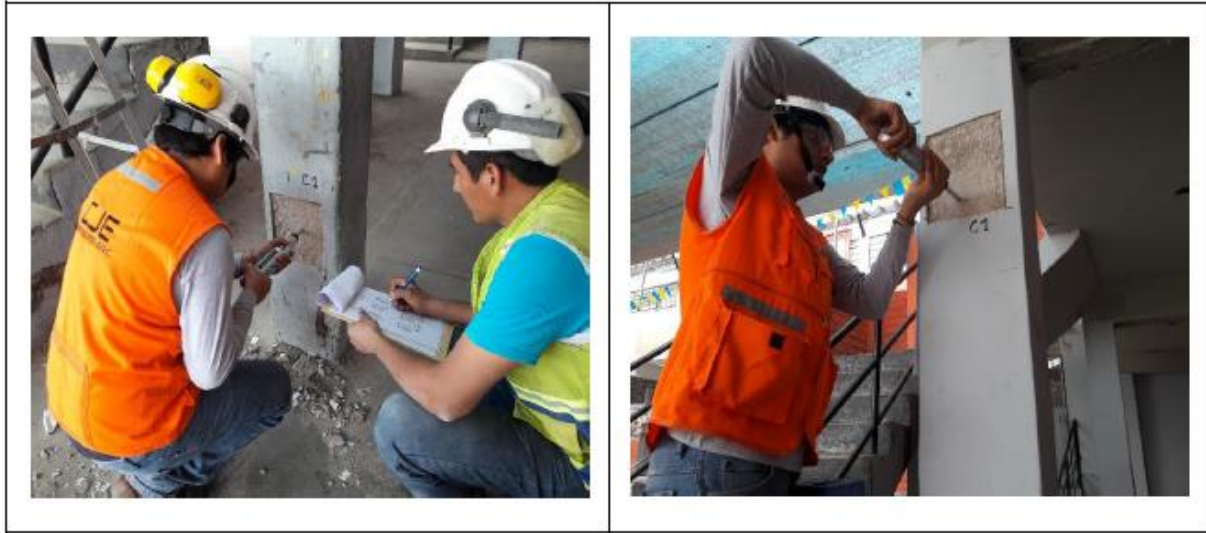
Figura 52: Ensayo de Esclerometría – Columna 1
