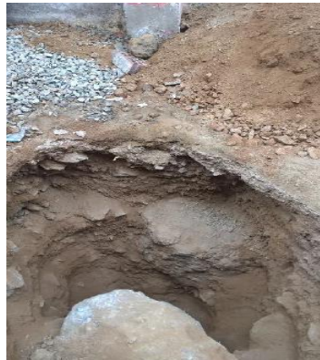
Figura 34: Exploración de la Calicata C-1
