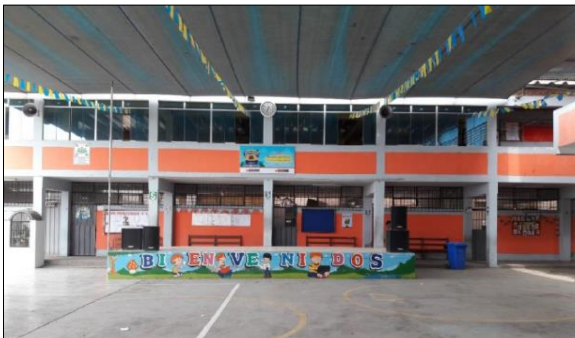
Figura 10: Estructura de 2 niveles, denominada Pabellón 03 – Escuela Primaria EL PROGRESO
