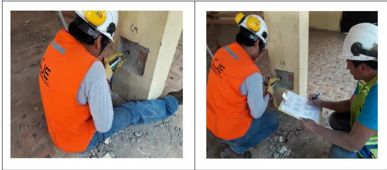
Figura 63: Ensayo de Esclerometría – Columna 4
