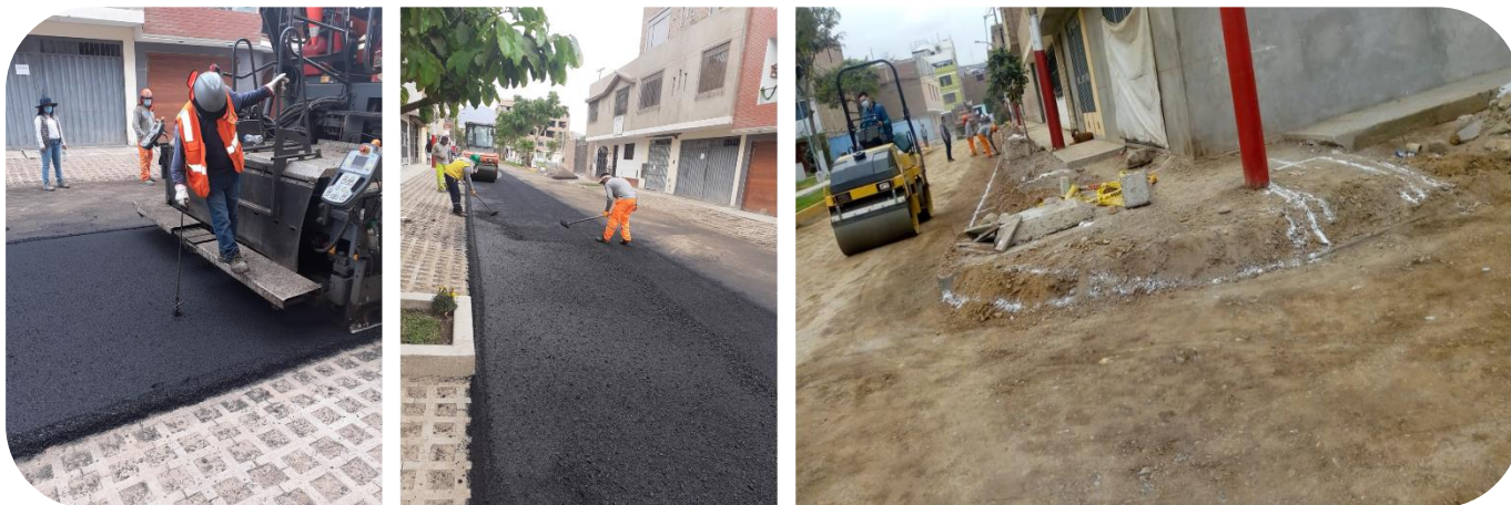
Figura 1: Pavimentación de calles en la asociación de vivienda valle del naranjal
