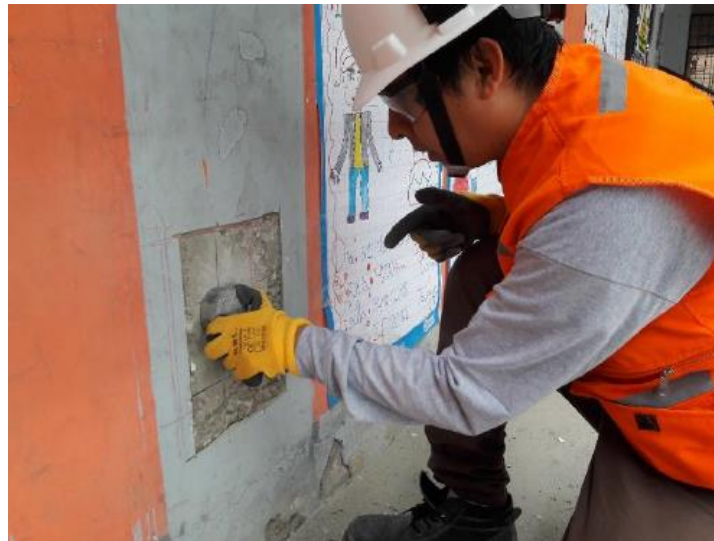
Figura 41: Proceso de Pulido y Limpieza en la zona libre de incidencia de varillas o estribos con la piedra abrasiva (preparación de superficie)
