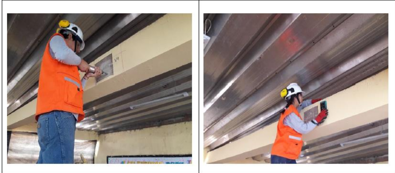
Figura 65: Ensayo de Esclerometría – Viga 4
