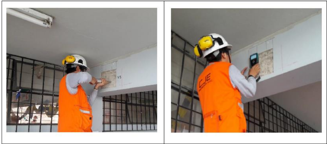
Figura 61: Ensayo de Esclerometría – Viga 3
