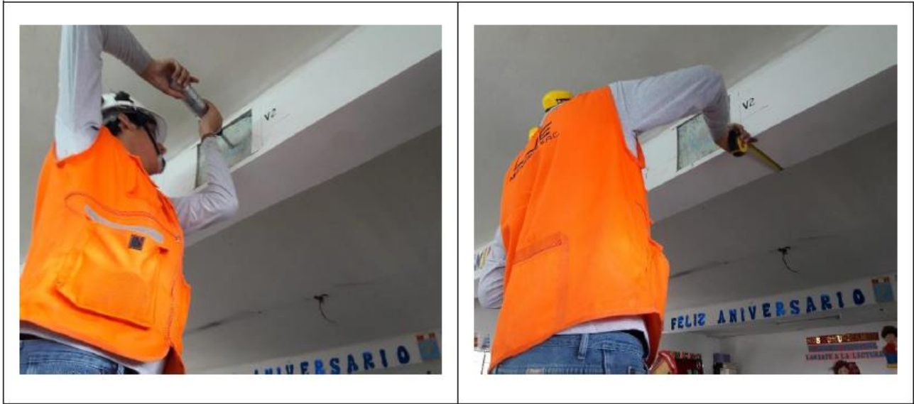
Figura 57: Ensayo de Esclerometría – Viga 2
