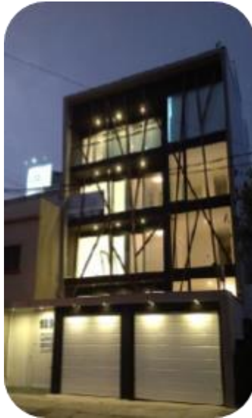
Figura 6: Edificio Enrique Meigss, Miraflores Lima
