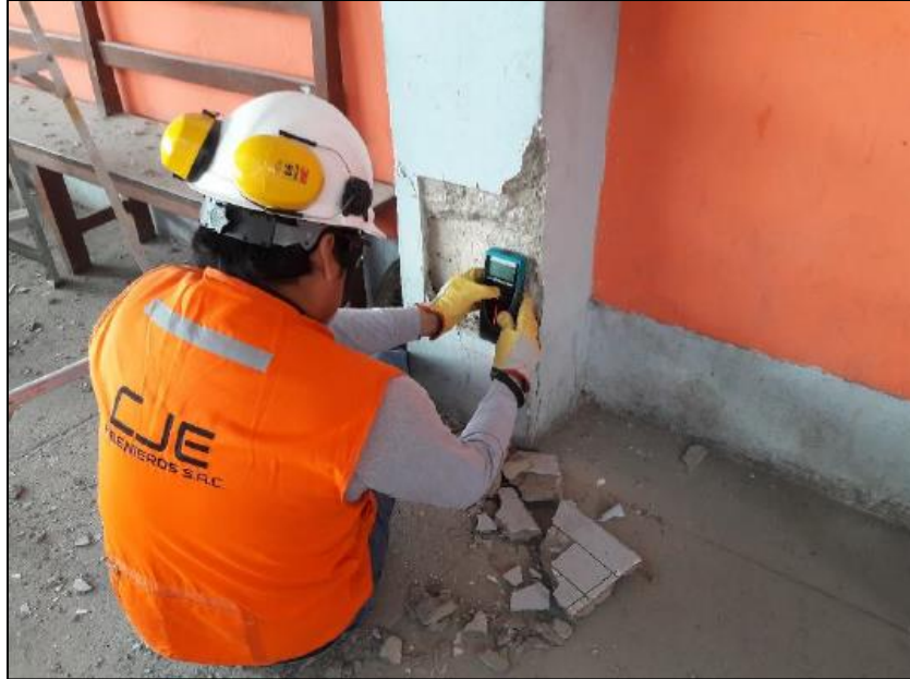
Figura 13: Proceso de escaneo y/o identificación de los refuerzos longitudinal y transversal de vigas y columnas
