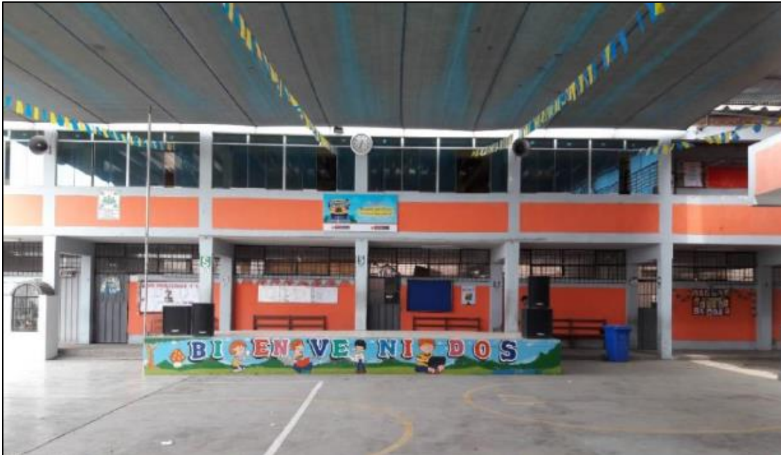
Figura 31: Estructura de 2 niveles, denominada Pabellón 03 – Escuela Primaria EL PROGRESO
