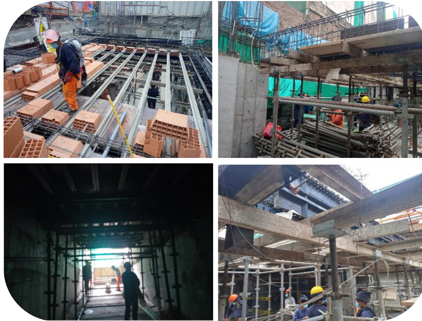
Figura 7: Trabajo en Obra Construcción de Edificio Multifamiliar en Lince
