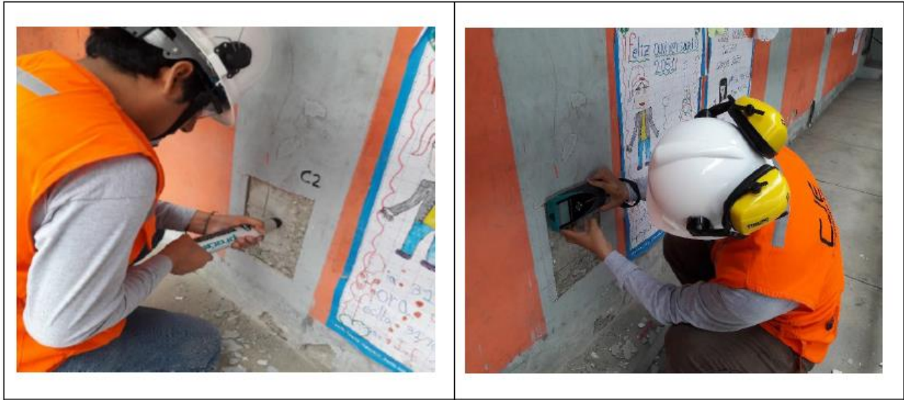
Figura 55: Ensayo de Esclerometría – Columna 2
