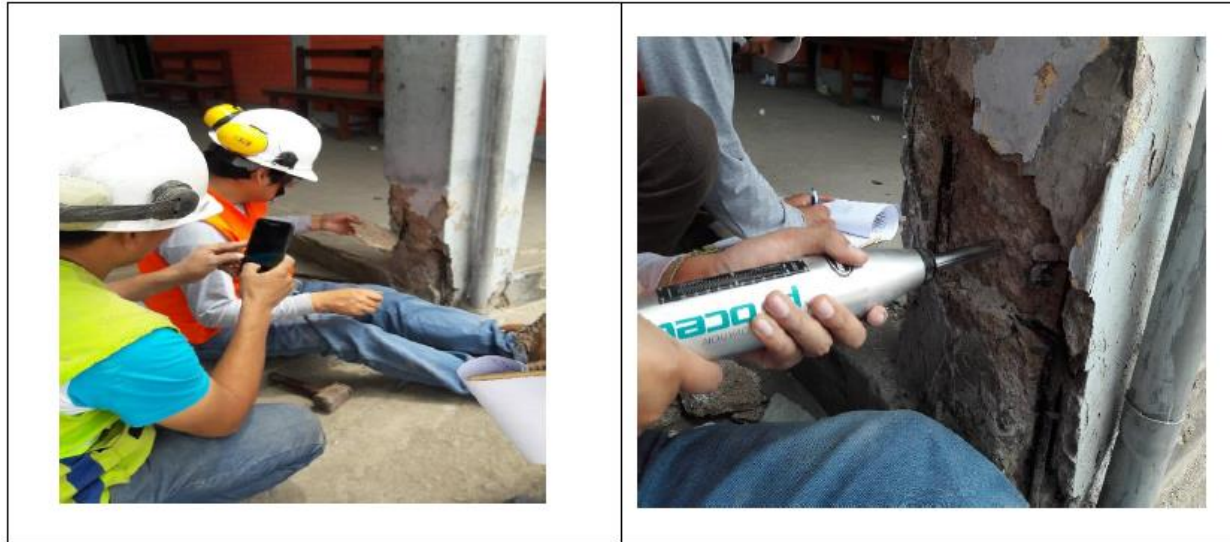
Figura 67: Ensayo de Esclerometría – Columna 5
