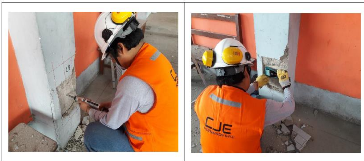
Figura 59: Ensayo de Esclerometría – Columna 3
