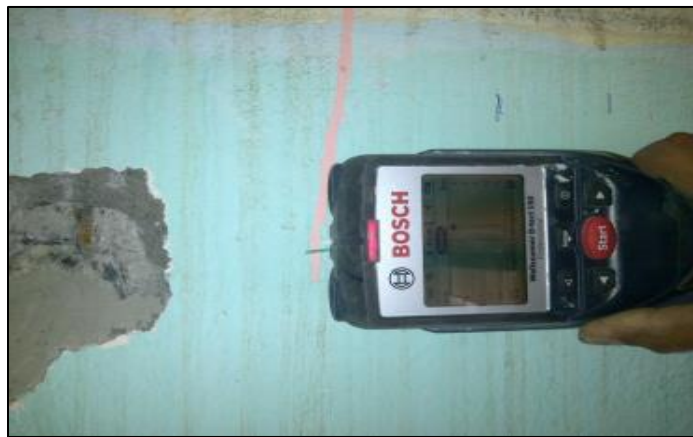
Figura 27: Mapeo de armaduras en elementos estructurales
