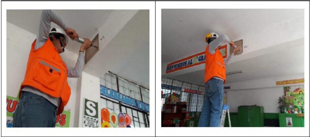
Figura 53: Ensayo de Esclerometría – Viga 1
