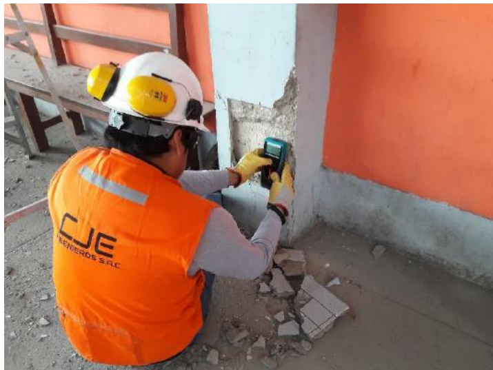
Figura 39: Proceso de escaneo y/o identificación de los refuerzos longitudinal y transversal de vigas y columnas
