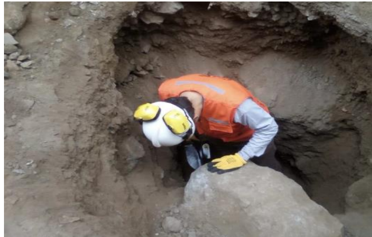
Figura 32: Identificación y reconocimiento de calicata C-1
