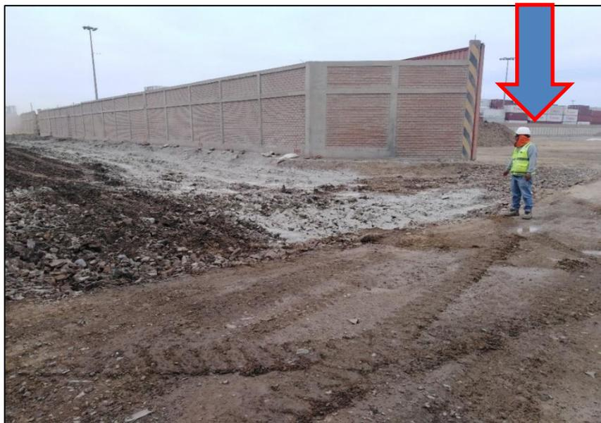
*Figura 40.* Supervisión del cemento agregado al suelo.
