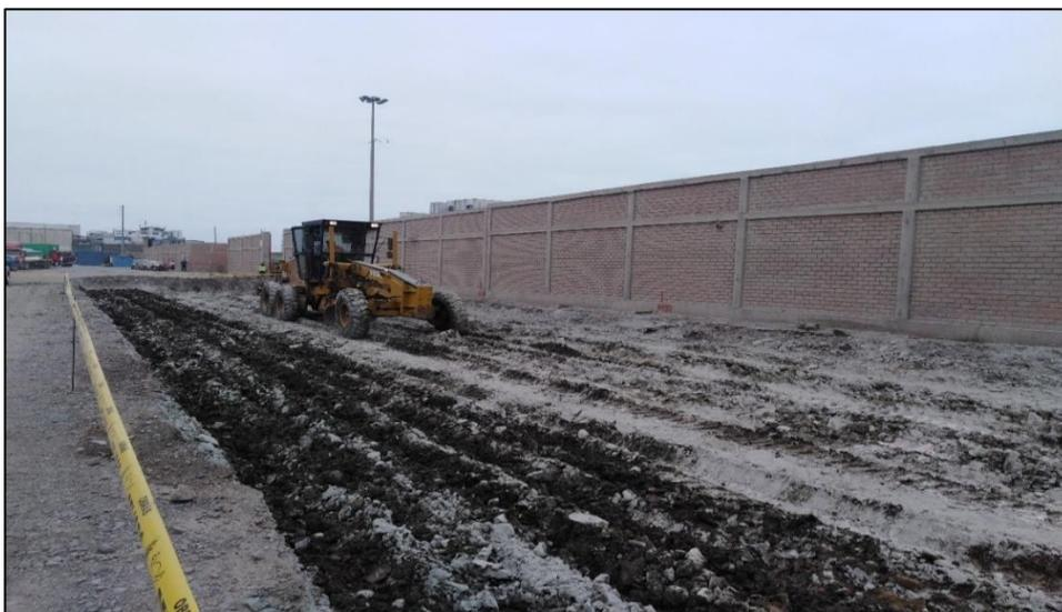
*Figura 46.* Escarificado de cemento con el suelo tercera capa.
