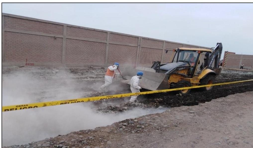
Figura 43. Vaciado de cemento al suelo tercera capa.
