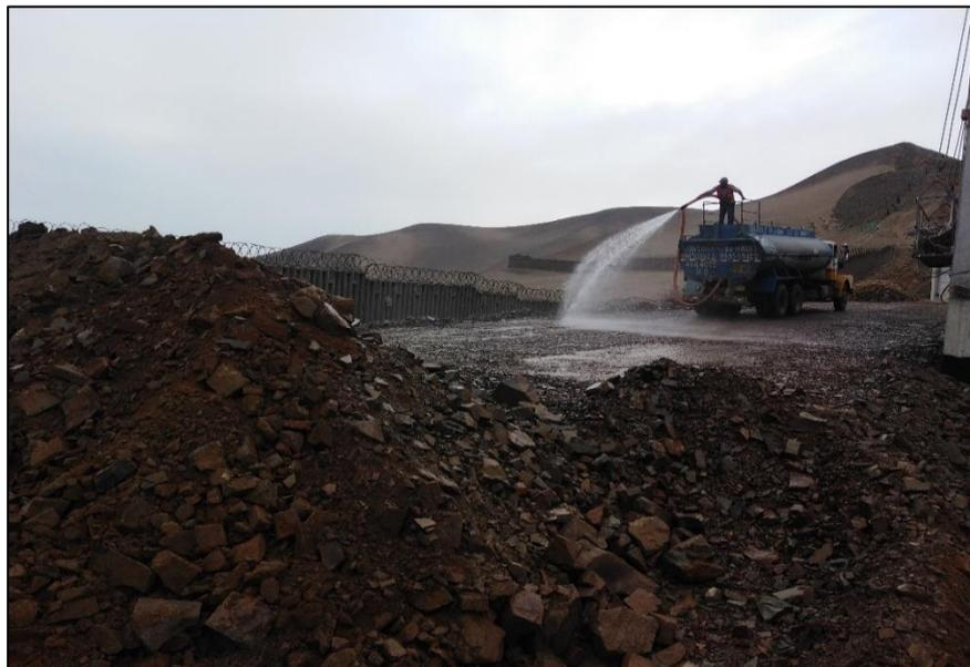
*Figura 39.* Regado de la segunda capa compactada.
