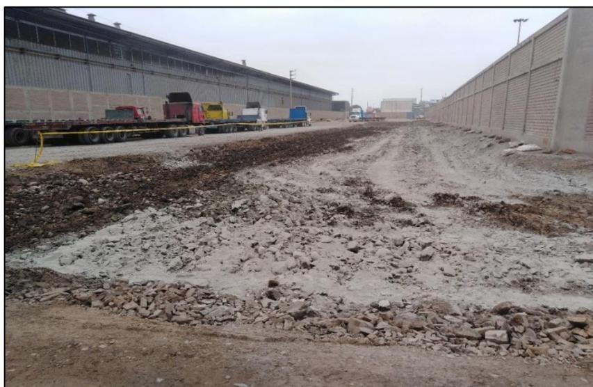
*Figura 41.* Agregado del cemento en la segunda capa de suelo.
