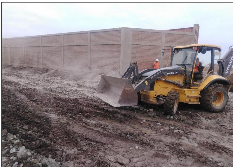
*Figura 6.* Esparcimiento del cemento en la Av. Oquendo.
