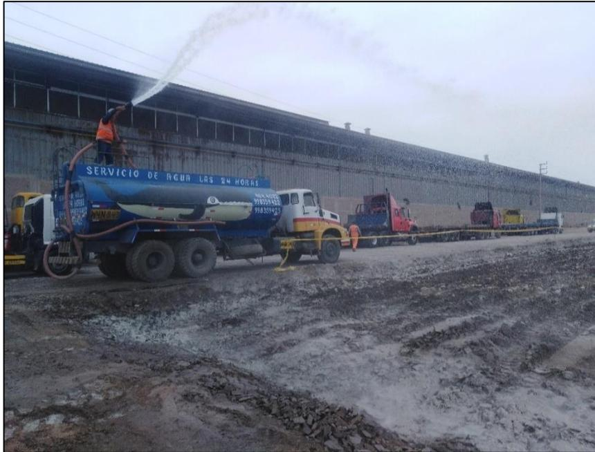
*Figura 38.* Regado con agua al material escarificado.
