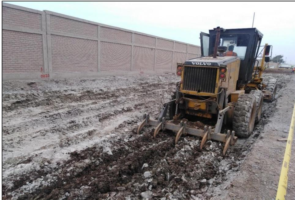
*Figura 36.* Mezclado de material con cemento.
