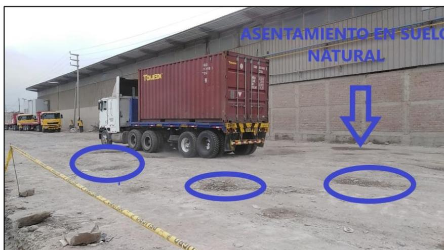
Figura 2. Asentamiento en suelos natural de Av. Oquendo.
