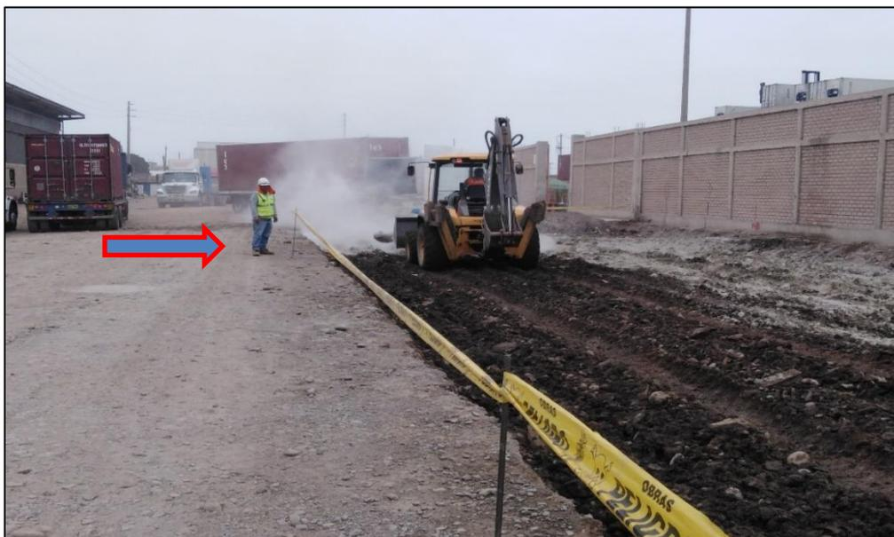
Figura 42. Verificación del mezclado de cemento con el suelo.
