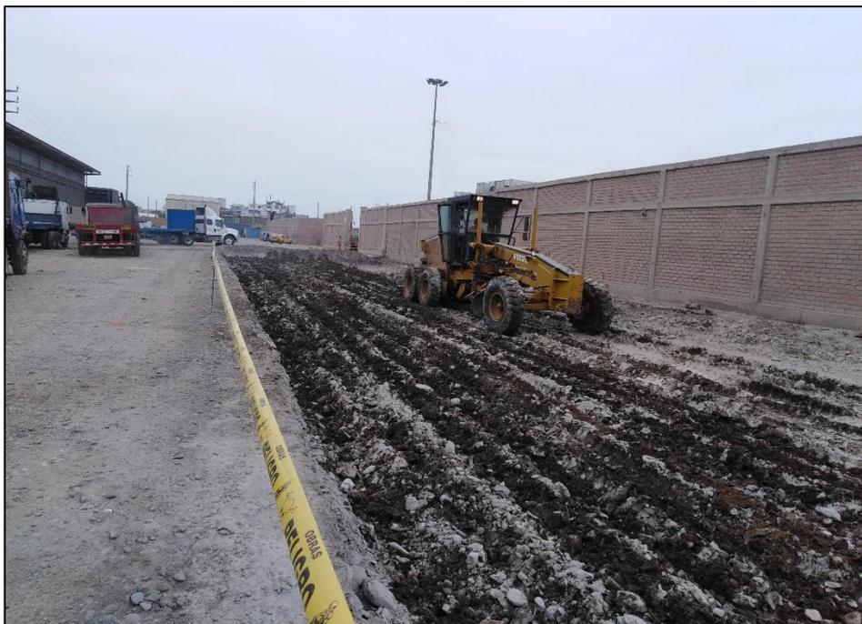
*Figura 4.* Escarificado en la Av. Oquendo.
