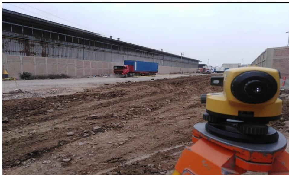
*Figura 47.* Nivelación topográfica de la tercera capa.
