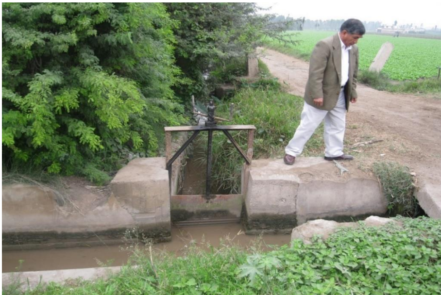
Figura 36: Tomas laterales con compuerta tipo izaje
