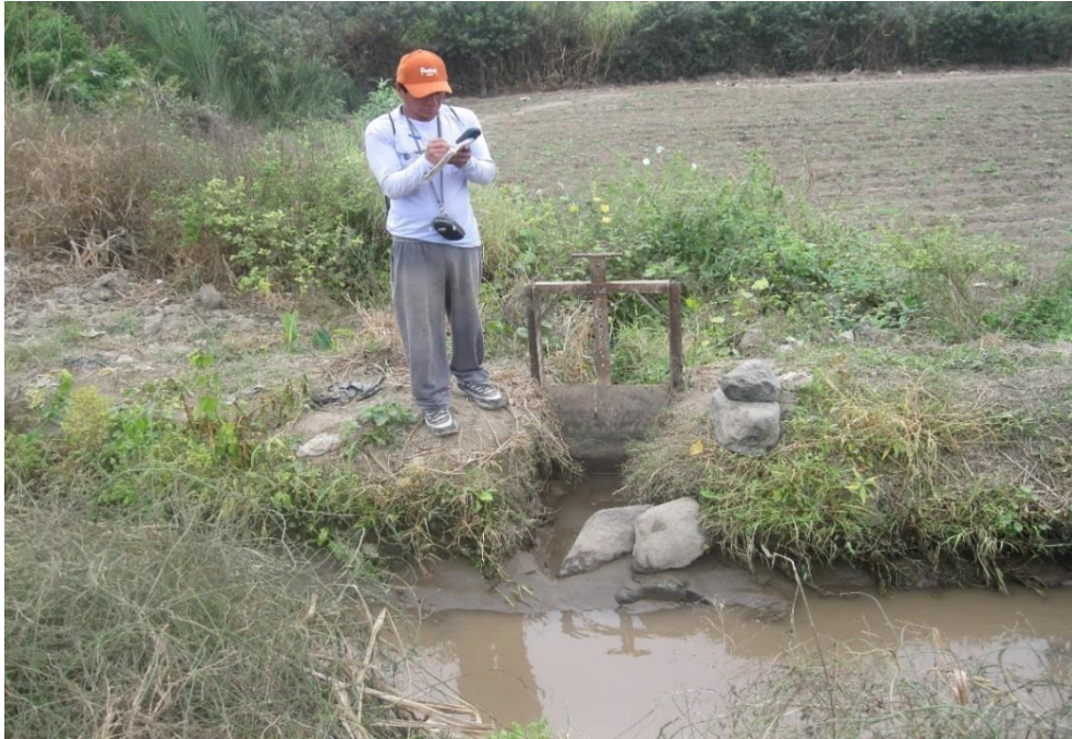
Figura 37: Tomas laterales con compuerta tipo izaje
