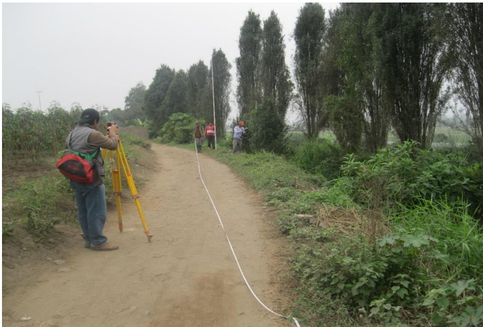
Figura 34: Levantamiento topográfico del Canal Rústico de Santa Elena Fuente: Junta de Usuarios Chancay - Huaral
