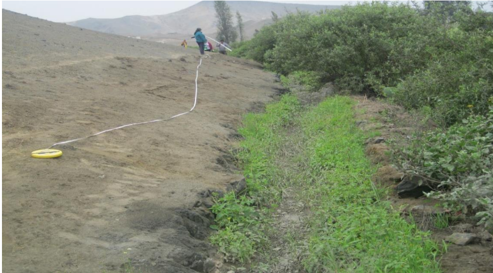
Figura 35: Tramo de canal en ladera de cerro con material rocoso
