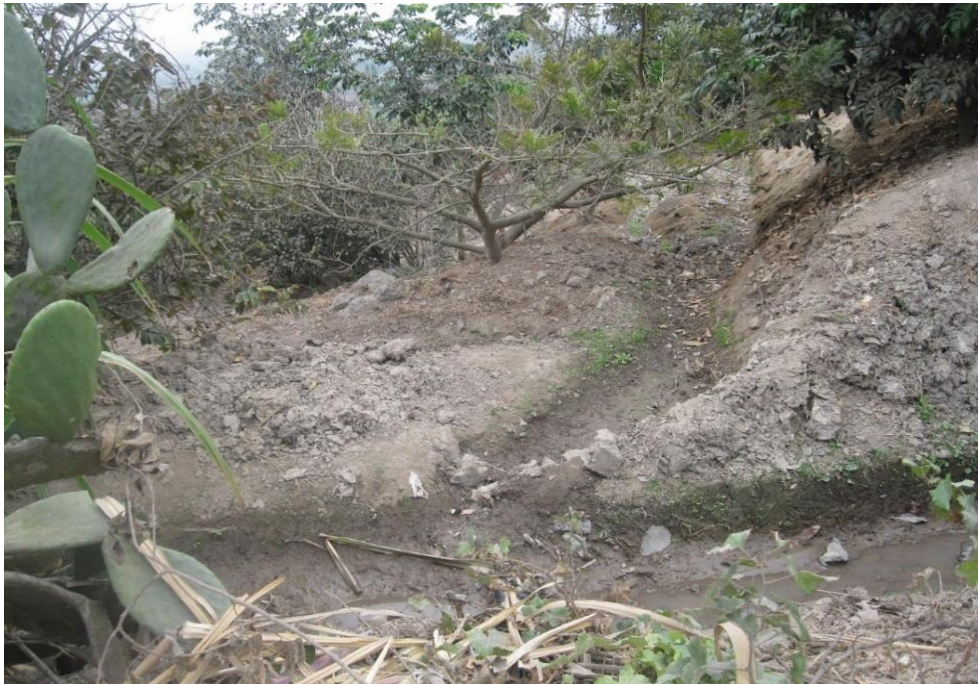
Figura 34: Toma lateral rústica a ser mejorada del Canal de Santa Elena
