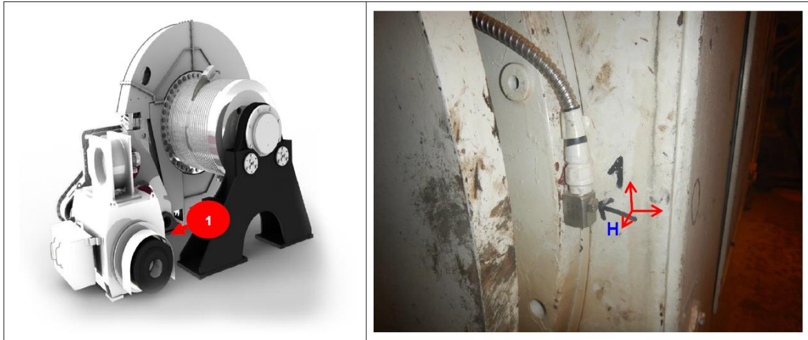
Figura 57. Instalación de sensores. Fuente: Southern Perú (2020)
