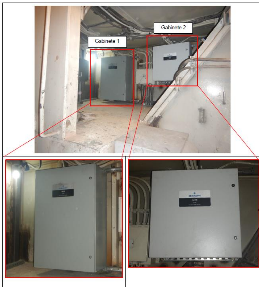
Figura 58. Instalación de gabinetes. Fuente: Southern Perú (2020)
