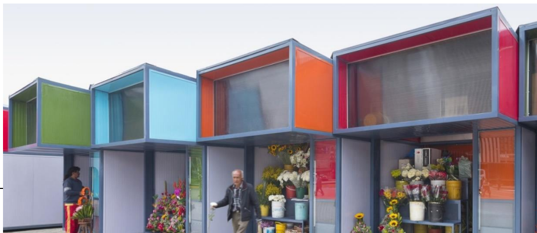
Ilustración 4: Vista de fachada del Mercado flores 23
