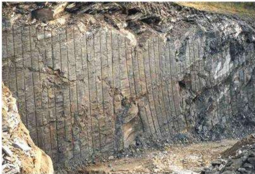
Figura 7: Trayectoria de taladros de perforados.
