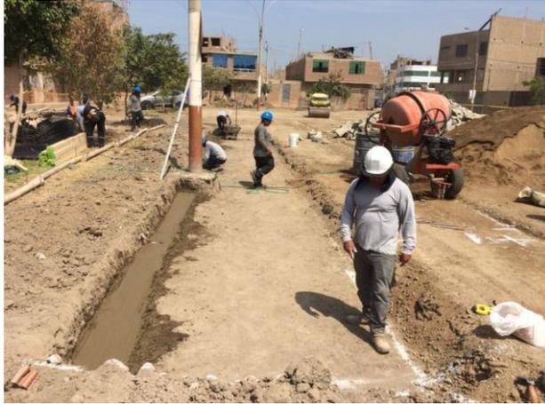
**Figura 50: Conformación de subrasante en graderías**
