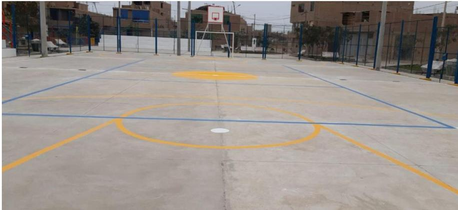
**Figura 47: Pintura de líneas en losa**
