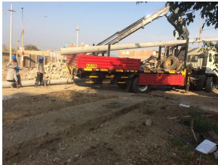
**Figura 60: Izaje de postes eléctricos para reflectores**
