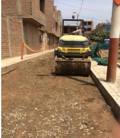
**Figura 21: Compactación de base granular para veredas.**
