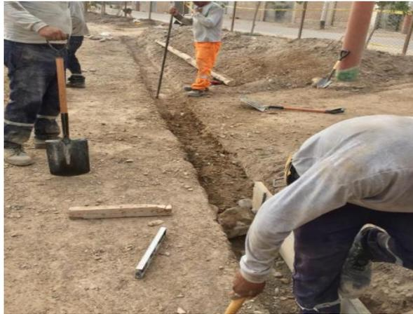
**Figura 17: Excavación de zanja para sardineles.**
