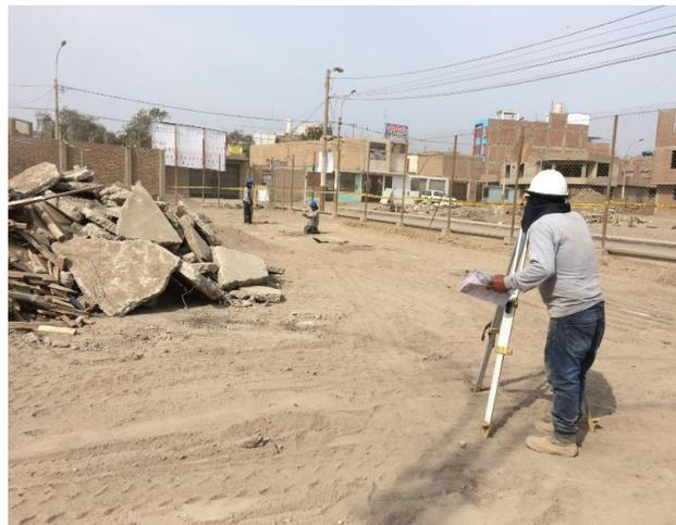
**Figura 11: Replanteo de niveles con equipo.**
