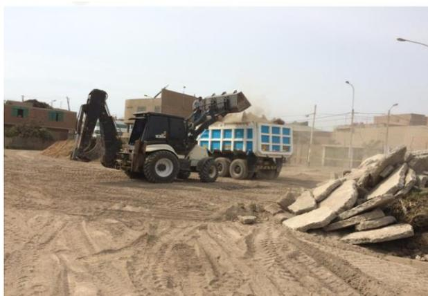
**Figura 18: Eliminación de material excedente.**
