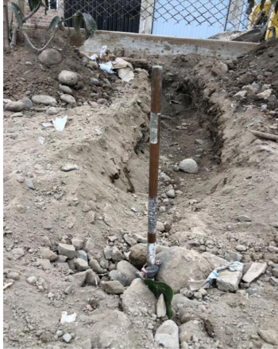
**Figura 61: Instalación de puesta a tierra**
