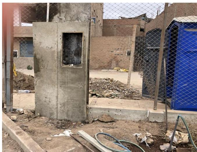
**Figura 59: Muro para tablero eléctrico y medidor**
