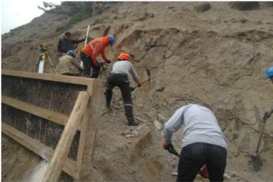
Figura 00. Corte manual para cimiento de Muro, 2018, obra A.F 9 de febrero
