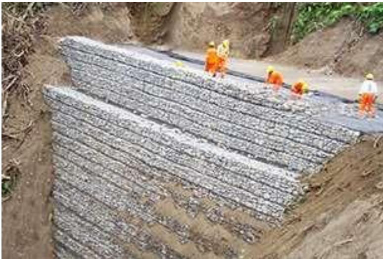
Figura 00. Muro de suelo reforzado con Geo mallas, TDM S.A .Perú 2018, Tomado de
