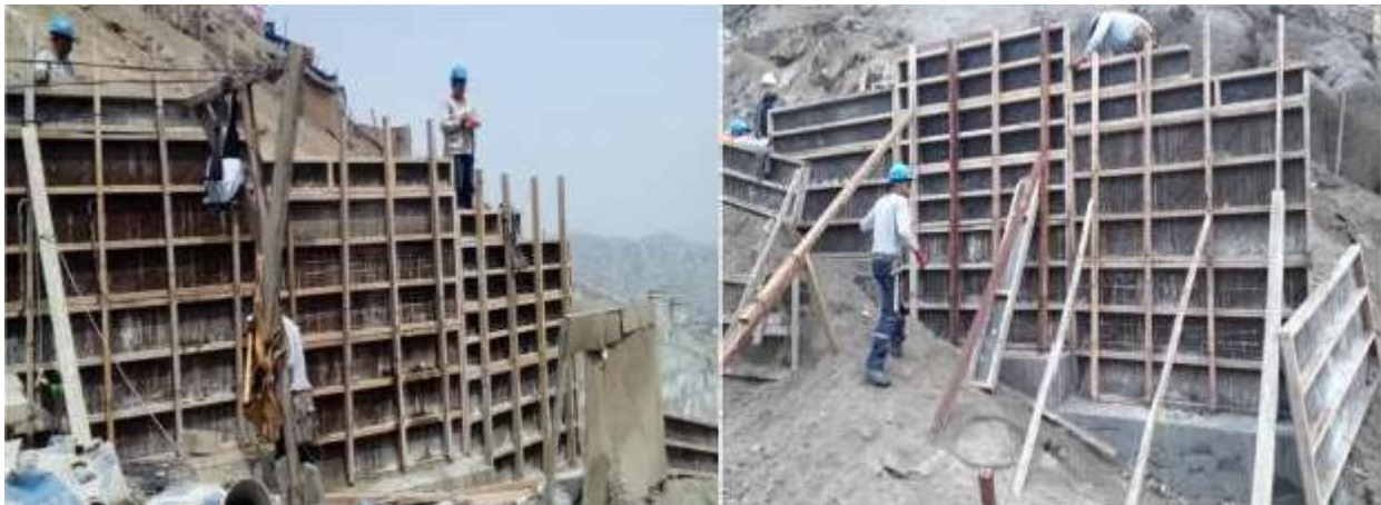
Figura: Encofrado y desencofrado de muro, 2018, obra A.F 9 de febrero
