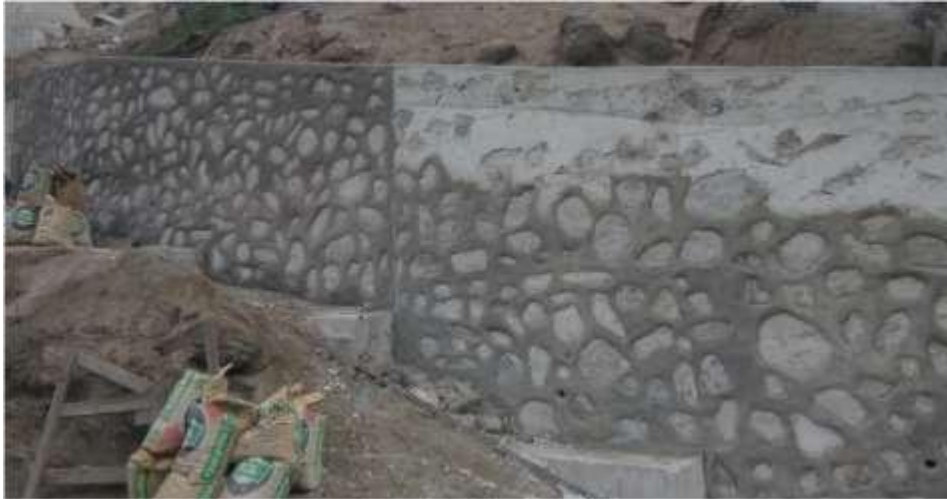
Muro concreto ciclopeo; Obra: “Creación de Muro de Contención en el psje. 17 Frente a las Mz E y F de la A.f. 9 de Febrero, Comuna 11, Distrito de San Juan de Lurigancho, Lima – Lima”
