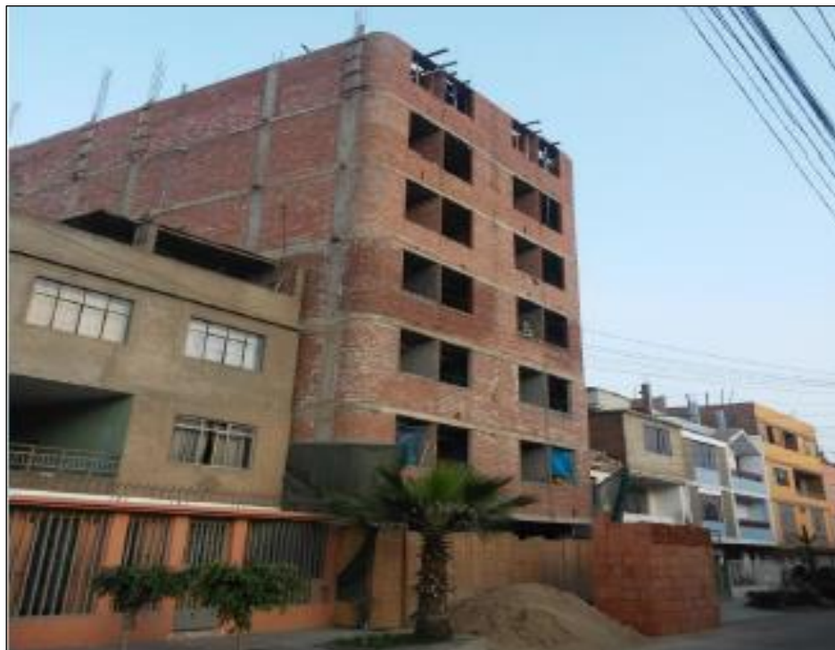
Figura 13. Demolición y construcción de departamentos en SJL-Lima
