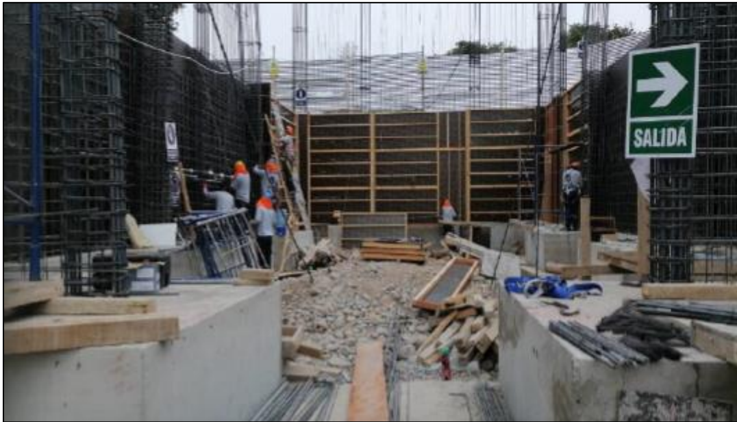
Figura 6. Encofrado de Placas
