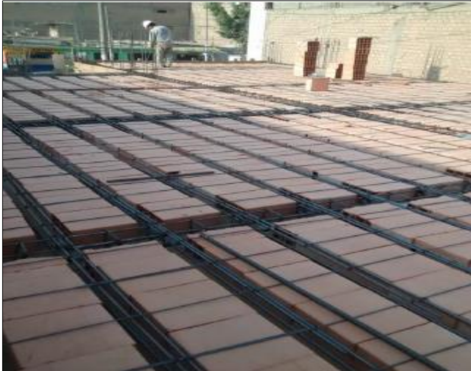
Figura 16. Techo aligerado antes del vaciado de concreto
