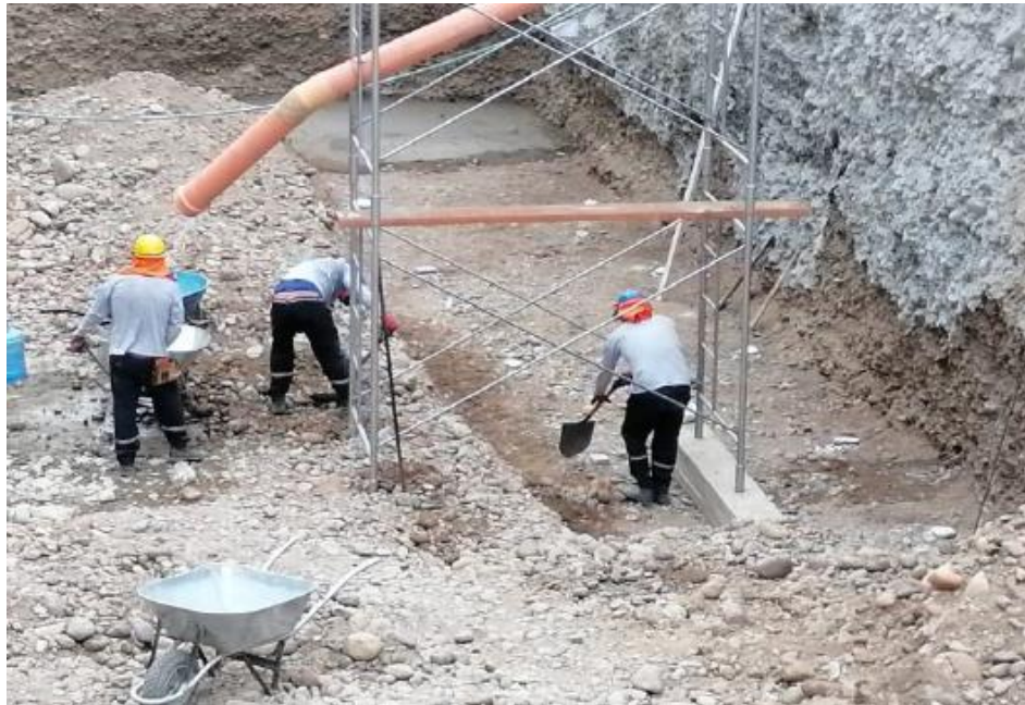
Figura 4. Vaciado de concreto en cimentación
