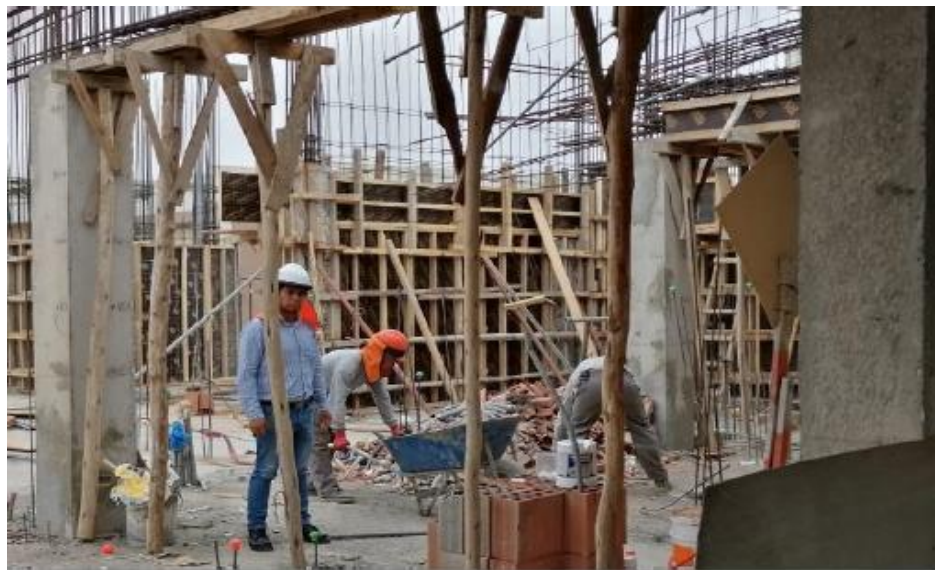
Figura 5. Desencofrado de columnas
