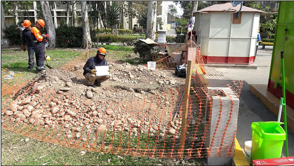
Foto 1: Vista de ubicación de la calicata C-01
