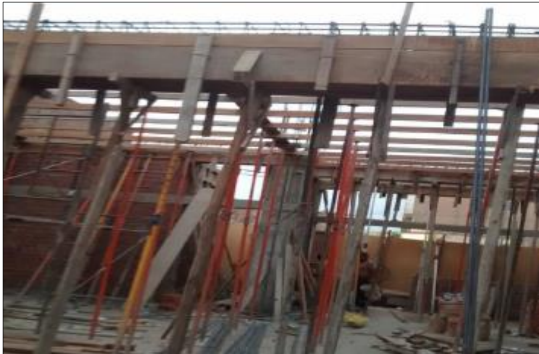
Figura 15. Encofrado de vigas
