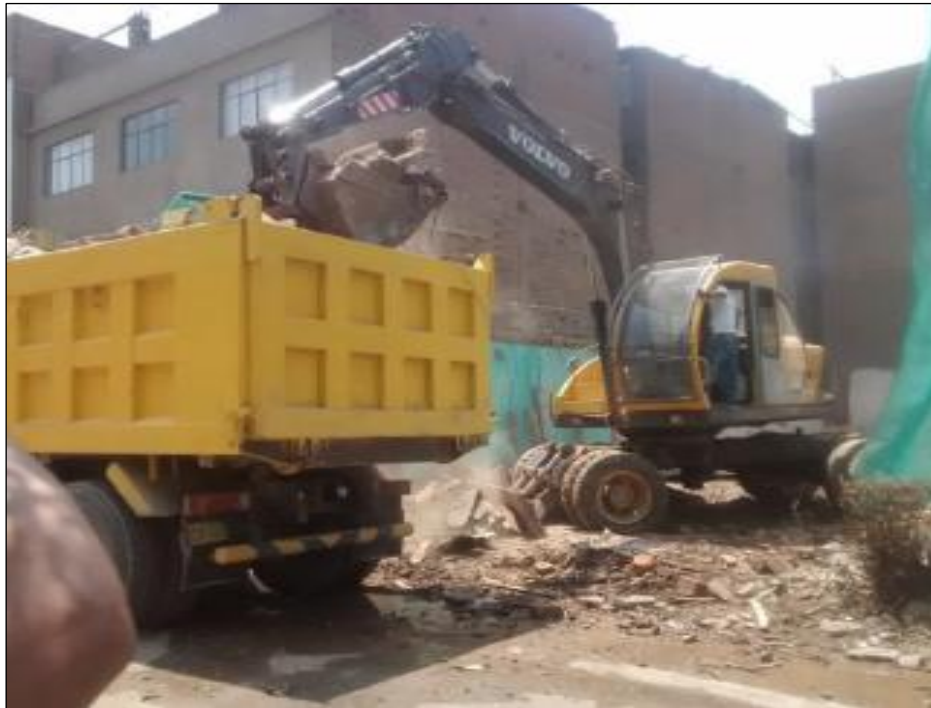
Figura 12. Demolición y construcción de departamentos en SJL-Lima
