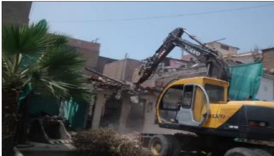
Figura 11. Demolición y construcción de departamentos en SJL-Lima
