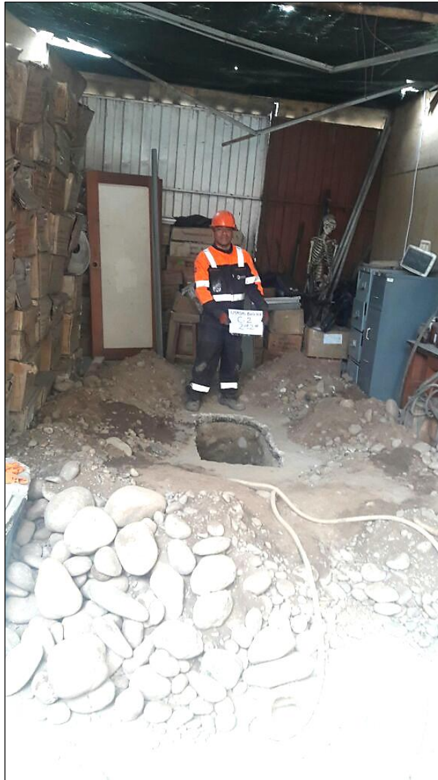
Foto 3: Vista de ubicación de la calicata C-02
