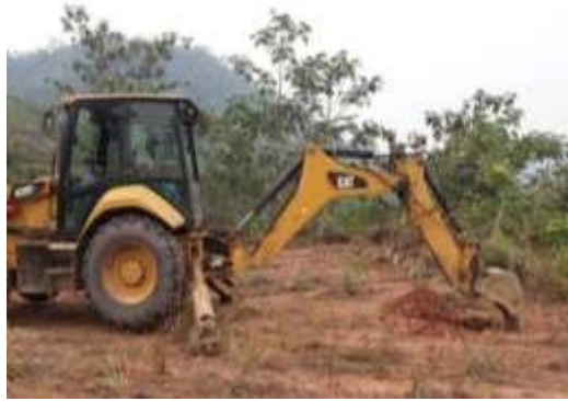
Evaluación de cantera coluvial con apoyo de equipo mecánico (Retroexcavadora) Cantera Ampliación arco Iris
