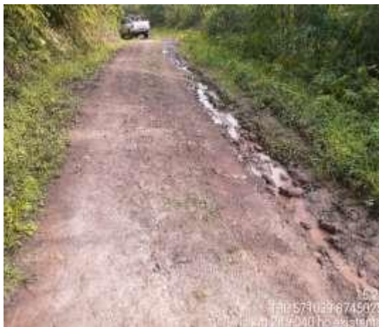
Reconocimiento del tramo de proyecto
